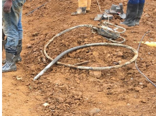
Figura N° 8. Vibrador de Concreto. Fuente Propia.
