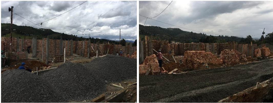
Figura N° 35. Material para Capa Base Calle B - D. Fuente Propia.
