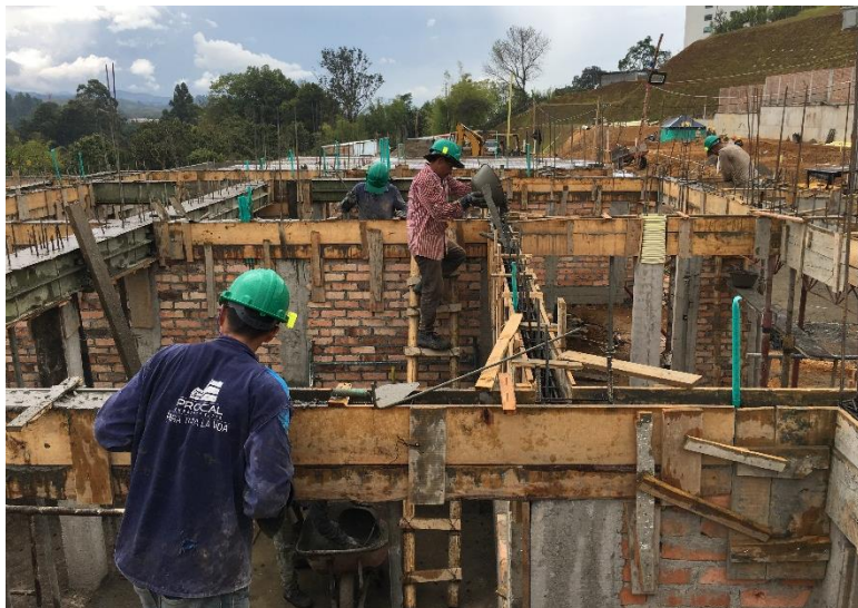
Figura N° 14. Fundición de Vigas, Casa 3 y 4 Manzana B. Fuente Propia.
