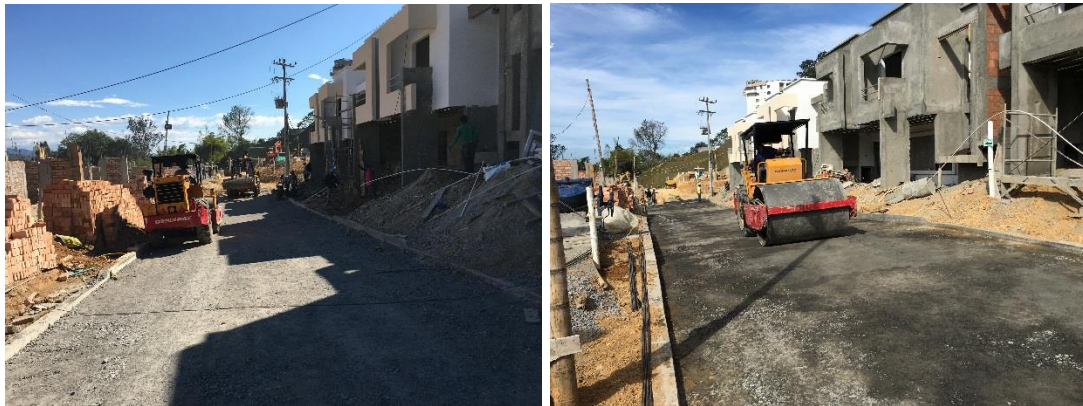
Figura N° 36. Compactación de Capa Base Calle B - D. Fuente Propia.
