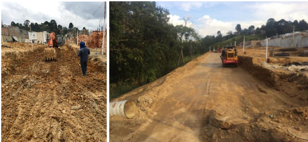
Figura N° 34. Cajeo y Compactación Subrasante, Calle C - E y Calle A. Fuente Propia.
