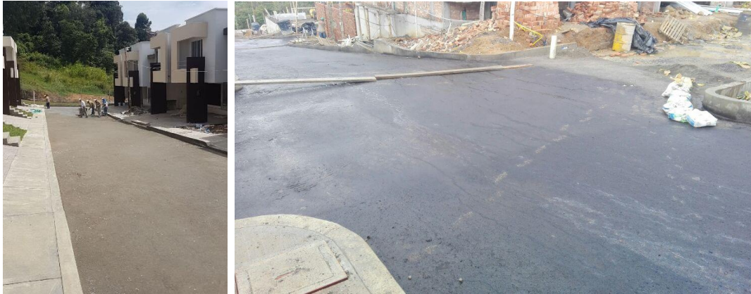
Figura N° 37. Limpieza e Imprimación entre Calle D - F. Fuente Propia.
