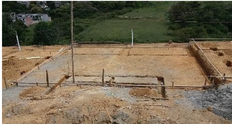
Figura N° 4. Excavación de Zapatas, Casas 13 y 14 Manzana C. Fuente Propia.
