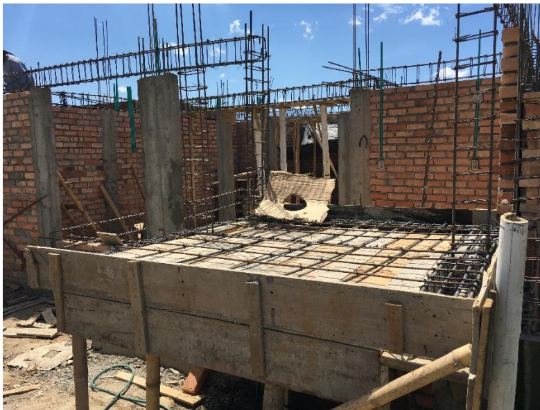
Figura N° 16. Detalle Vigas Descanso de Gradass, Casa 3 Manzana B. Fuente Propia.
