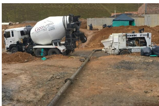
Figura N° 28. Detalle de Mixer, Bomba de Concreto y Comprobante de Entrega. Fuente Propia.
