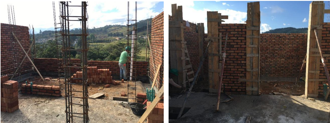
Figura N° 12. Muros y Columnas, Casas 9 y 10 Manzana B. Fuente Propia.
