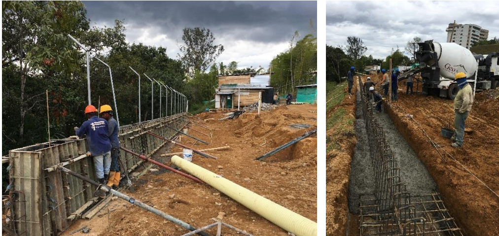
Figura N° 32. Colocación de Tubos para Cerramiento y Fundición de Tramo Final de Zarpa. Fuente Propia
