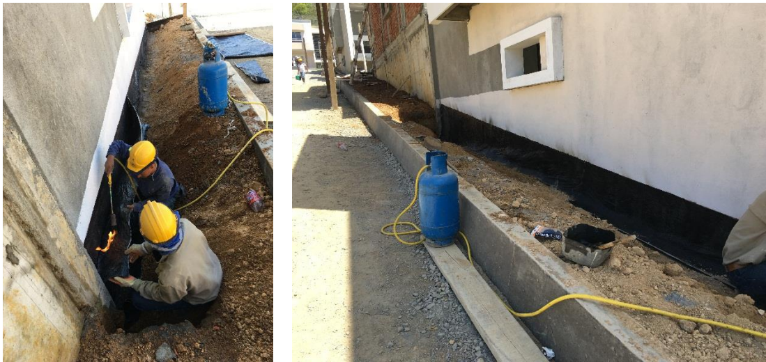
Figura N° 22. Impermeabilización de Fachada, Casa 1 Manzana D. Fuente Propia.
