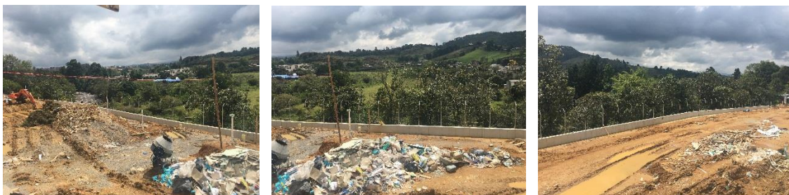
Figura N° 33. Culminación de Muro de Contención Vía Interna. Fuente Propia.
