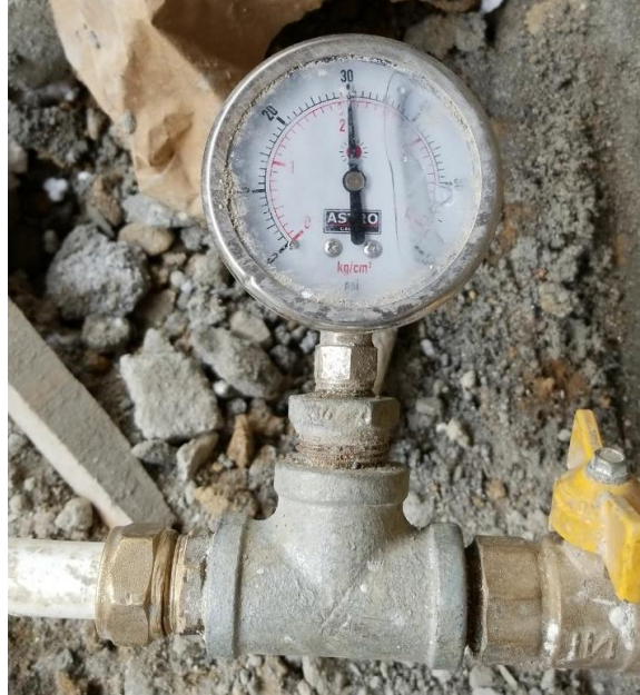
Figura N° 40. Ensayo de hermeticidad. Fuente Propia.
