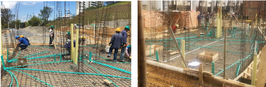
Figura N° 7. Instalación Tubería Electrica, Gas, Agua, Casas 1 y 2 Manzana B. Fuente Propia.
