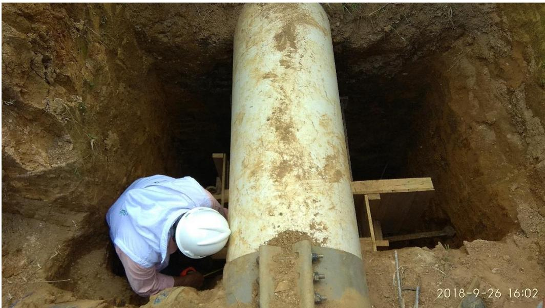
**Figura N° 18.** Verificación de las dimensiones de la sección transversal del encofrado. Fuente Propia.
