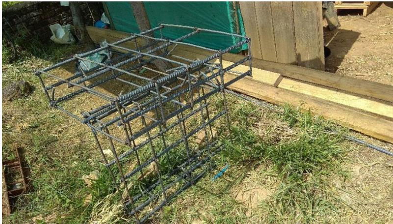
*Figura N° 36. Refuerzo para parte superior de soporte. Fuente Propia.*
