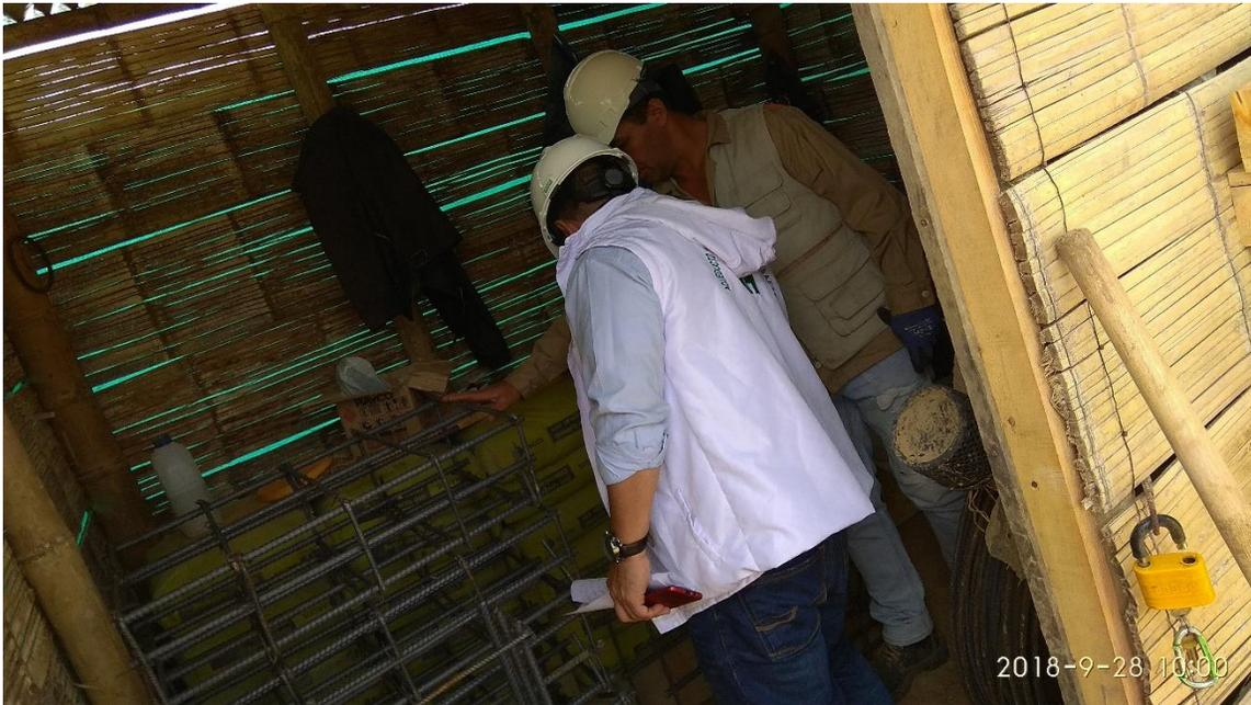
*Figura N° 19. Revisión del refuerzo armado para los soportes. Fuente Propia.*
