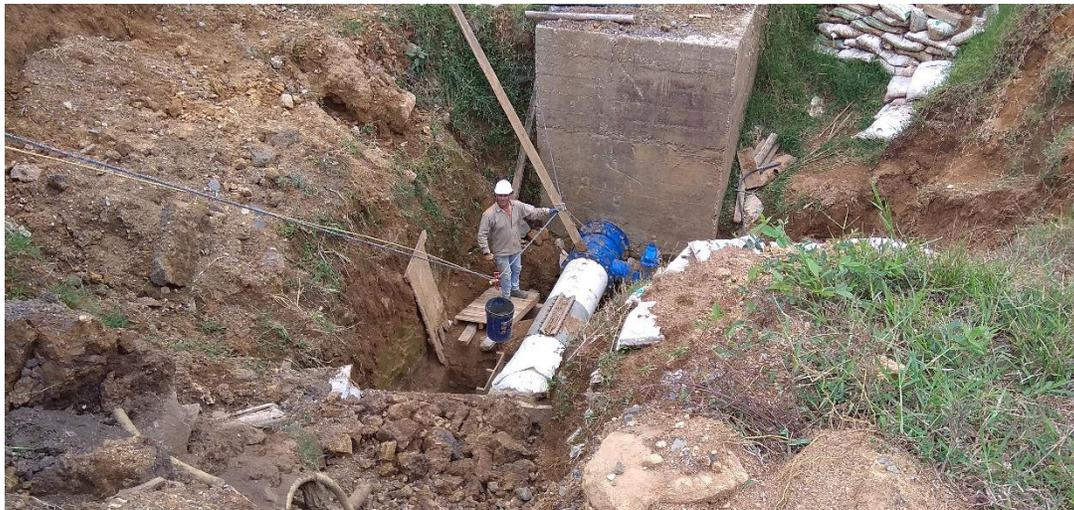
*Figura N° 31. Concreto transportado mediante polea y una cuerda para su posterior vaseado. Fuente Propia.*
