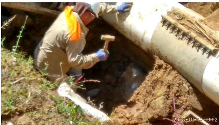
*Figura N° 22. Demolición de rocas encontradas bajo el terreno. Fuente Propia.*
