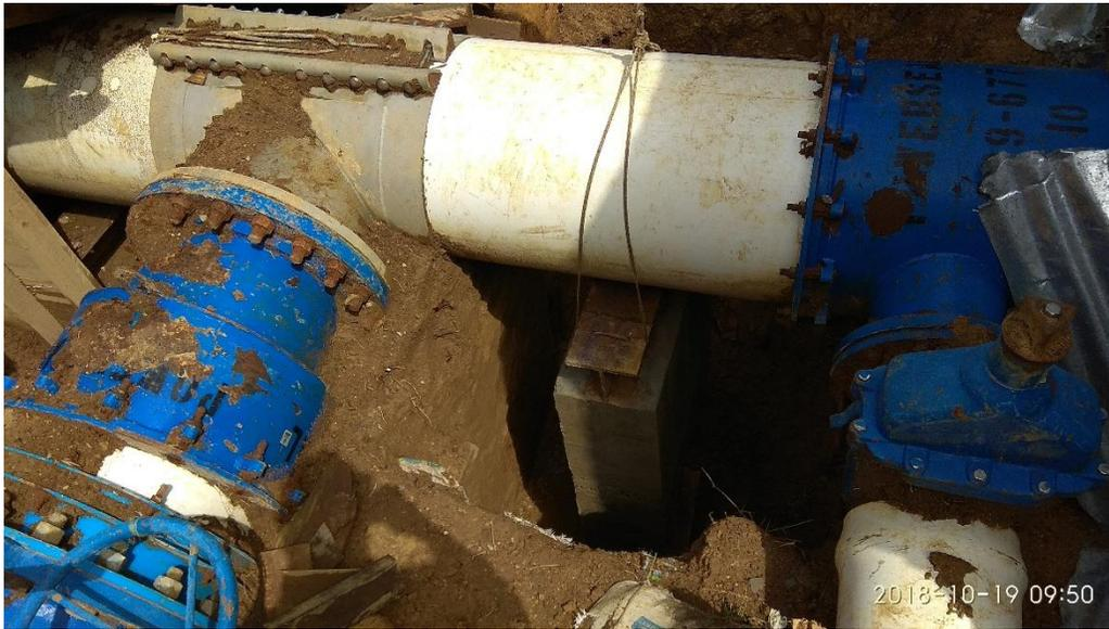
*Figura N° 39. Soportes ya fundido y desencofrado. Fuente Propia.*
