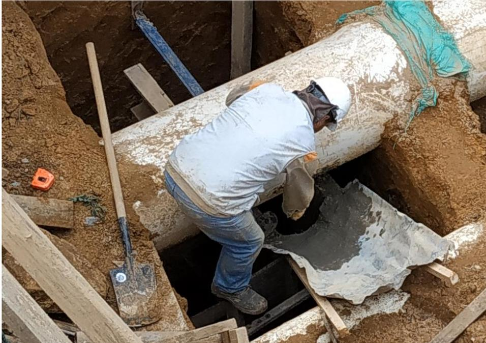
*Figura N° 32. Tolba para el vaciado del concreto en el encofrado. Fuente Propia.*
