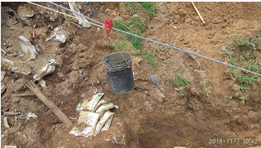
*Figura N° 37. Forma de transportar el concreto hasta el sitio de vaciado. Fuente Propia.*
