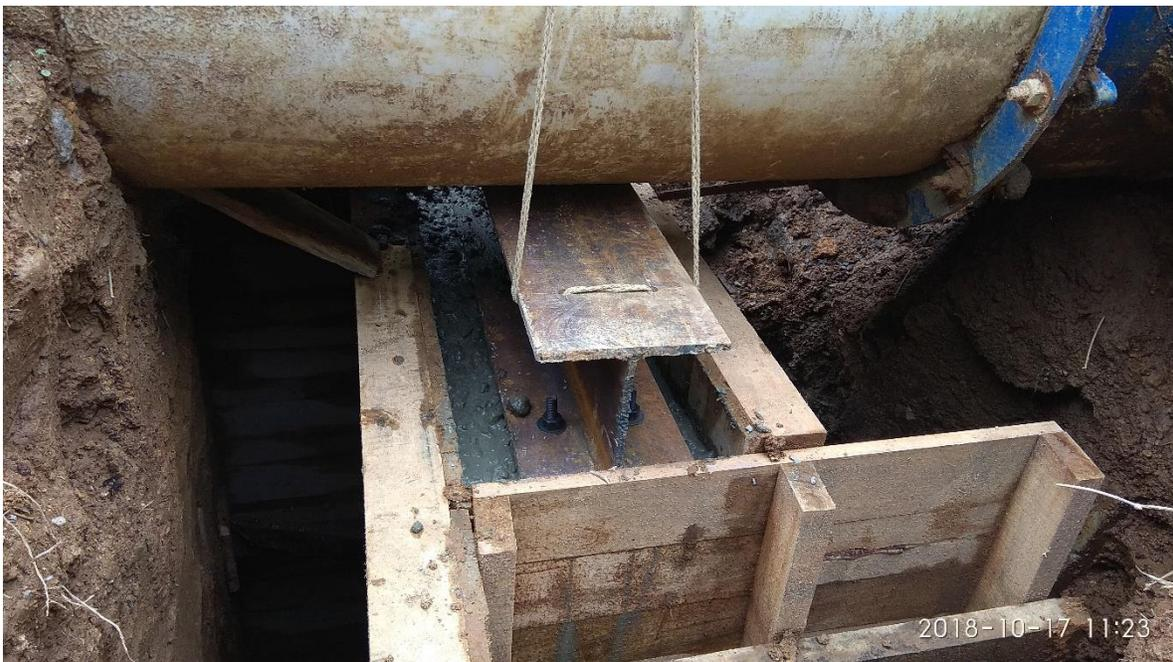
*Figura N° 38. Soporte fundido sin desencofrar. Fuente Propia.*
