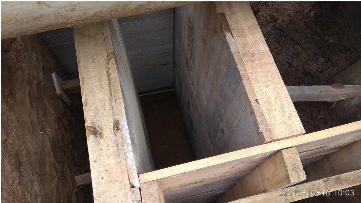
*Figura N° 27. Vista interna de la formaleta donde se apreció el apuntalamiento de los tableros. Fuente Propia*
