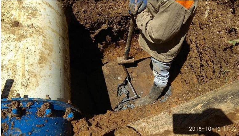
*Figura N° 23. Tapas en concreto reforzado encontradas y demolidas bajo las tuberías. Fuente Propia.*
