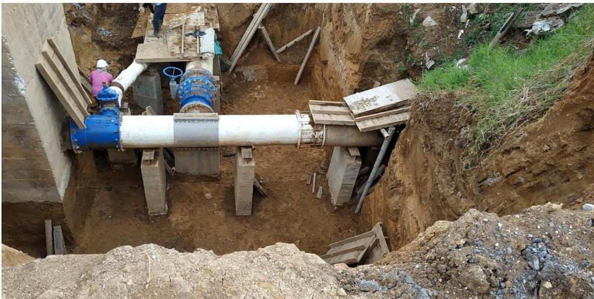
*Figura N° 40. Los 9 soportes ya fundidos. Fuente Propia.*
