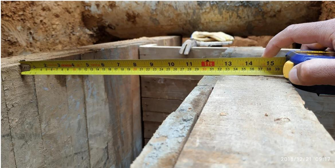
*Figura N° 28. Verificación de la medida de la sección transversal del encofrado. Fuente Propia.*
