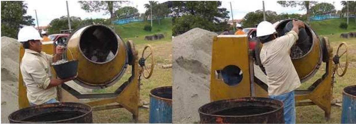
*Figura N° 29. Preparación de la mezcla mecánica del concreto de 3000 psi. Fuente Propia.*
