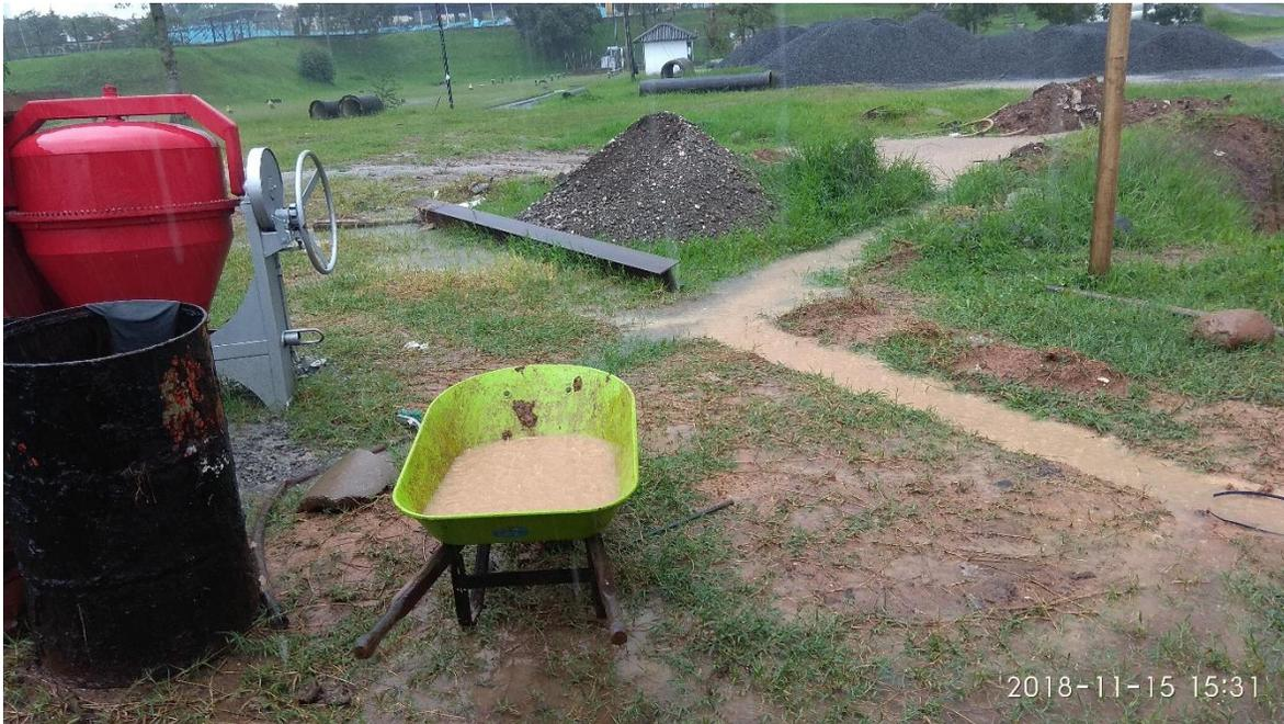
*Figura N° 45. En la imagen se aprecia un día lluvioso, también una de las zangas construidas, la cual evitó que gran parte del agua lluvia ingresara al área de trabajo. Fuente Propia.*
