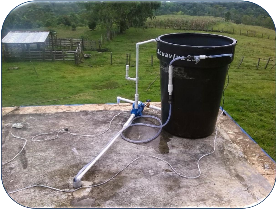
Figura 30. Primera prueba de fugas del sistema de desinfección
