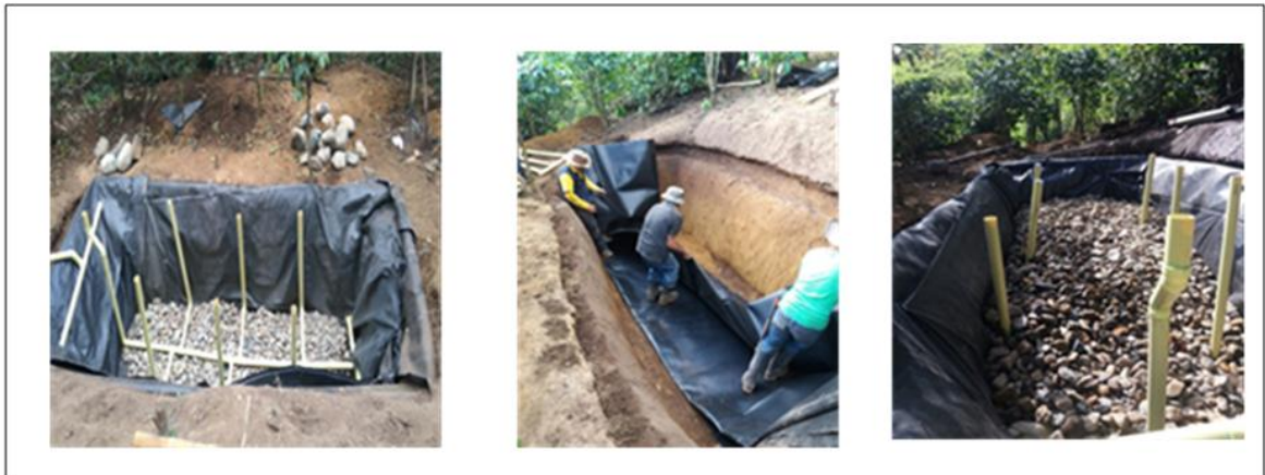
Figura 3. Construcción del humedal horizontal
