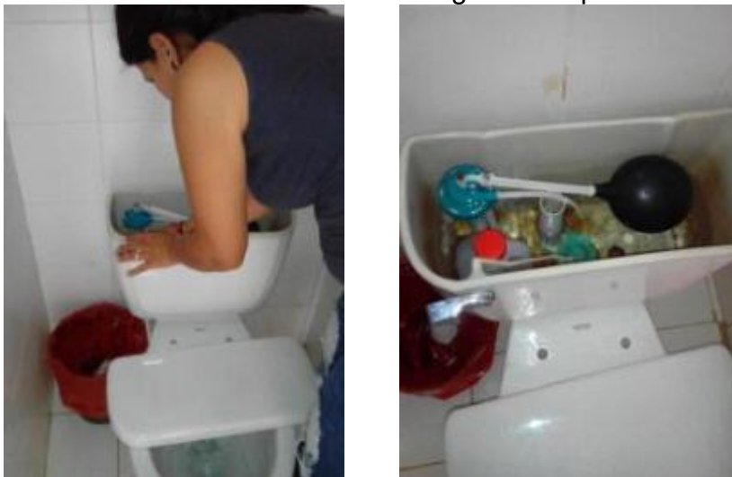
Figura 34. Introducción de botellas de agua a tanques de sanitarios
