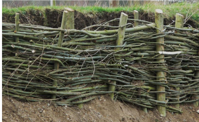
Figura A1. 4. Técnica de Willow Spiling
