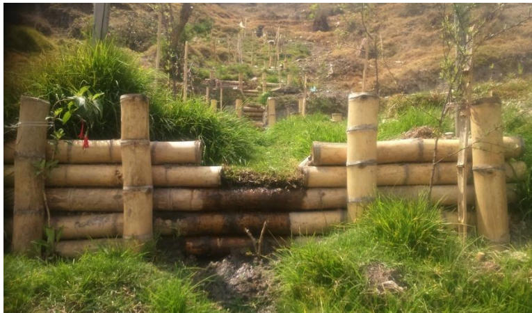
Figura A1. 9. Trinchos de disipación en filtros vivos Fuente: Trabajo de Campo, Cordillera Sur.
