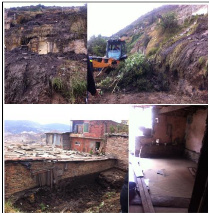
Figura 2. Deslizamiento superficial aledaño al polígono de intervención.
