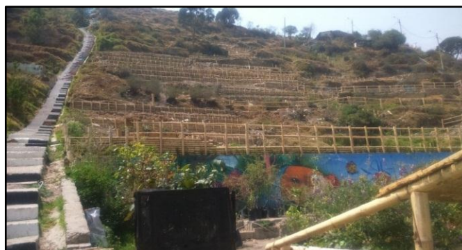
Figura 14. Vista global de terrazas de estabilización parte izquierda del polígono. Diciembre de 2015.
