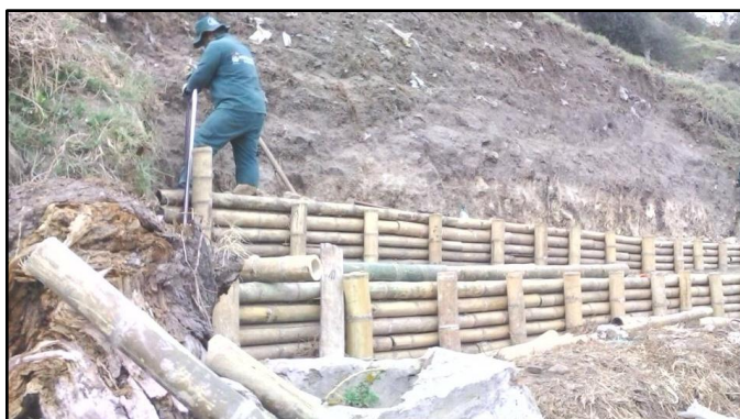
Figura 15. Relleno y apisonamiento en trinchos de estabilización, Noviembre de 2015.
