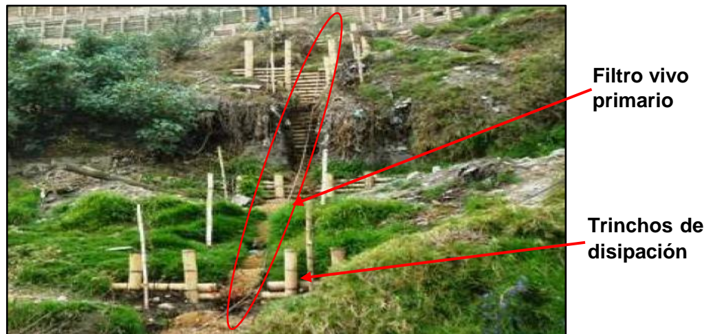
Figura 3. Construcción de Filtros vivos primarios y trinchos de disipación.
