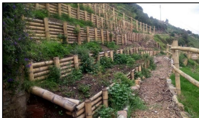
Figura 18. Trinchos de estabilización contiguos a gradas N°1, Febrero de 2016.
