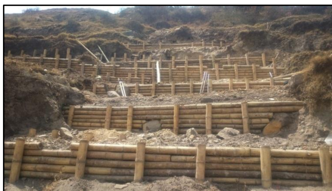
Figura 13. Construcción de Trinchos de estabilización parte alta del talud, Octubre de 2015.
