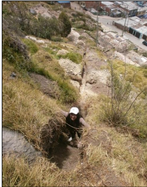
Figura 9. Construcción del filtro secundario al filtro 1, Septiembre de 2015.
