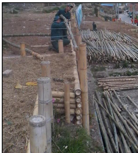
Figura 12. Trinchos de estabilización en la parte baja del talud, Octubre de 2015
