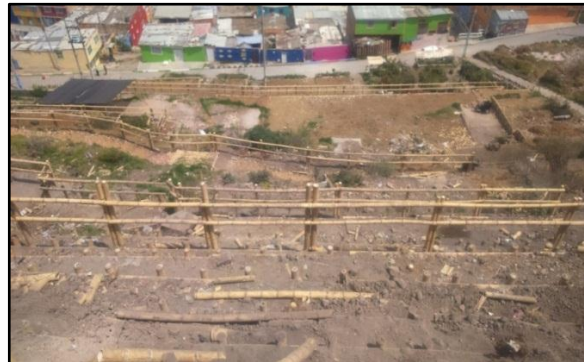
Figura 10. Construcción de los Trinchos de estabilización y senderos, escalera 1, Octubre de 2015.
