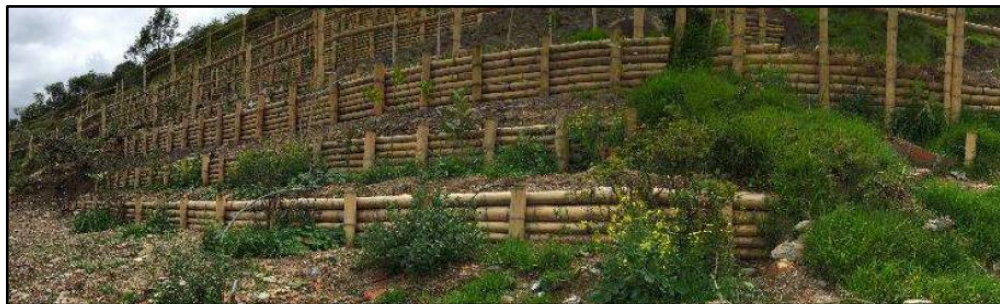
Figura 4. Trinchos de estabilización construidas en Cordillera Sur.
