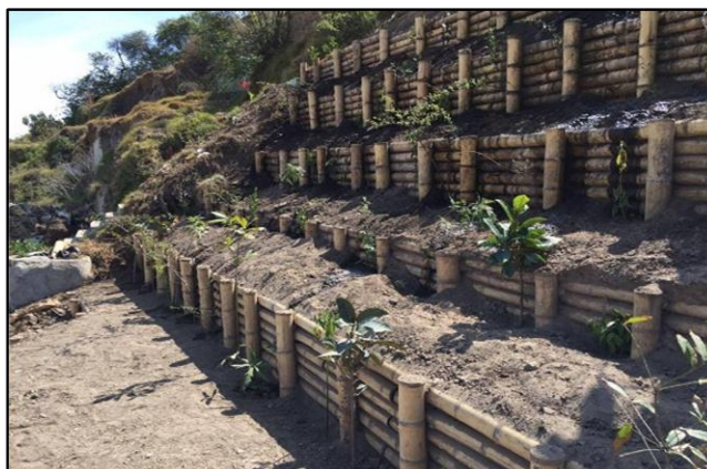
Figura 18. Trinchos de estabilización contiguos a gradas N°1, Febrero de 2016.
