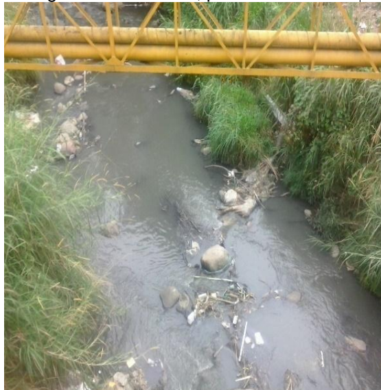
Figura 3. Río Molino, puente Yanacunas.
