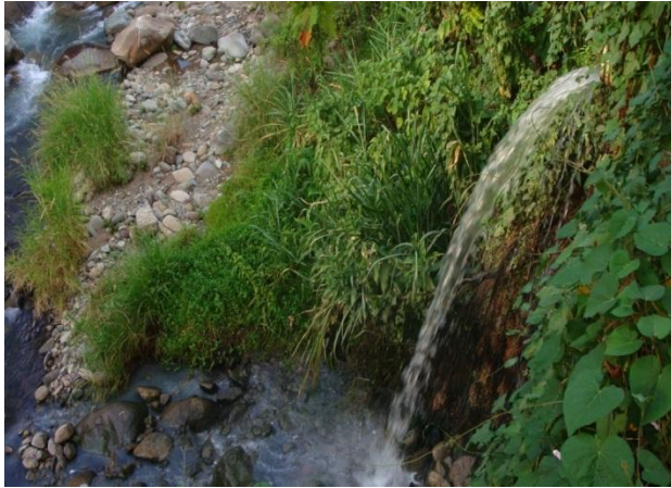
FIGURA N°25. VERTIMIENTO PUNTUAL PTAR MUNICIPAL.
