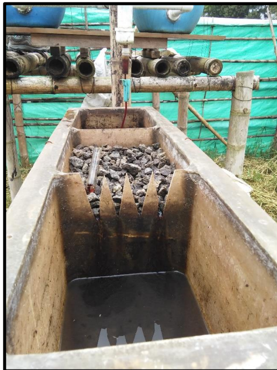
Foto 2. Desde el FAFA a tanque de regulación
