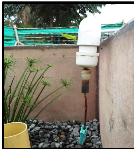
Foto 7. Macro goteo del sistema de salida del tanque regulador de caudal
