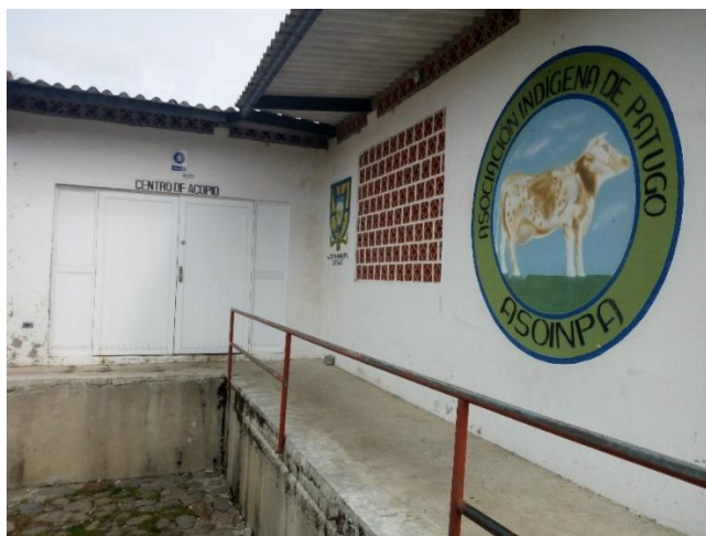
Figura 6. Centro de Acopio Asoinpa
