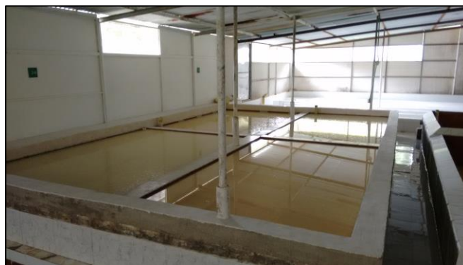
Figura 7. Tanques de fermentación.
