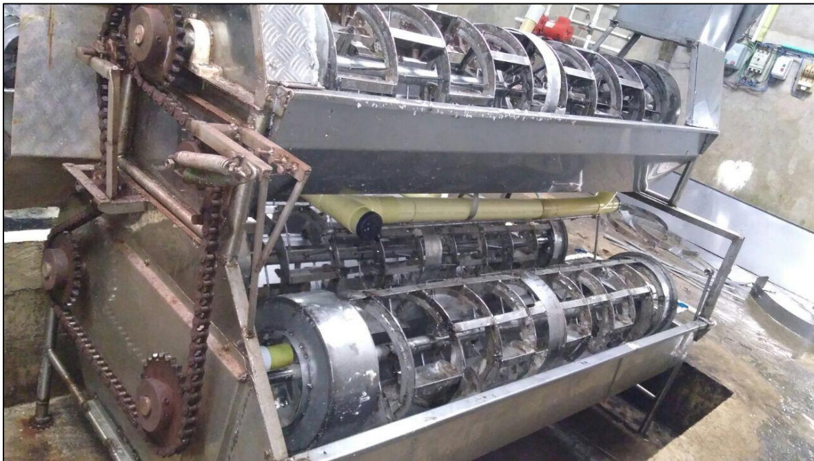
Figura 11. Montaje de la segunda maquina extractora de almidón con funcionamiento en paralelo.
