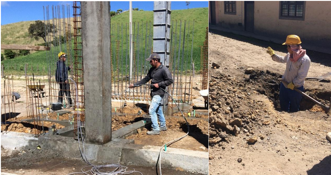
Figura 4. Registro fotográfico obras de construcción de un puesto de salud y de un alcantarillado pluvial
