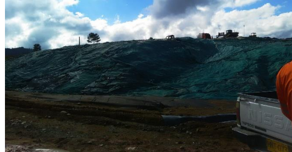
Figura 7: Cobertura sintética negro verde sobre la masa de residuos, relleno sanitario Los Picachos. Fuente: Propia (19/01/2018)
