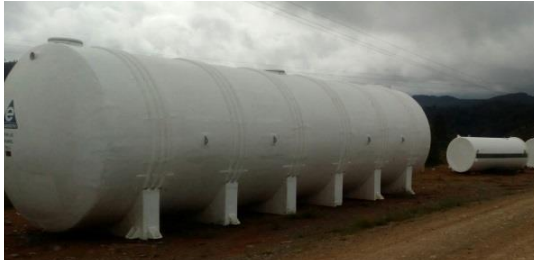
Figura 13: Reactores aerobios, relleno sanitario Los Picachos Fuente: SERVIASEO S.A (18/01/2018)
