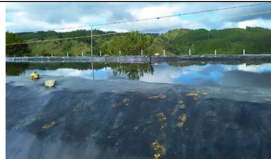
Figura 9: Pondaje 3, relleno sanitario Los Picachos. Fuente: Propia (19/01/2018)
