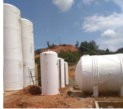
Figura 16: TCV, relleno sanitario Los Picachos Fuente: SERVIASEO S.A (13/02/2018)
