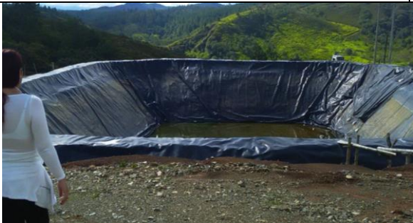
Figura 8: Pondaje 4, relleno sanitario Los Picachos. Fuente: Propia (19/01/2018)
