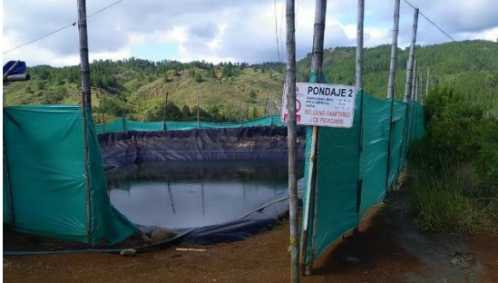
Figura 6: Pondaje 2, relleno sanitario Los Picachos. Fuente: Propia (19/01/2018)
