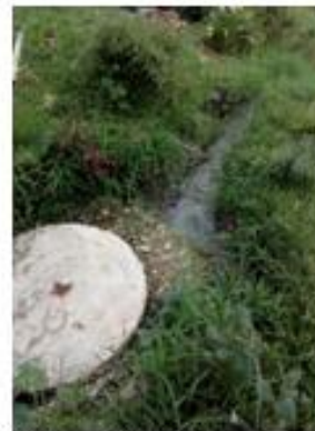
Imagen 2. Cámara de inspección con rebosa de aguas (b)
