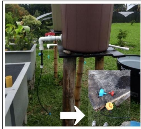
Figura 11. Goteros autocompensantes y no autocompensantes para regular el flujo de alimentación de los humedales
