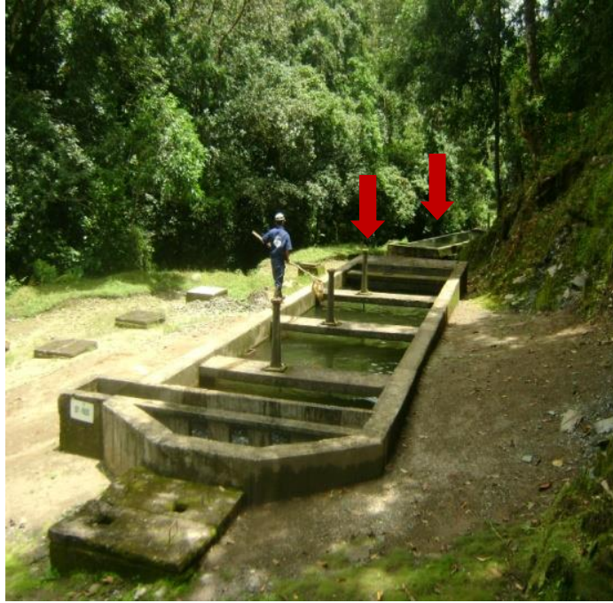
Figura 19. Desarenadores 1 y 2 (F 14 , ver Anexo E)
