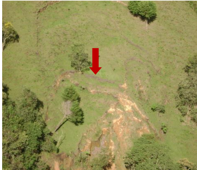
Figura 15. Deslizamiento (F 10 , ver Anexo E)
