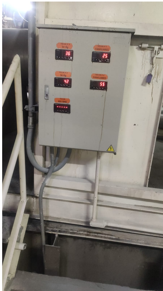
Figura 3.15: Montaje indicadores de nivel Novus Fuente: Propia
