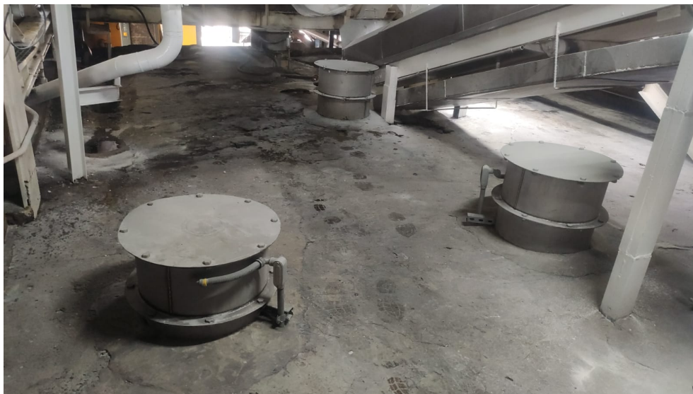
Figura 3.12: Construcción de recámaras para sensores de nivel tipo radares Fuente: Propia
