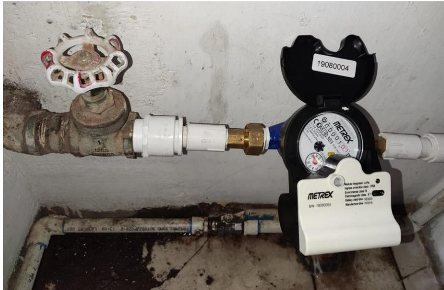
*Figura 72. Medidores AMR instalados en el piso 2. Fuente propia.*
