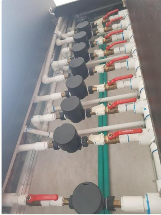
*Figura 55. Medidores para el Piso 3. Fuente propia.*
