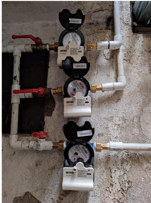
*Figura 71. Medidores AMR instalados en el sótano. Fuente propia.*
