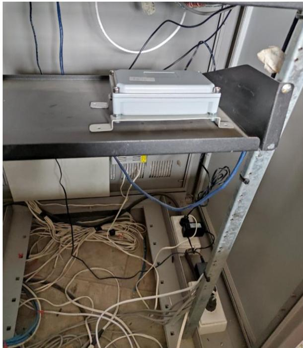
*Figura 69. Ubicación y conexión del Gateway en el rack de comunicaciones. Fuente propia*
