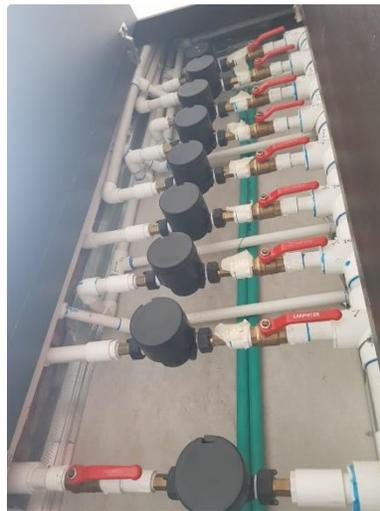
Figura 10. Medidores de agua marca Metrex instalados en gabinete de medición. Fuente propia.
