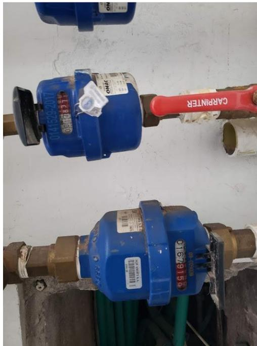
*Figura 52. Medidores instalados en el edificio para el momento de la primera visita técnica. Fuente propia.*
