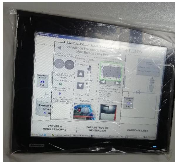
Figura 163. Ejecución de HMI en computador industrial Advantech. Pantalla variador de frecuencia PowerFlex 400 (fuente propia)
