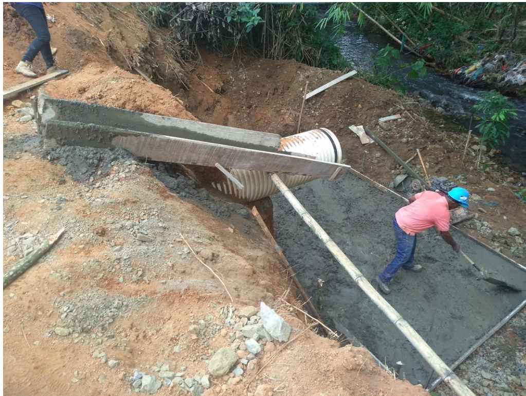
Ilustración 24: Fundición de la losa de cimentacion para la estructura del Descole.
