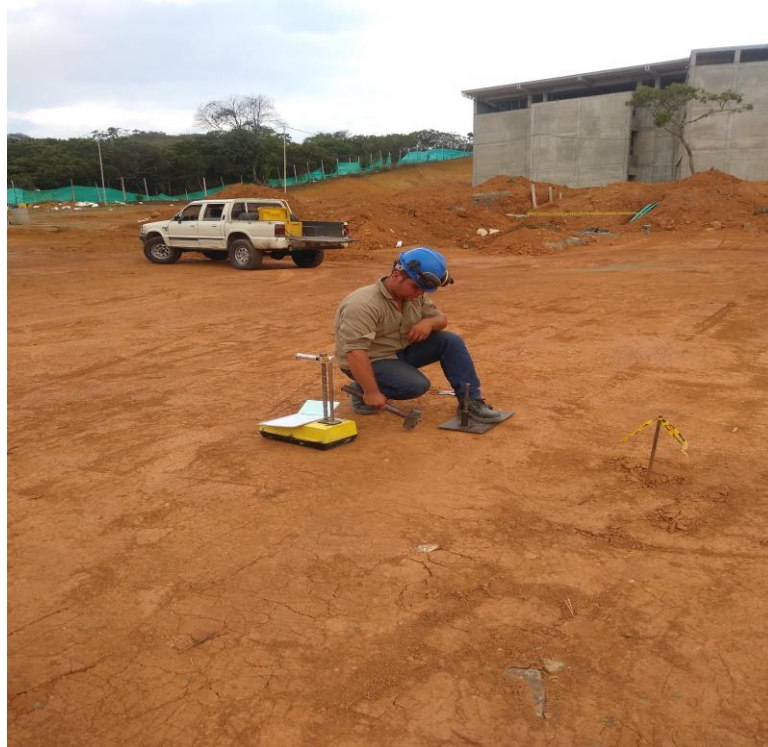
Ilustración 27: Toma de muestra con el Densímetro nuclear en zona de parqueadero. Fuente propia.
