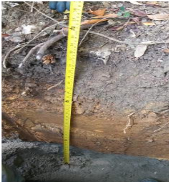
Ilustración 14: Verificación altura de la zanja para la red hidráulica externa (0.7 m). Fuente propia
