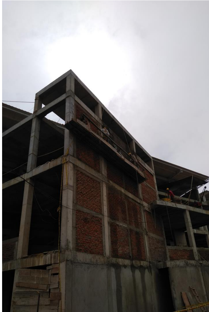
Ilustración 6: Actividad de Repello fachada externo con andamios colgantes. Fuente: propia
