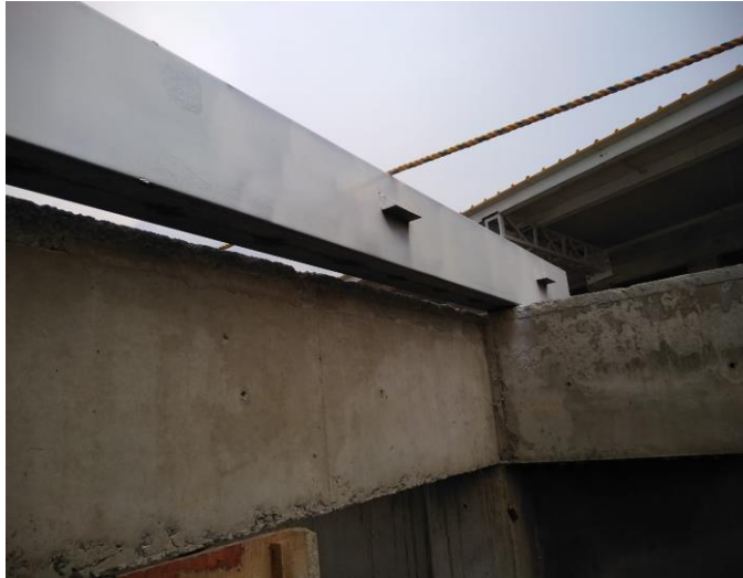
Ilustración 11: Perfil metálico que se utilizara como tirante para la cubierta metálica de la batería número uno. Fuente: propia
