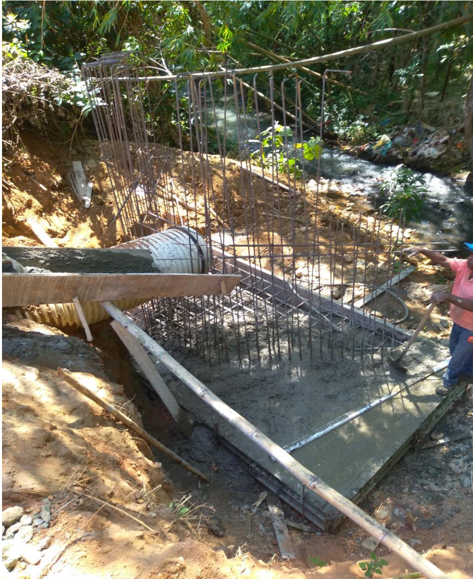
Ilustración 25: Armada de acero para la alzada del Descole. Fuente propia.
