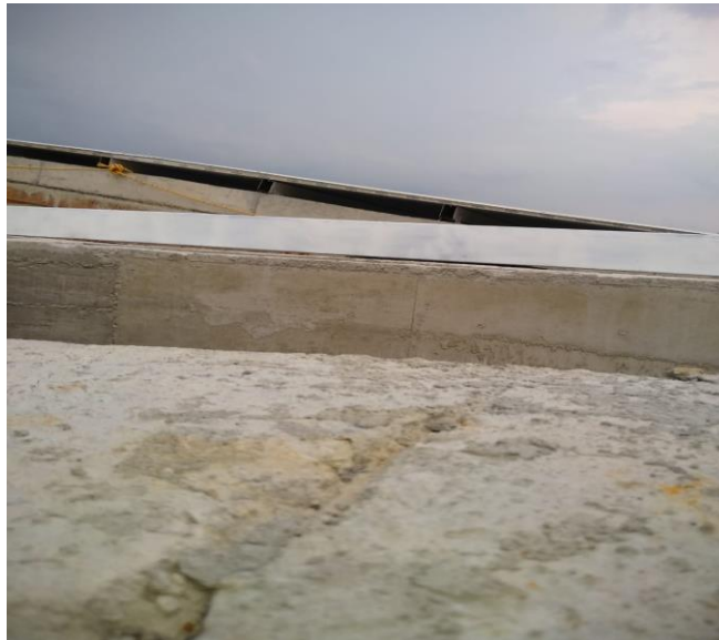
Ilustración 10: Perfil metálico que se utilizara como tirante para la cubierta metálica de la batería número uno.
