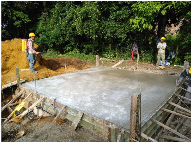
Ilustración 19: Aplicación de Anti sol a la superficie de la losa. Fuente propia.
