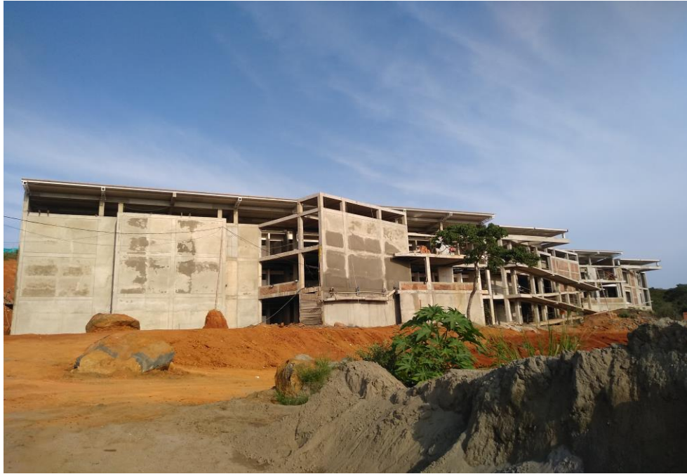
Ilustración 3: Estado de la obra al inicio de la pasantía. Fuente: propia
