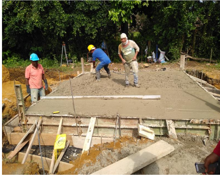
Ilustración 18: Acabado con llana y codal para dar nivel a la losa. Fuente propia.
