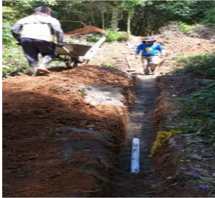
Ilustración 15: Instalación tubería de 2 ½ “extremo liso para la red hidráulica externa.
