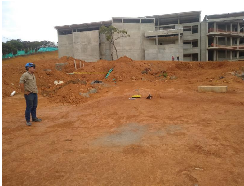
Ilustración 26: Toma de muestra con el Densímetro nuclear en zona de parqueadero. Fuente propia.
