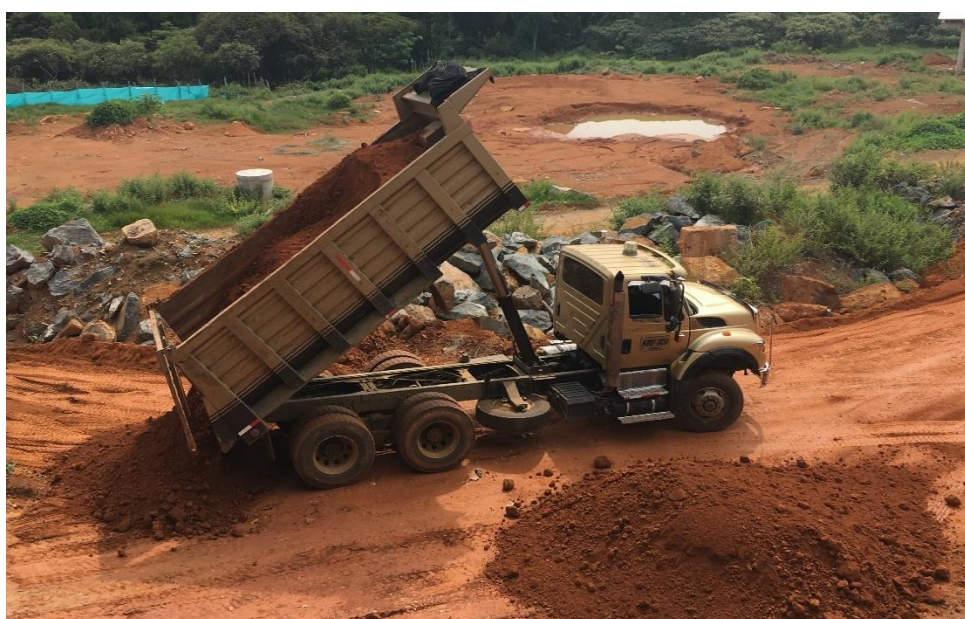
Ilustración 28. Colocación de material para relleno frente a bloque 1.
