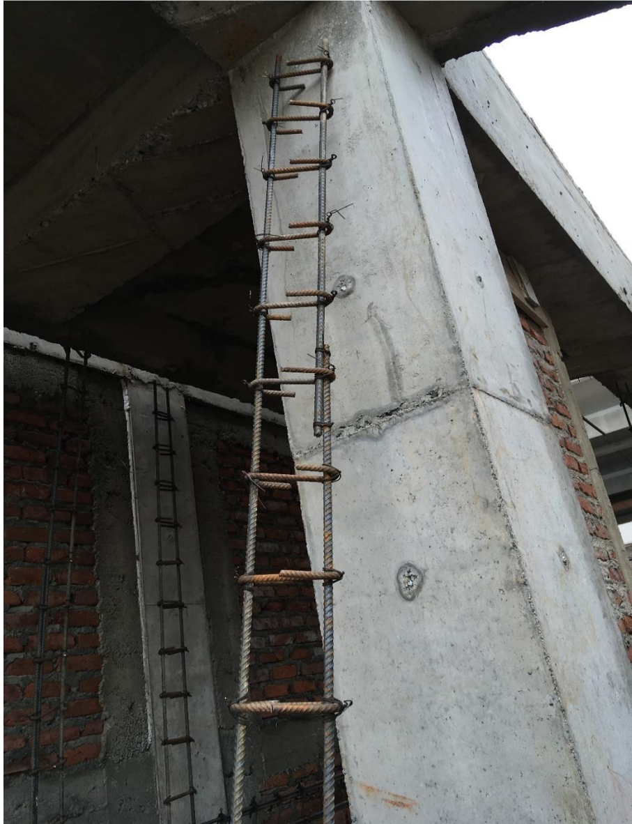
Ilustración 11. Aceros para columnetas.
