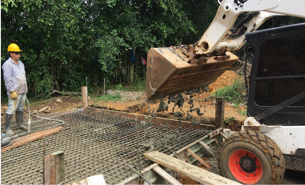
Ilustración 44. Fundición de losa con ayuda del bobcat.
