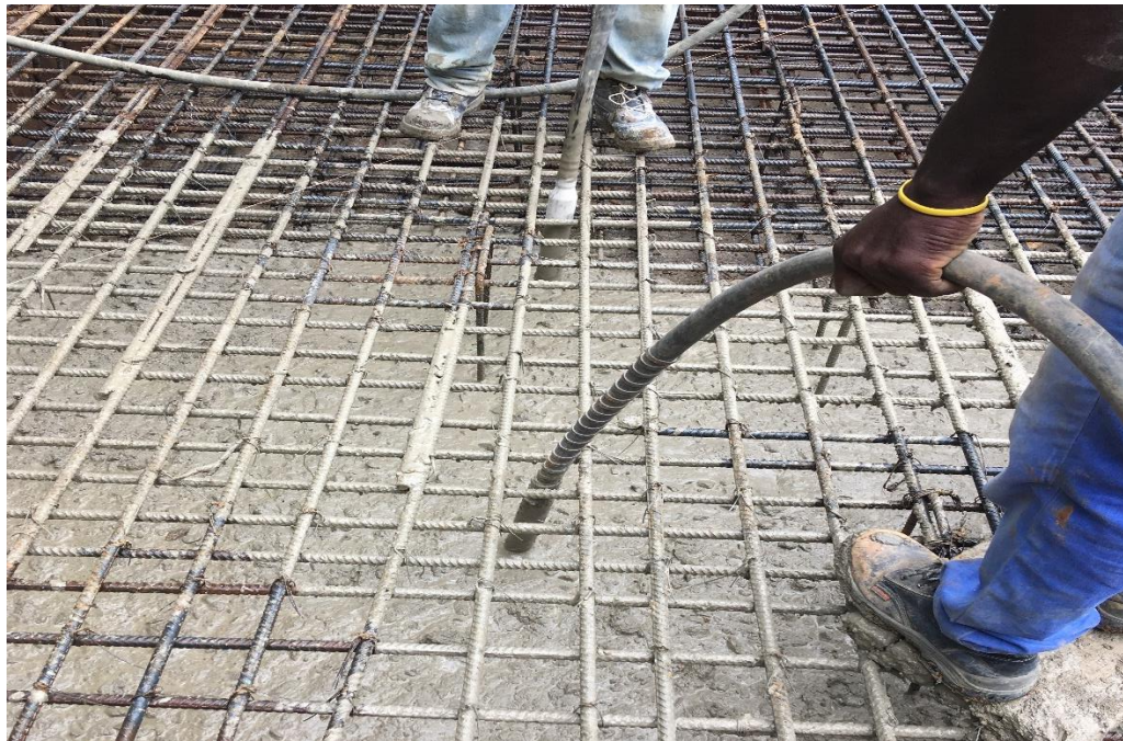
Ilustración 45. Vibrado del concreto fresco.
