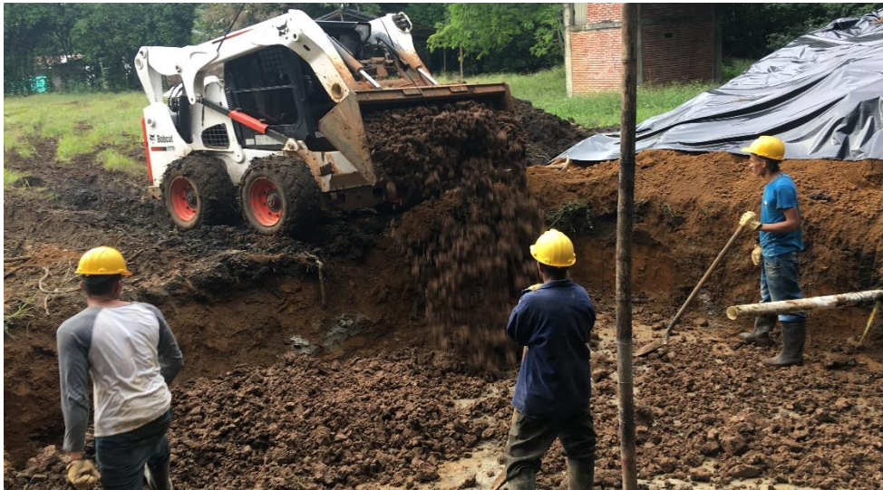
Ilustración 33. Relleno de roca muerta para mejorar la calidad del suelo.
