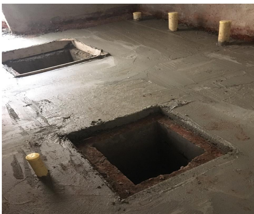
Ilustración 19. Fundición de cajas y piso primario en batería 1 - piso 1.
