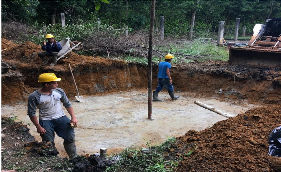
Ilustración 32. Excavación y compactación de terreno natural.
