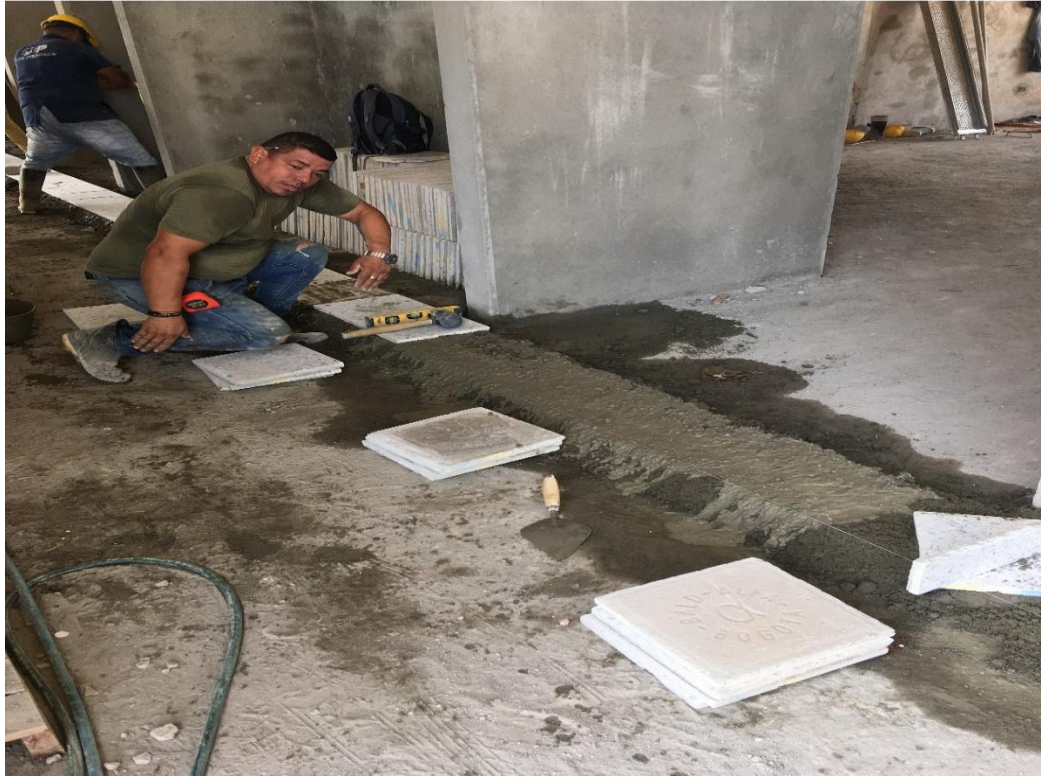
Ilustración 13. Pega de baldosa bloque 1 - piso 3.
