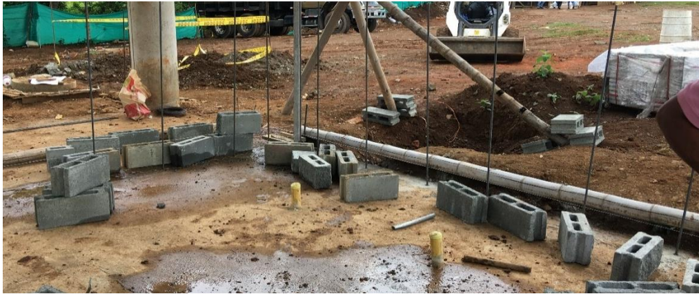
Ilustración 62. Replanteo y chequeo de medidas para la mampostería estructural en portería principal.
