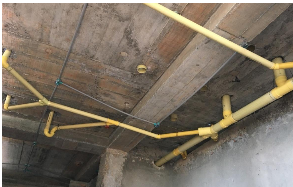
Ilustración 17. Instalación tubería sanitaria en batería 1 - piso 2.
