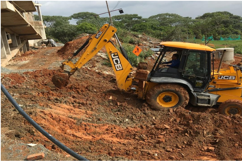
Ilustración 25. Corte del terreno en frente de bloque 1.
