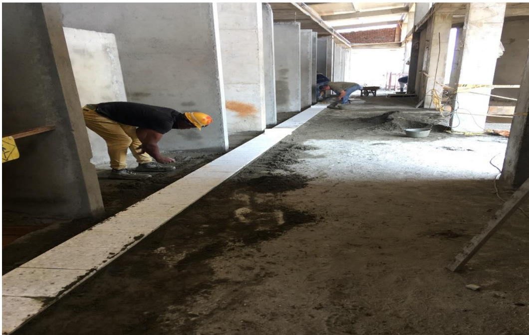
Ilustración 12. Replanteo de pega de baldosa bloque 1 - piso 3.
