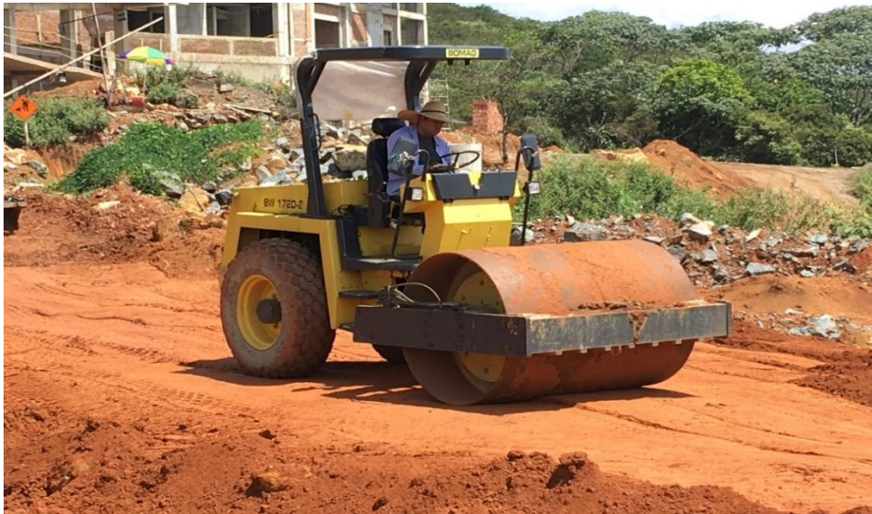
Ilustración 29. Compactación de material de relleno frente a bloque 1.
