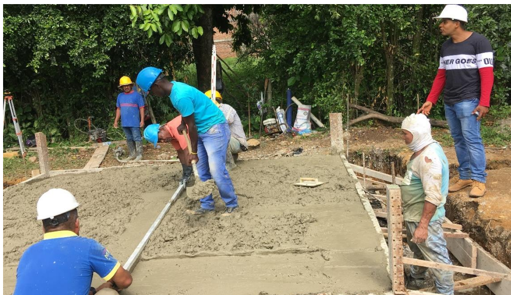
Ilustración 56. Acabado de la superficie de la losa.
