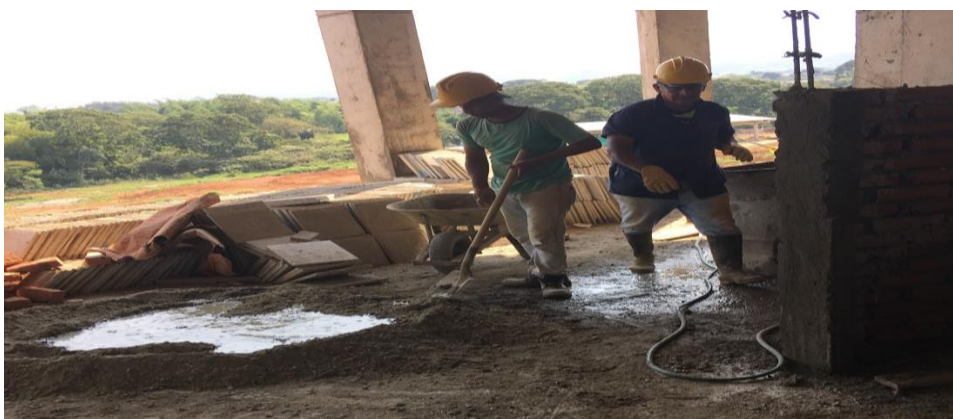
Ilustración 6. Preparación de mezcla para fundición de elementos NE.
