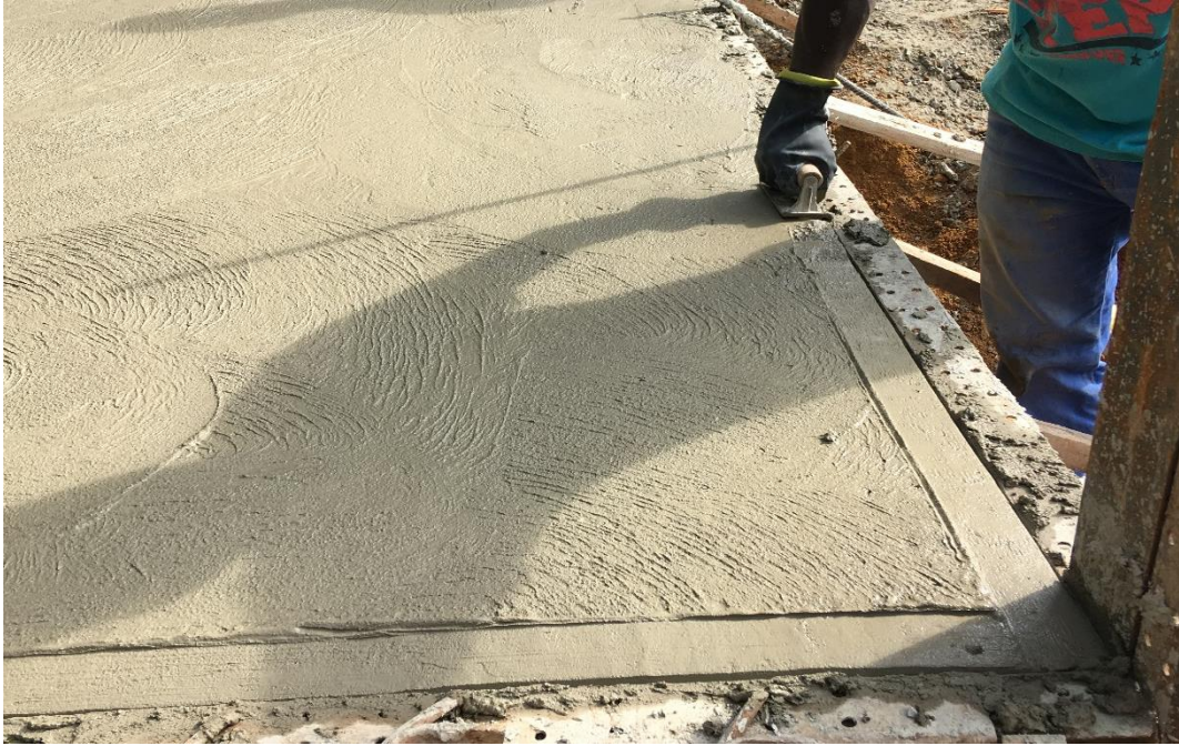
Ilustración 58. Acabado final de la superficie de la losa.
