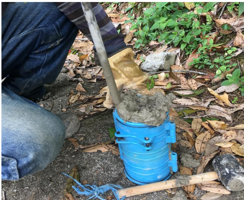
Ilustración 53. Apisonado de segunda capa de concreto fresco para ensayos de muestras.
