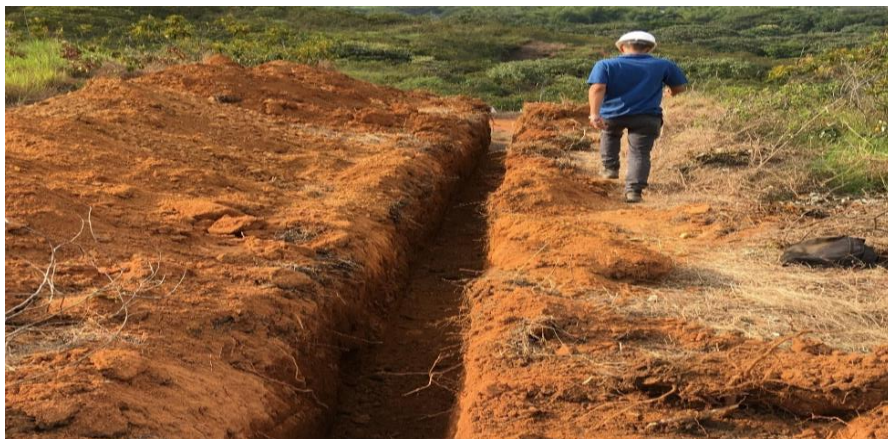
Ilustración 37. Excavación para acueducto.
