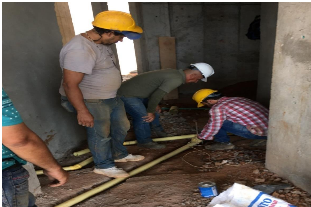
Ilustración 16. Instalación de tubería sanitaria en batería 1 - piso 1.
