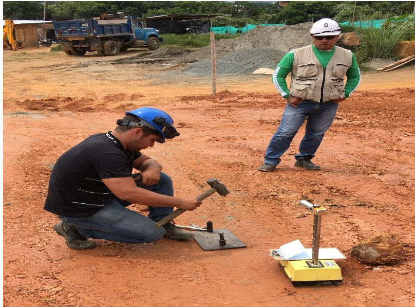
Ilustración 31. Ensayos de densidad en suelo compactado frente a bloque 1.
