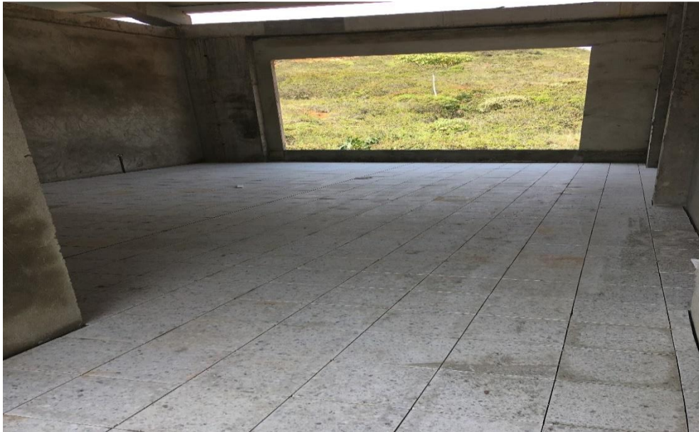
Ilustración 14. Pega de baldosa completa en aulas.
