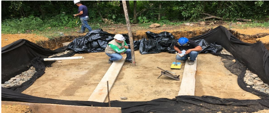
Ilustración 34. Ensayo de densidad sobre roca muerta compactada.
