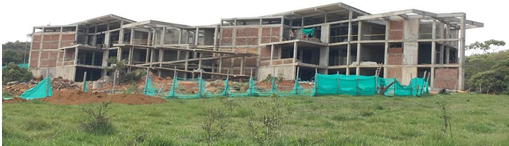
Ilustración 3. Estado de la obra al inicio de la pasantía.
