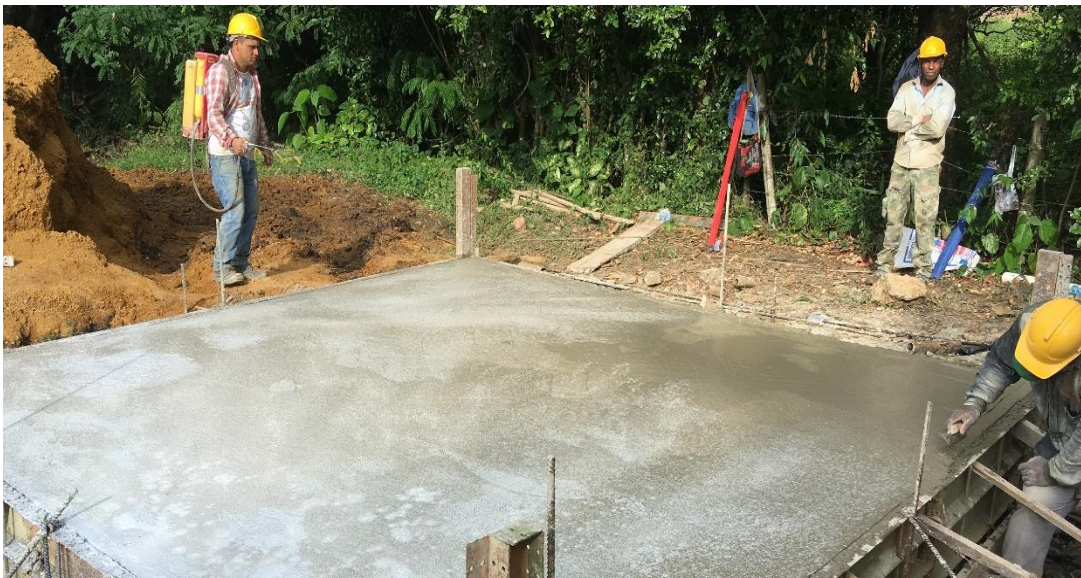
Ilustración 59. Aplicación del anti sol sobre la superficie de concreto fresco.
