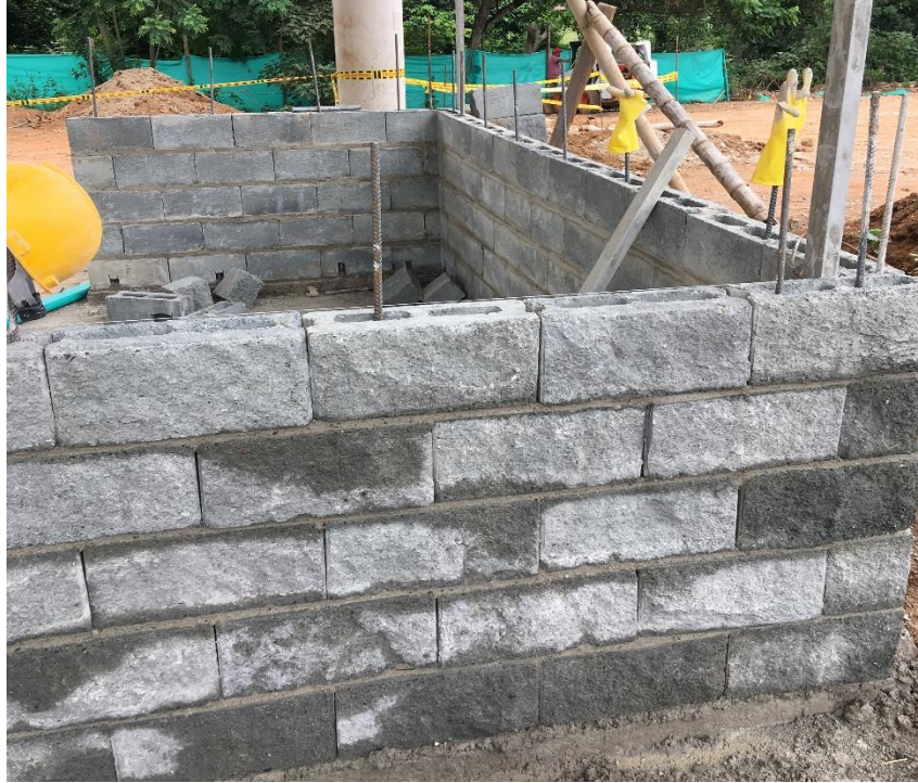
Ilustración 64. Muros estructurales en portería principal.
