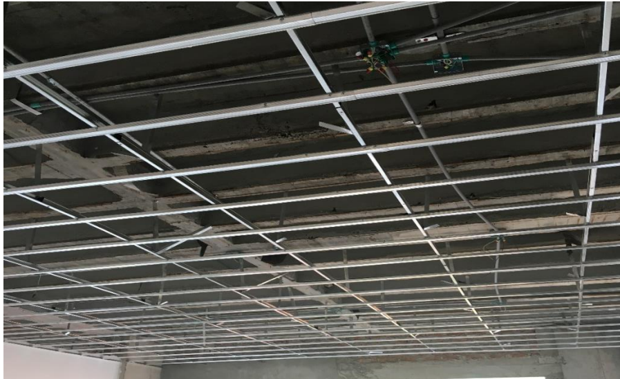
Ilustración 36. Estructura metálica para cielo falso en aulas.
