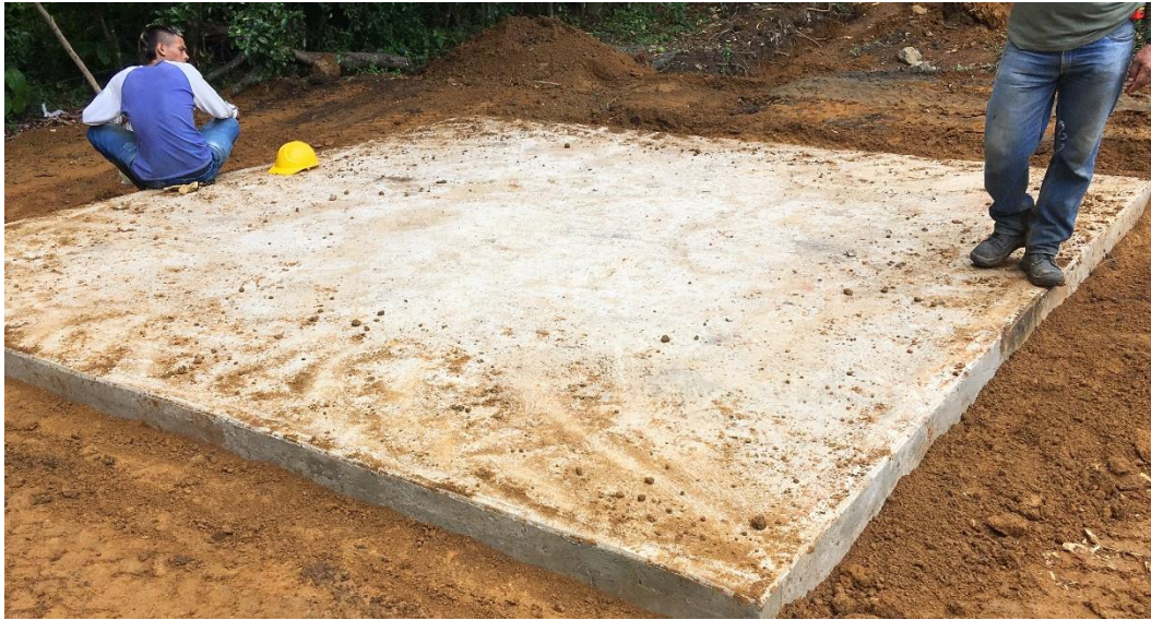
Ilustración 60. Relleno y compactación del suelo alrededor de la losa.
