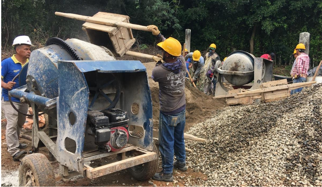
Ilustración 46. Dosificación del concreto y mezclado con mezcladora eléctrica.
