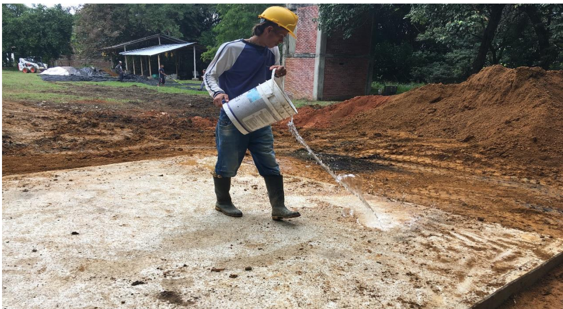
Ilustración 61. Aplicación de agua sobre la superficie de la losa.
