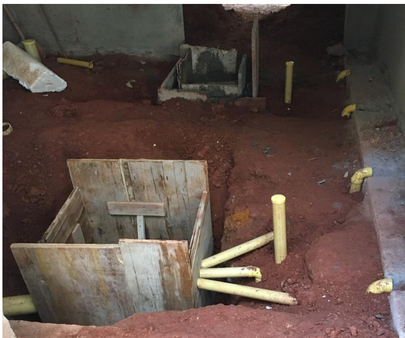
Ilustración 18. Encofrado de cajas de inspección en batería 1 - piso 1.
