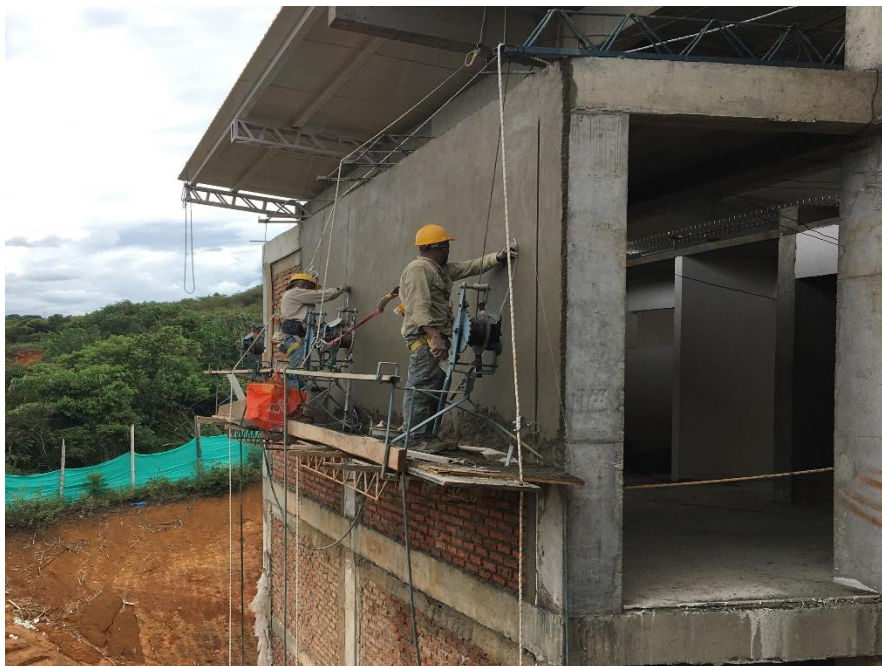
Ilustración 23. Repello de fachadas bloque 1 - piso 3.
