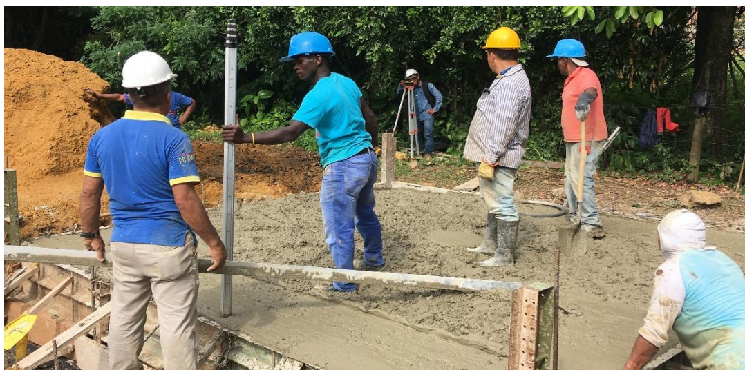
Ilustración 57. Verificación de niveles en la superficie de la losa.
