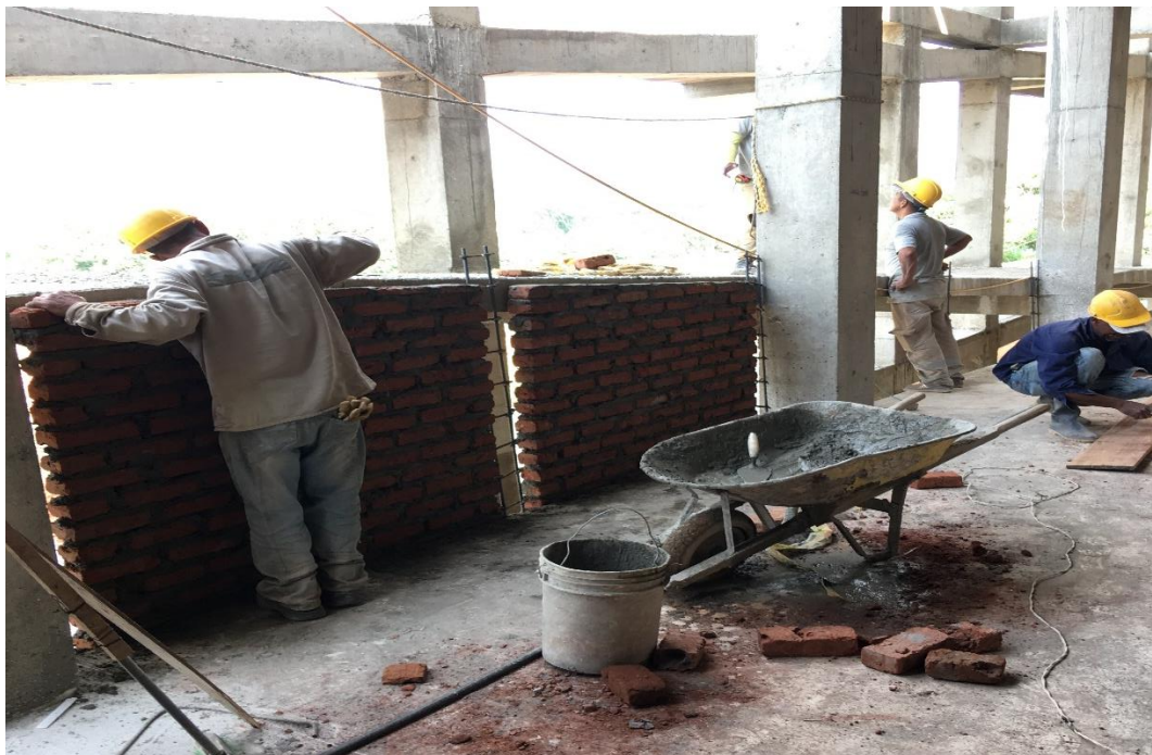
Ilustración 9. Pega de muros entre batería 1 – piso2 y rampa de acceso.
