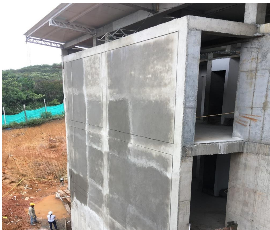
Ilustración 24. Repello completo en bloque 1.
