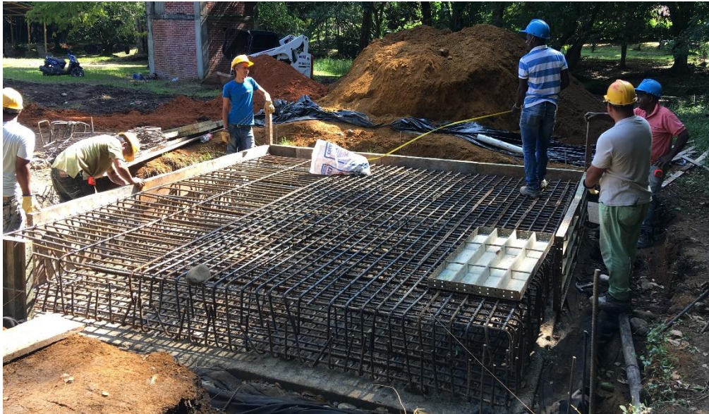
Ilustración 39. Cheque de aceros y colocación de formaleta.
