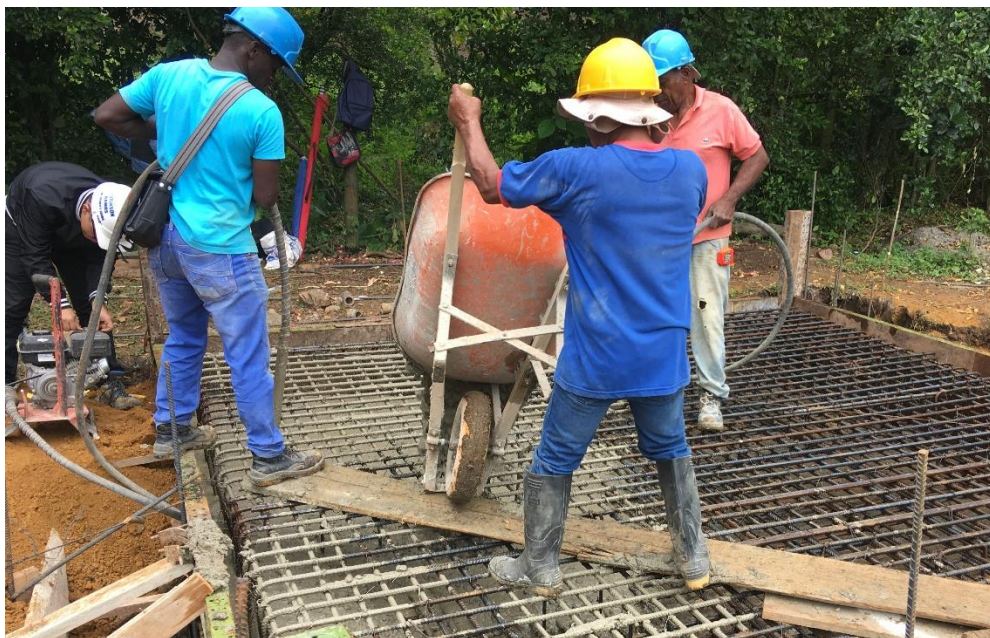
Ilustración 43. Fundición de losa mediante el buggy.
