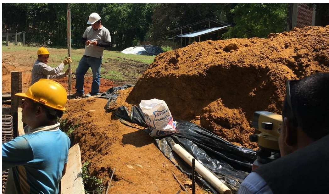
Ilustración 41. Chequeo de niveles previo a la fundición de la losa.
