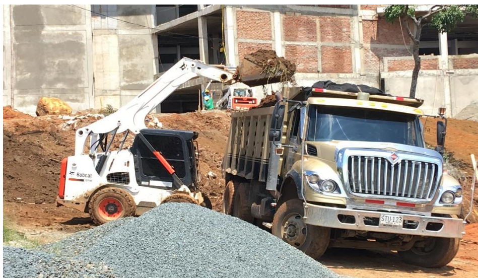
Ilustración 27. Extracción material orgánico con el bobcat y volqueta.
