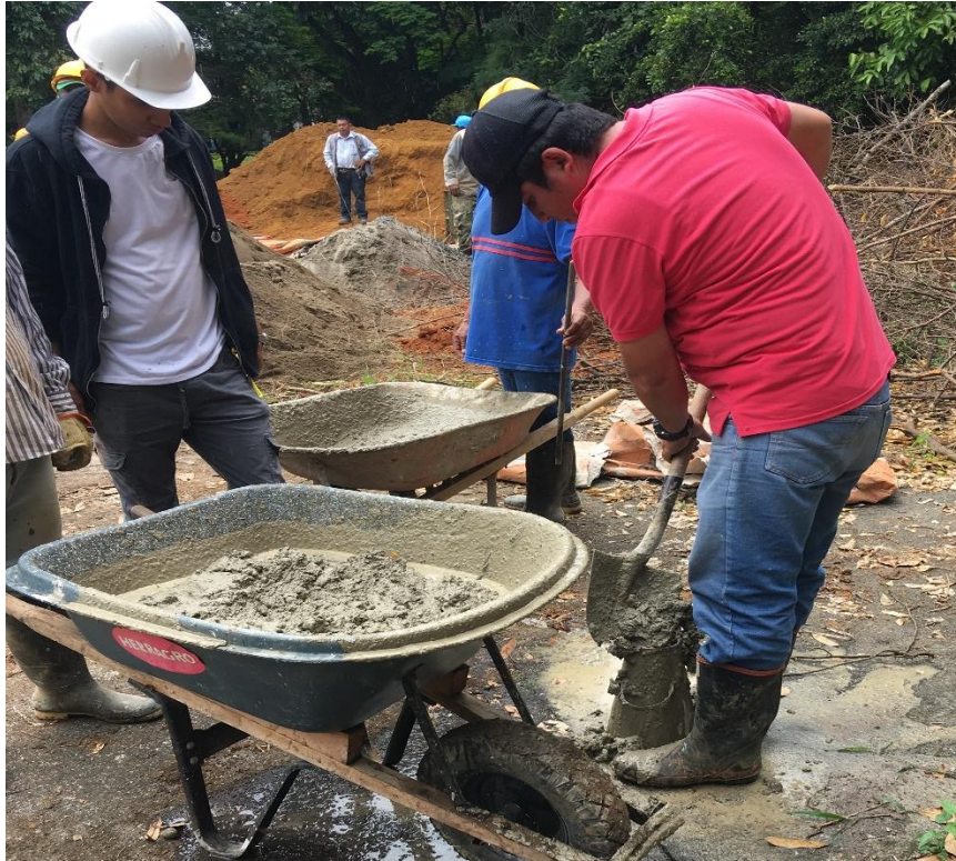
Ilustración 48. incorporación del concreto fresco al cono de abrams para prueba de asentamiento.
