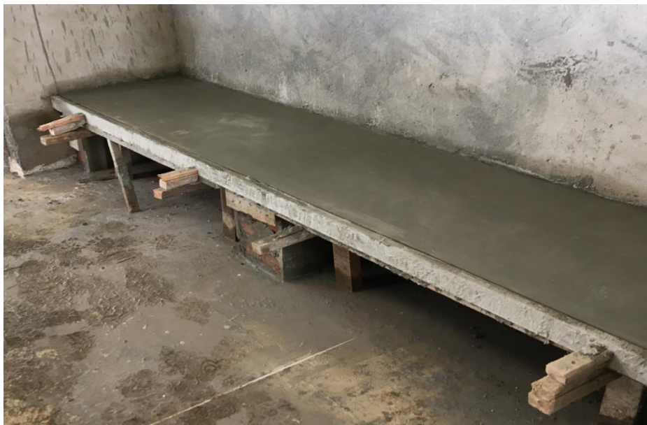
Ilustración 21. Losa de banca fundida en bloque 1 - piso 2.
