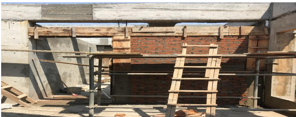
Ilustración 7. Muro de batería sanitarias bloque 2, piso3.
