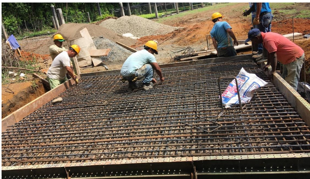
Ilustración 40. Colocación de estribos.
