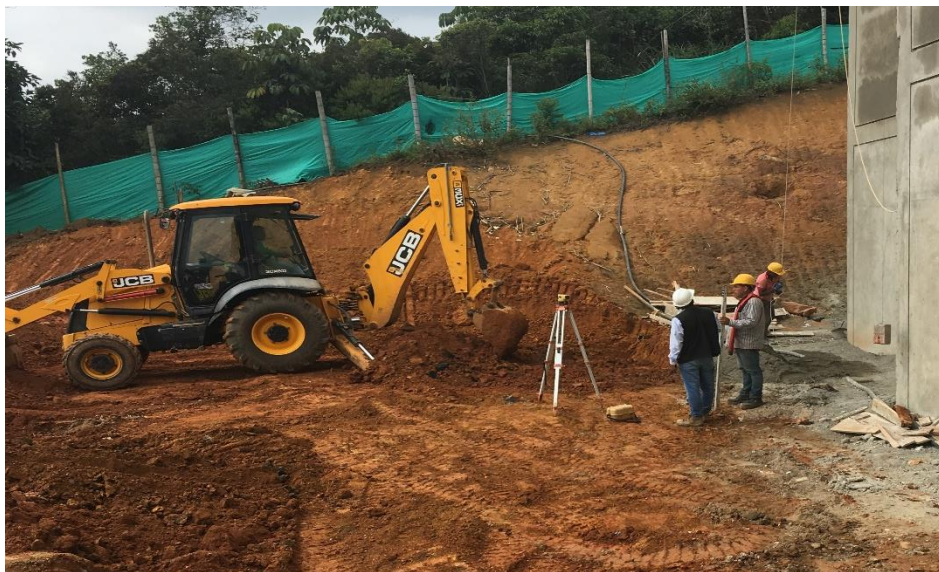
Ilustración 26. Chequeo de niveles en corte de terreno frente a bloque 1.
