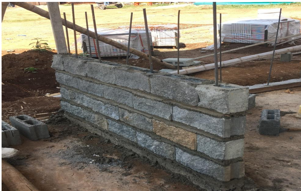
Ilustración 63. Pega de bloques de concreto para mampostería estructural en portería principal.
