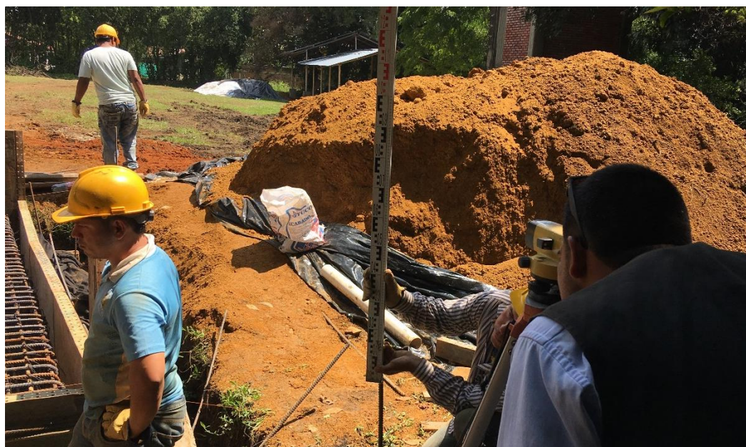
Ilustración 42. Chequeo de niveles.
