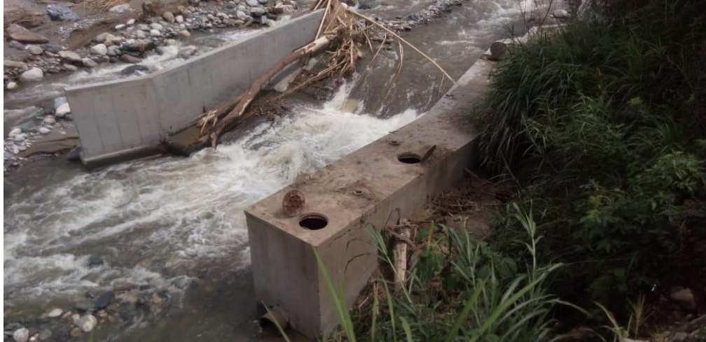
Figura 60. Foto bocatoma principal del acueducto de Padilla (Padilla-Cauca).
