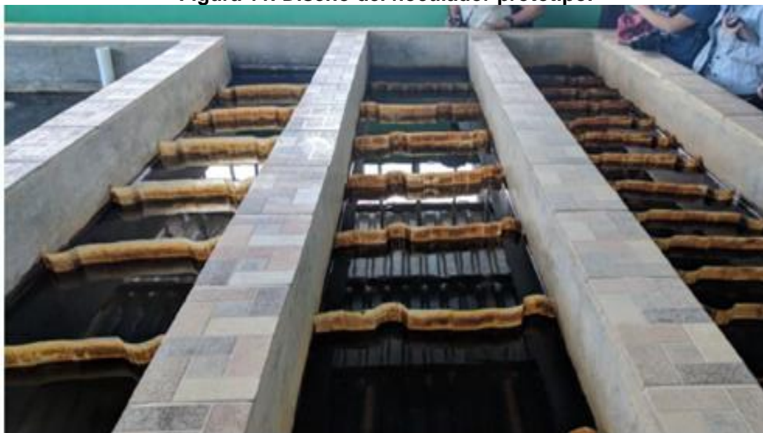
Figura 11. Diseño del floculador prototipo.
