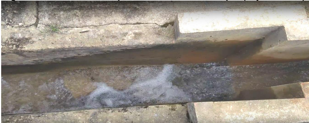
Figura 47. Foto de mezcla rápida PTAP de Michicao etapa I (Cajibío-Cauca).
