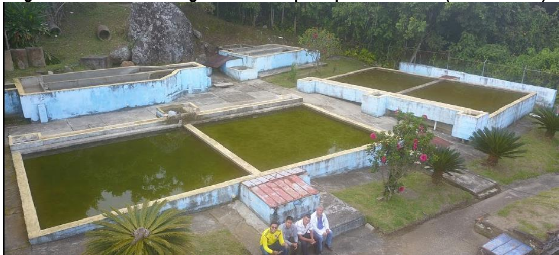
Figura 55. Foto de filtros gruesos PTAP principal de la Sierra (Sierra-Cauca).
