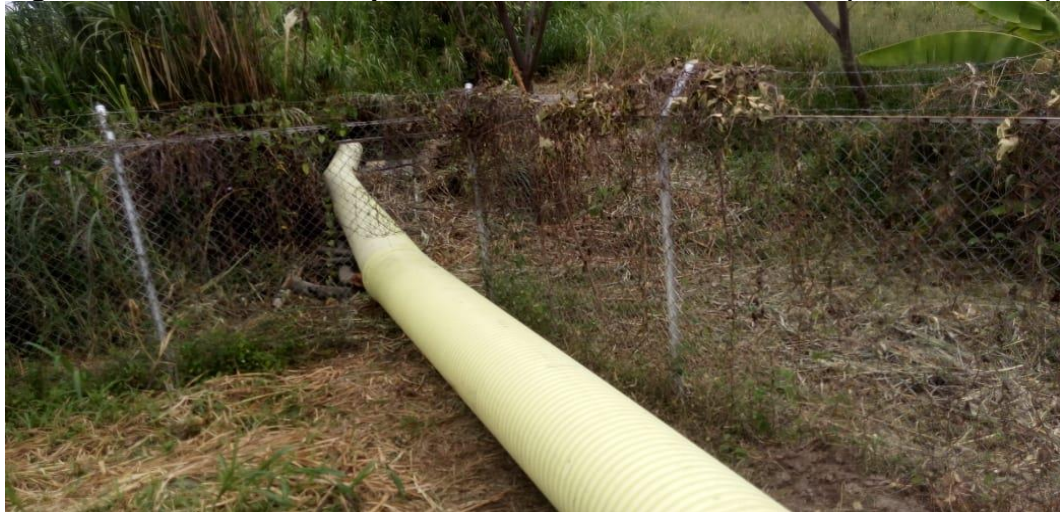
Figura 63. Foto de tubería provisional del acueducto Padilla (Padilla-Cauca).
