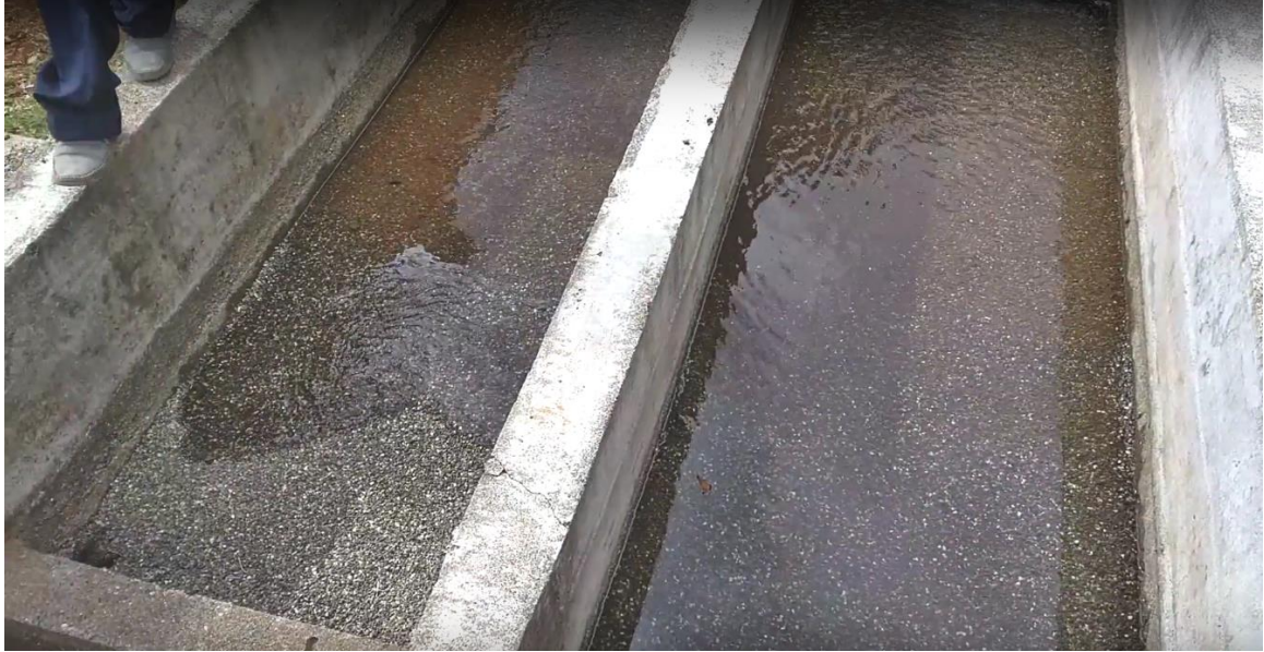
Figura 57. Foto filtro dinámico PTAP secundaria de la Sierra (Sierra-Cauca).
