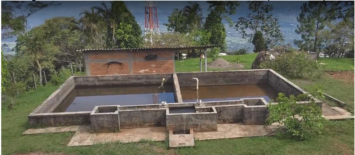
Figura 59. Foto filtros lentos PTAP secundario de la Sierra (Sierra-Cauca).
