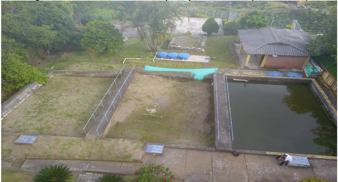
Figura 56. Foto filtros lentos PTAP principal de la Sierra (Sierra-Cauca).
