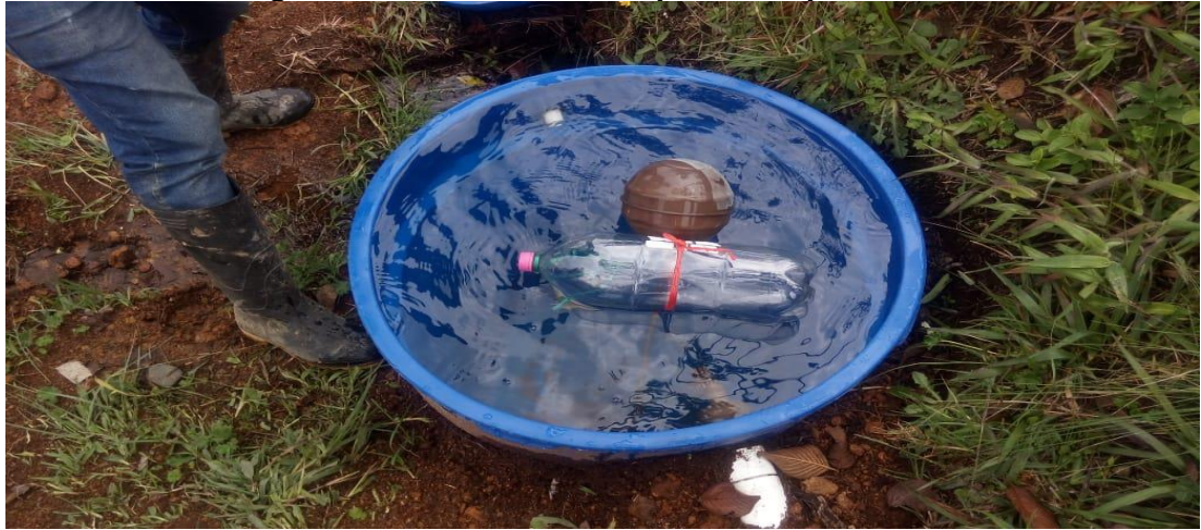
Figura 64. Foto cámara de quiebre improvisada.
