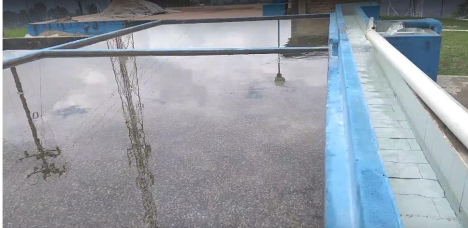
Figura 51. Foto filtro grueso PTAP de la Sierra (Sierra-Cauca).
