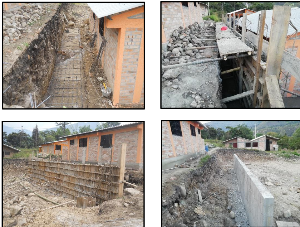
Figura No. 29 Construcción muros de contención.
