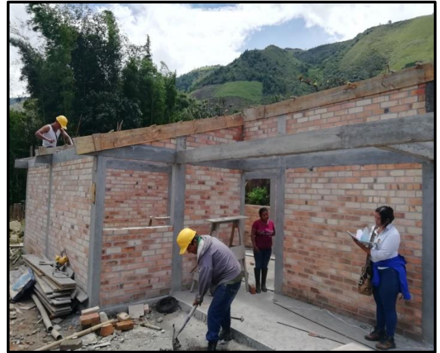
Figura No. 24 Levantamiento muro de culata, armazón de acero y fundición viga de coronación.
