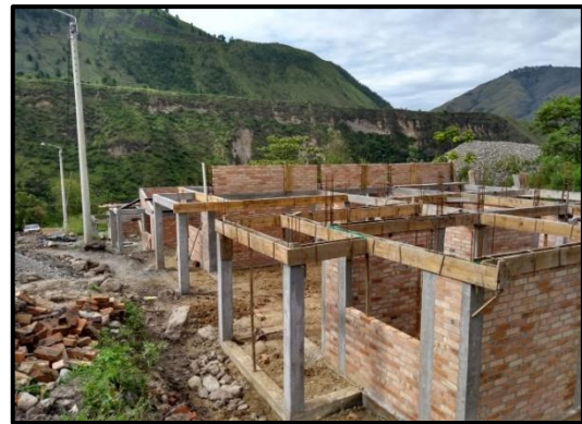
Figura No. 23 Acero de viga de amarre y fundición de la misma.
