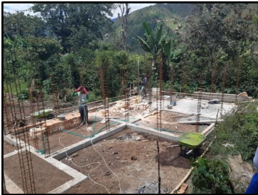
Figura No. 22 Levantamiento de muros.
