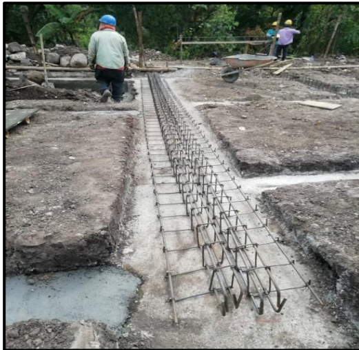
Figura No. 20 Armazón de aceros para vigas de cimentación.
