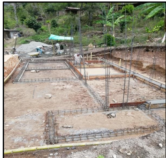
Figura No. 20 Armazón de aceros para vigas de cimentación.
