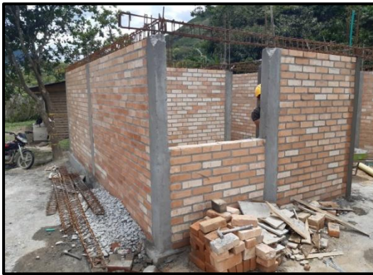
Figura No. 23 Acero de viga de amarre y fundición de la misma.
