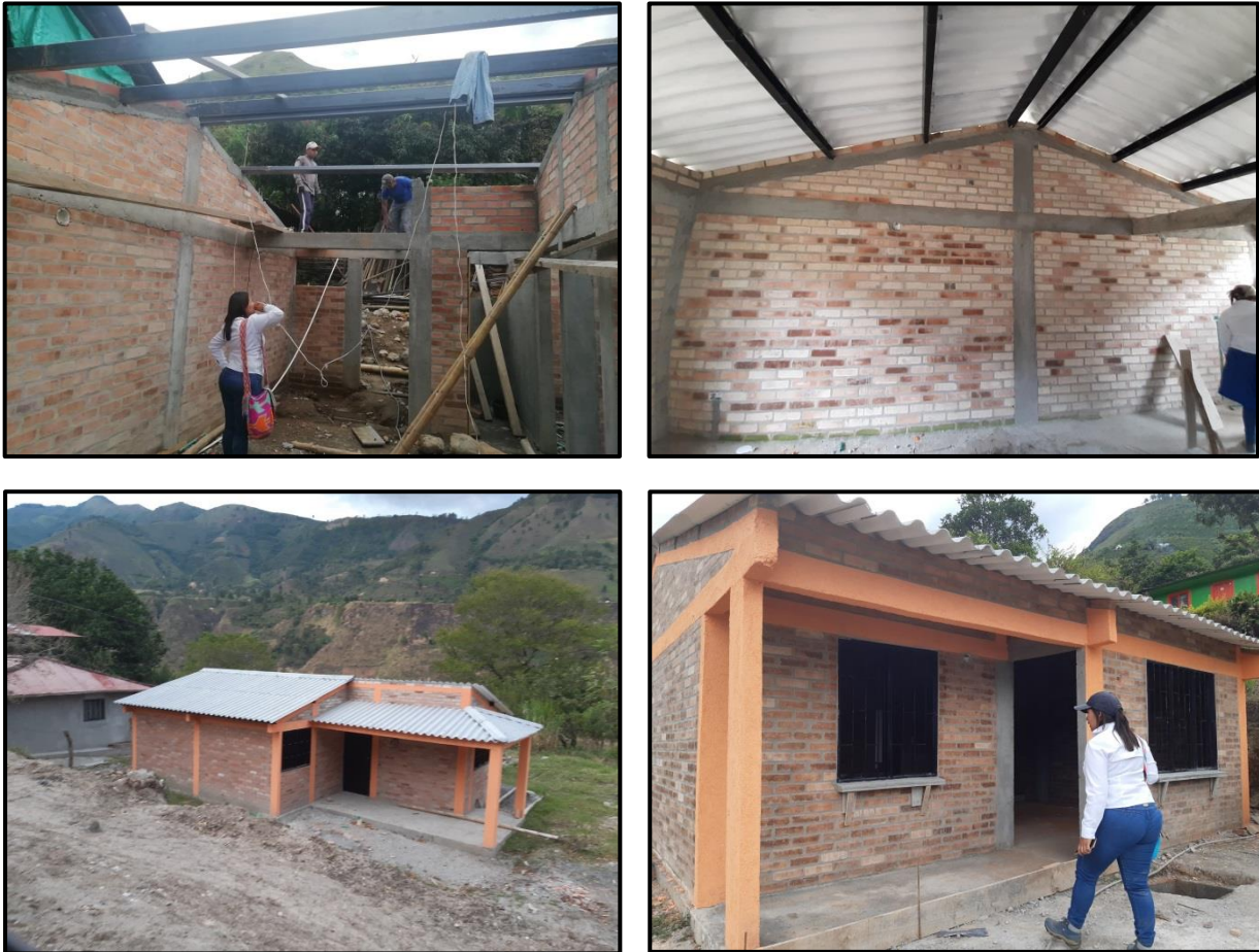
Figura No. 25 Colocación cubierta y aplicación graniplast sobre caras externas.
