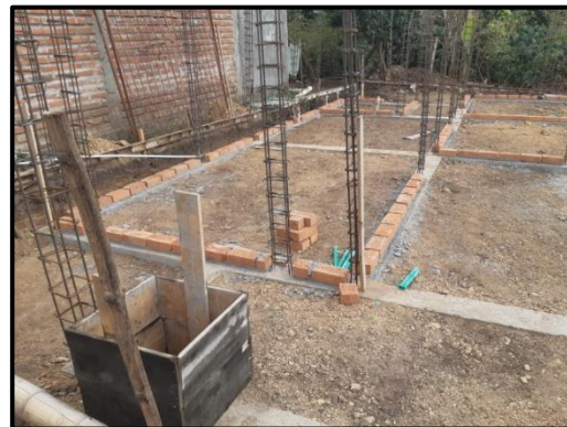
Figura No. 22 Levantamiento de muros.
