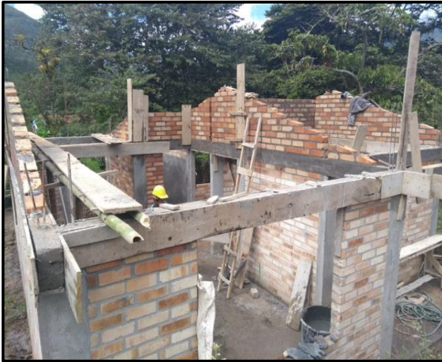
Figura No. 24 Levantamiento muro de culata, armazón de acero y fundición viga de coronación.
