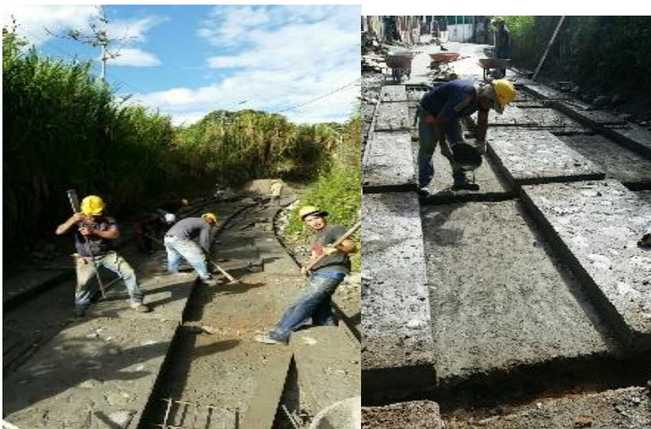
*Ilustración 17*Excavación de riostras y solado
