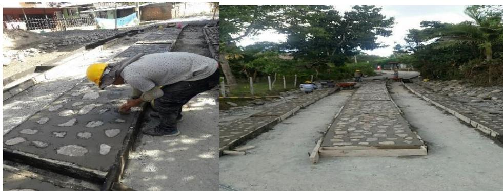
*Ilustración 16 Limpieza de piedra, fundición de piedra.*
