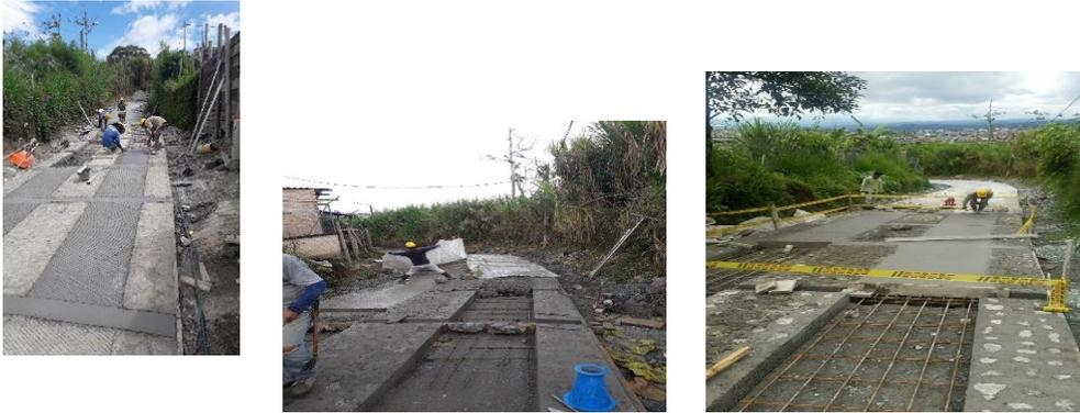
*Ilustración 20 Fundición de placa huella*
