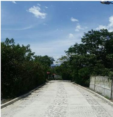
*Ilustración 30 Tramo placa huella construida*
