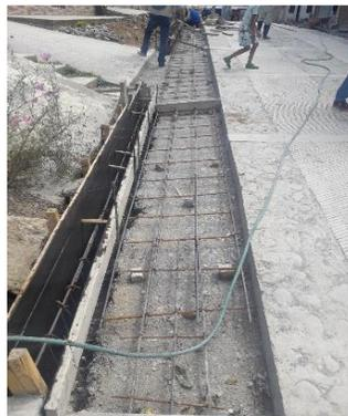
*Ilustración 25. Acero de refuerzo de cuneta y bordillos.*
