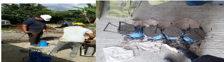
Ilustración 22 Toma de cilindros.
