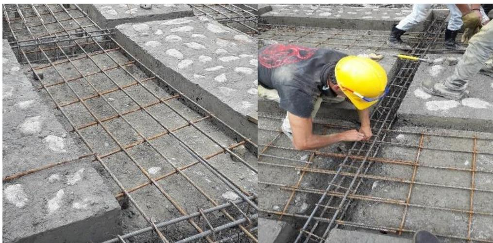
*Ilustración 18. Mallas sobre cubos de concreto, amarre de riostras y mallas.*
