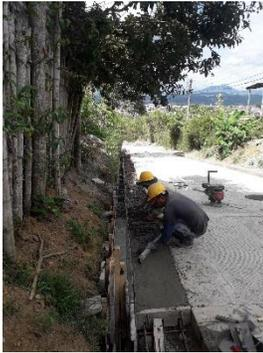
*Ilustración 26 fundición de cuneta*
