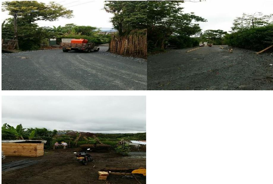
*Ilustración 11 Replanteo de la obra, abcisado y levantamiento de campamento.*
