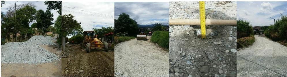
*Ilustración 14 Material acordonado, nivelación y material extendido por la motoniveladora, control de espesores, tramo conformado.*
