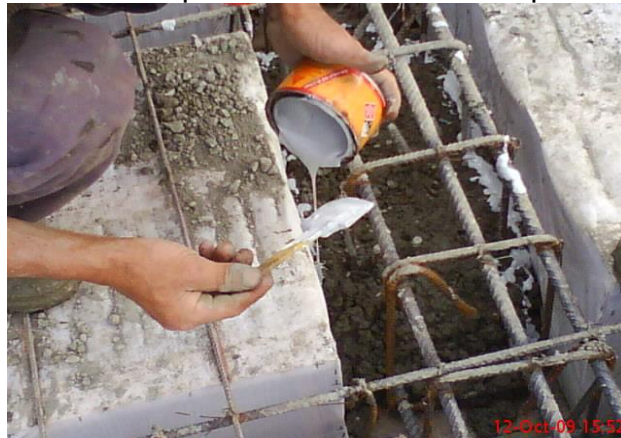
Ilustración 28. Imprimación de sikadur 32 primer
