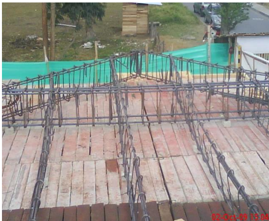
Ilustración 22. Acero de la losa.
