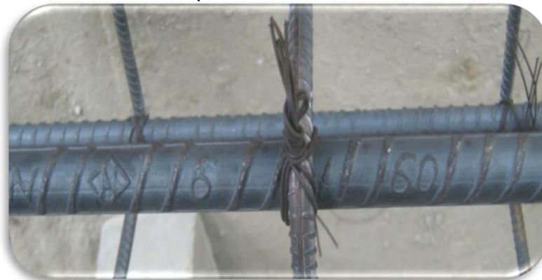
Ilustración 8. Chequeo calidad del acero de refuerzo
