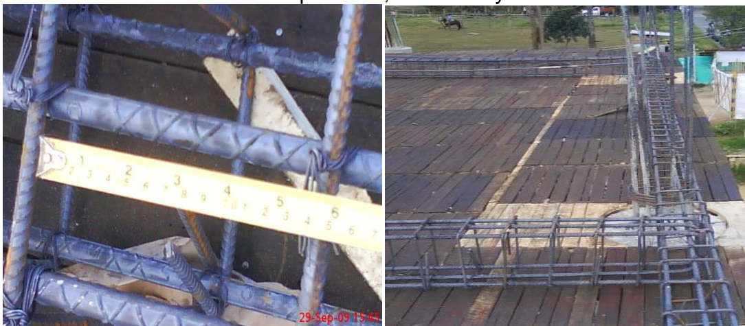
Ilustración 23. Separación, ubicación y cantidad de acero
