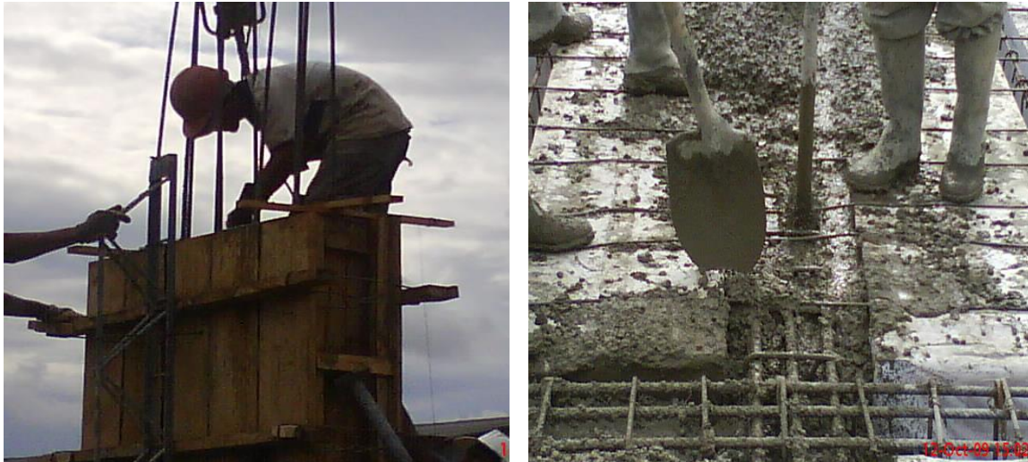
Ilustración 18. Vibrado del Concreto
