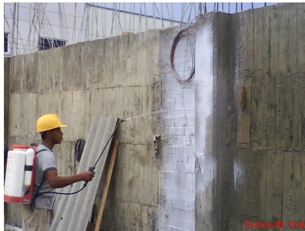
Ilustración 19. Curado de columnas
