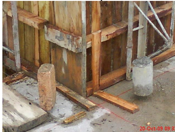
Ilustración 31. Materialización de ejes – localización de columna
