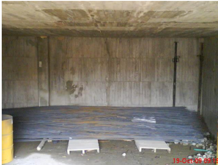
Ilustración 12. Almacenamiento del acero.
