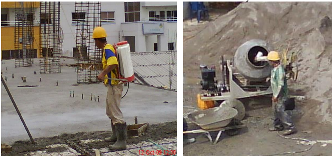
Ilustración 5. Adición de antisol blanco y de viscocrete
