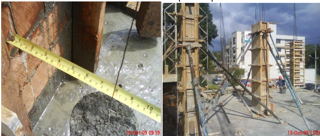
Ilustración 33. Chequeo de plomos
