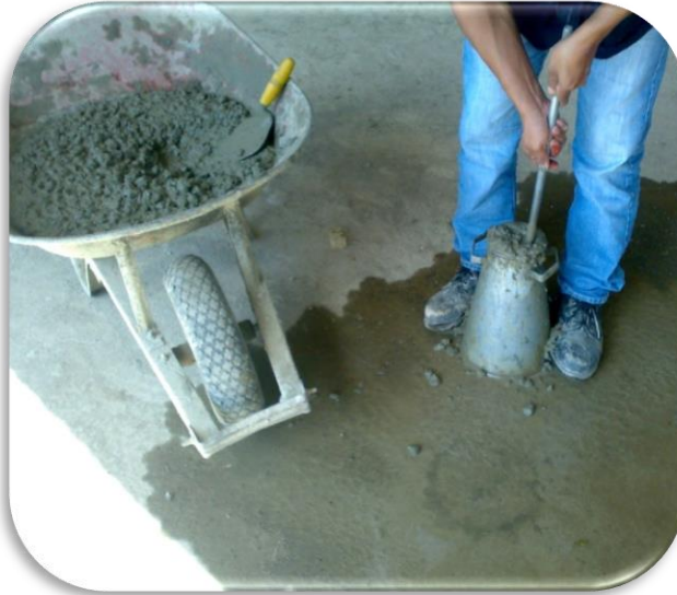
Ilustración 7. Ensayo de asentamiento del concreto.
