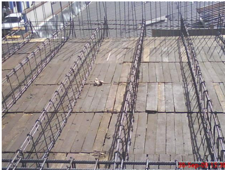
Ilustración 38. Refuerzo en viguetas
