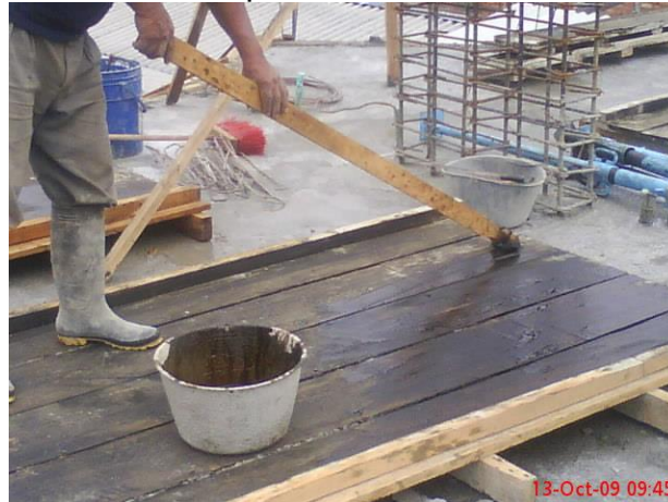
Ilustración 16. Imprimación de la formaleta con aceite
