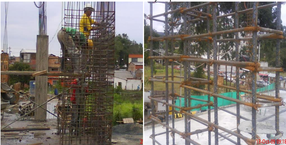
Ilustración 30. Armado del castillo de acero y separación de estribos de columnas
