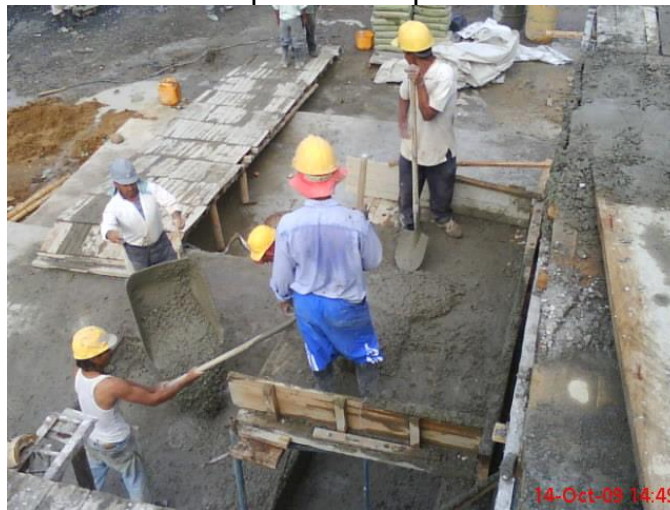
Ilustración 29. Estación provisional para elevar el concreto
