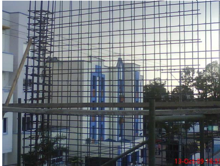
Ilustración 35. Armado del castillo de acero de pantallas
