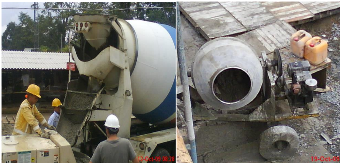
Ilustración 14. Mezclado del concreto
