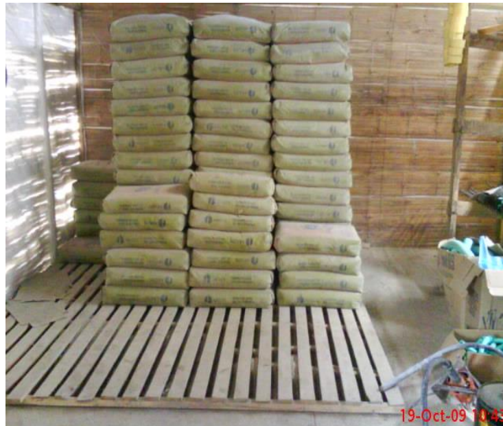
Ilustración 11. Almacenamiento del cemento.
