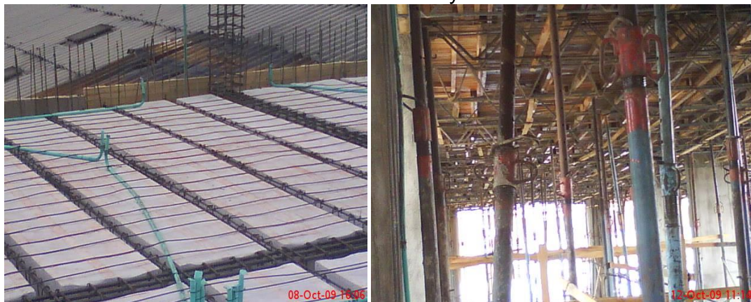
Ilustración 20. Casetones y encofrado
