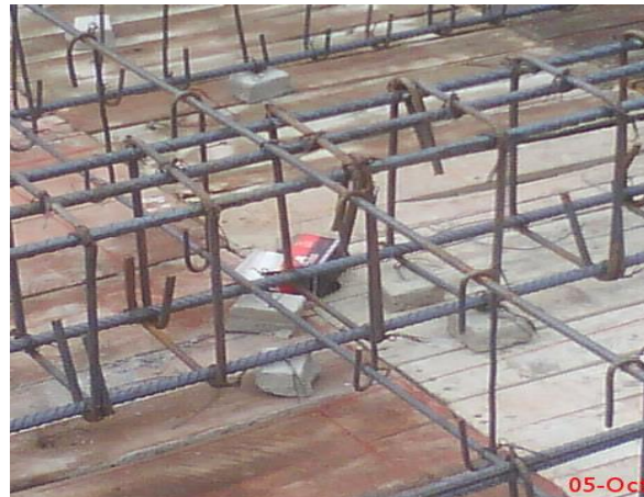
Ilustración 25. Recubrimiento del acero
