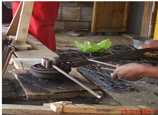
Ilustración 9. Figurado del acero
