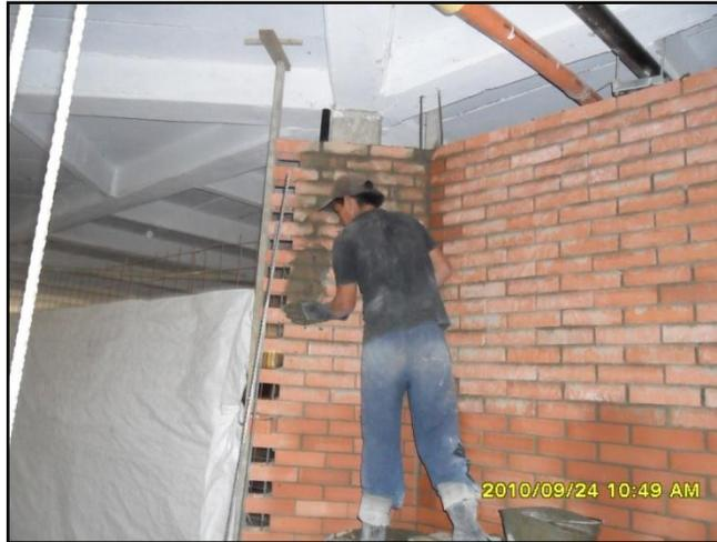
*Figura 16. Limpieza del muro.*
