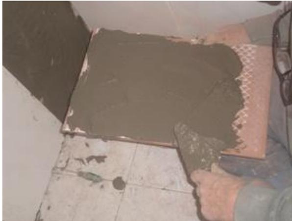
*Figura 21. Aplicación del adhesivo directamente sobre la pieza de cerámica.*
