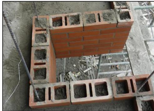
*Figura 13. Anclaje del refuerzo.*
