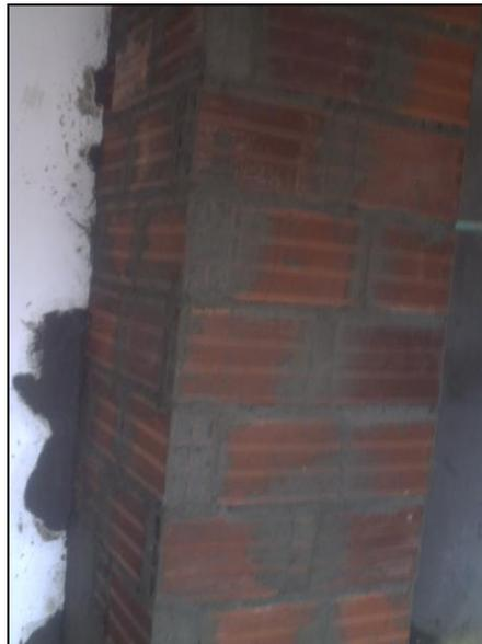
*Figura 9. Trabas generadas en la construcción de muros en ladrillo farol.*
