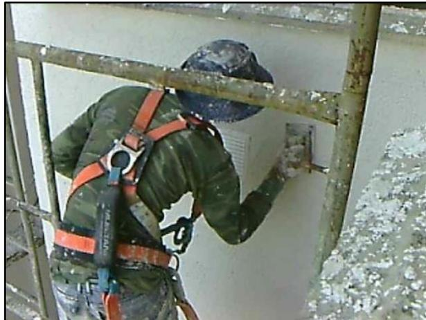
*Figura 23. Esgrafiado con platacho de madera.*
