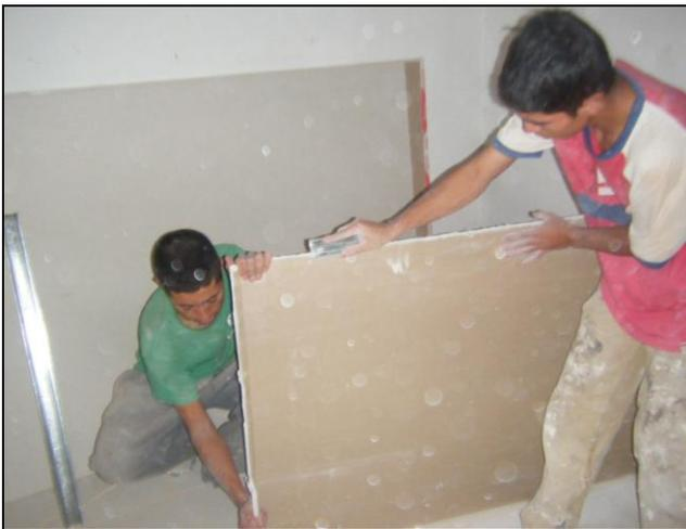
*Figura 30. Corte de lámina.*
