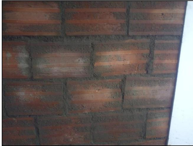
*Figura 8. Muro en ladrillo farol pegado recientemente.*
