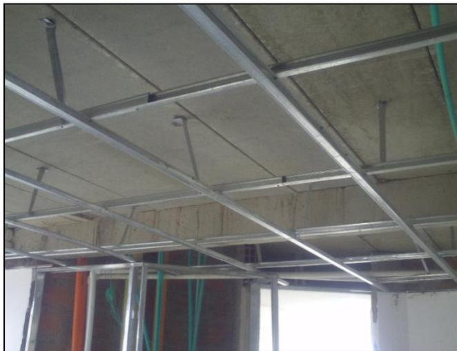
*Figura 27. Estructura de apoyo para las láminas de panel yeso.*
