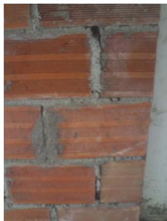
Figura 31. Revisión del mortero de pega.
