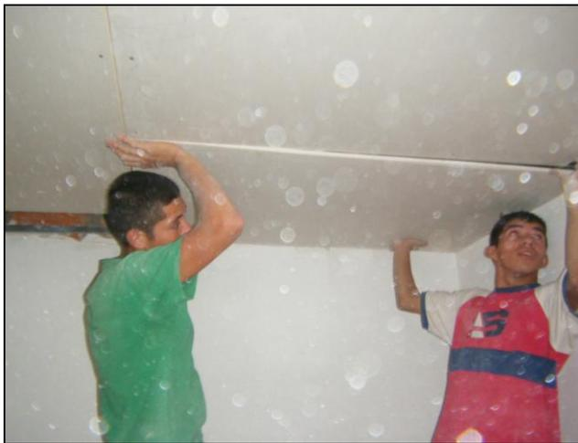
*Figura 29. Instalación de lámina de panel yeso.*
