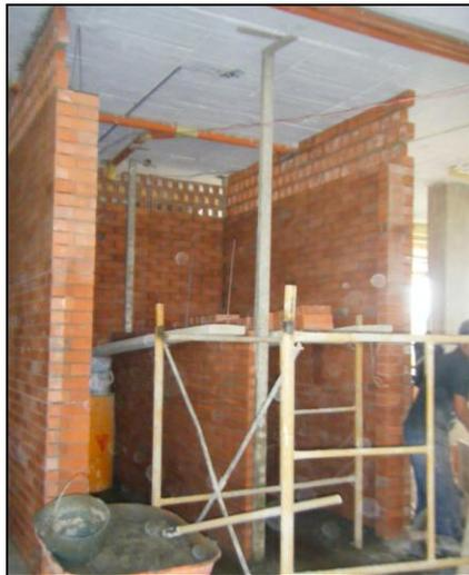
*Figura 15. Anotación del grueso de las hiladas.*
