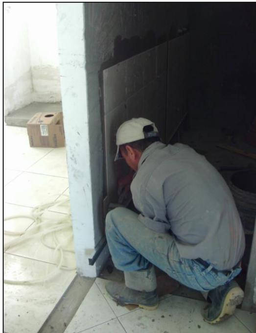
*Figura 19. Pega de cortes en los extremos.*
