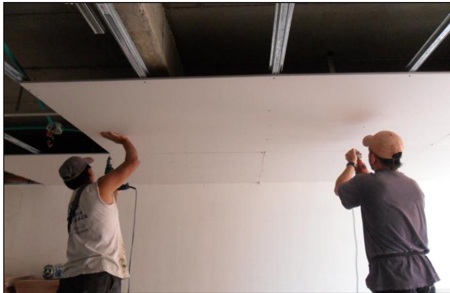
*Figura 28. Sujeción del panel con tornillos.*
