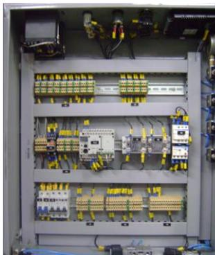
Figura 63. Armario de control y mando.
