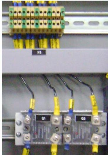
Figura 64. Borneras, riel din y canaletas.
