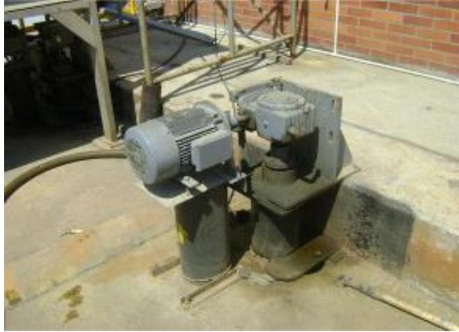
Figura 21. Sistema de agitación 1 de la PTAR-C.
