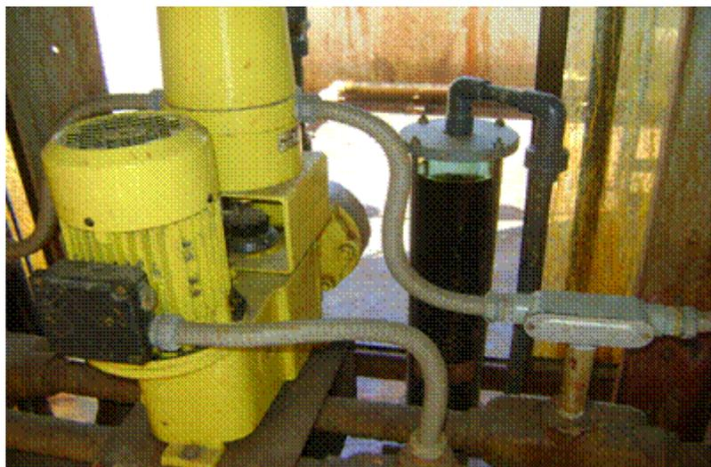
Figura 62. Sistema de dosificación de Cloruro férrico
