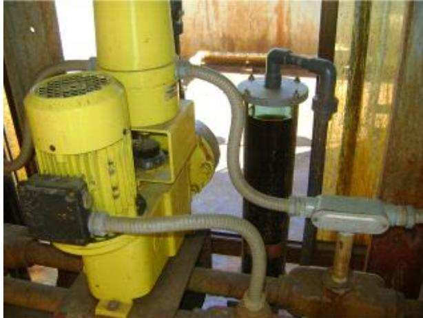
Figura 12. Bomba dosificadora de cloruro férrico.
