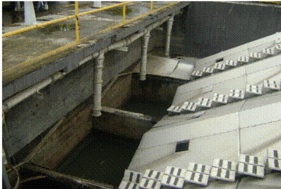
Figura 59. Sistema de bombas de tornillo parte inferior.
