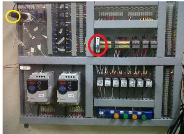
**Figura 41. Tablero de Control – Planta Multivariable**
