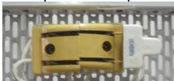
Figura G.5 Cuchilla de mando del compresor en la planta de presión del LCP
