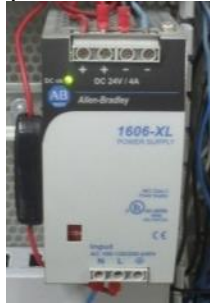
Figura G.2 Fuente de voltaje 24 VDC para DeviceNet
