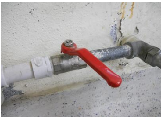
Figura 2.2. Válvula de flujo de entrada de agua domiciliaria tipo bola.
