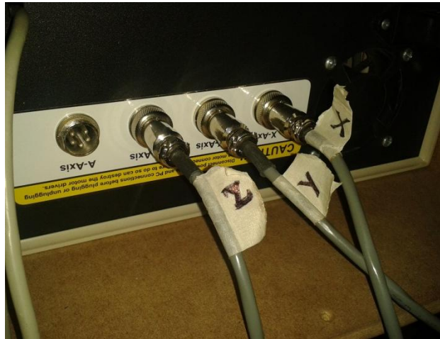
Figura 40. Conexiones de los servomotores a la controladora
