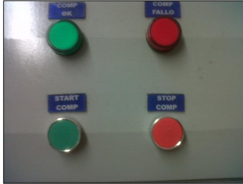
Figura C. 6 Pulsadores y pilotos para el mando del compresor en el panel HMI.
