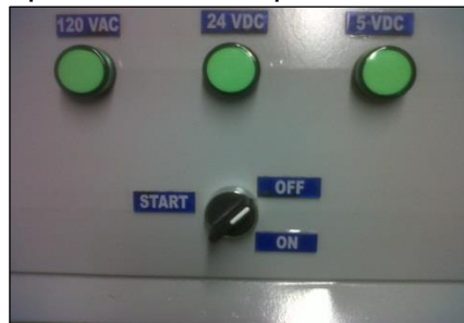
Figura C. 23 Apagado de la planta desde el panel HMI.
