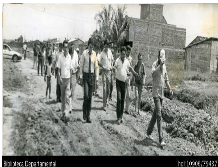
Foto No 7. Visita para pavimentar de funcionarios y otros actores
