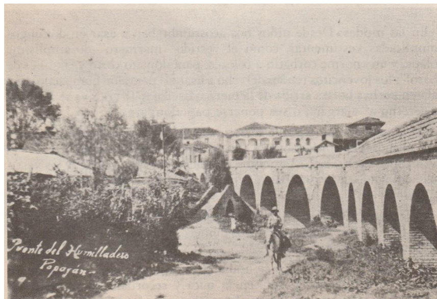
Figura 19 Puente del Humilladero
