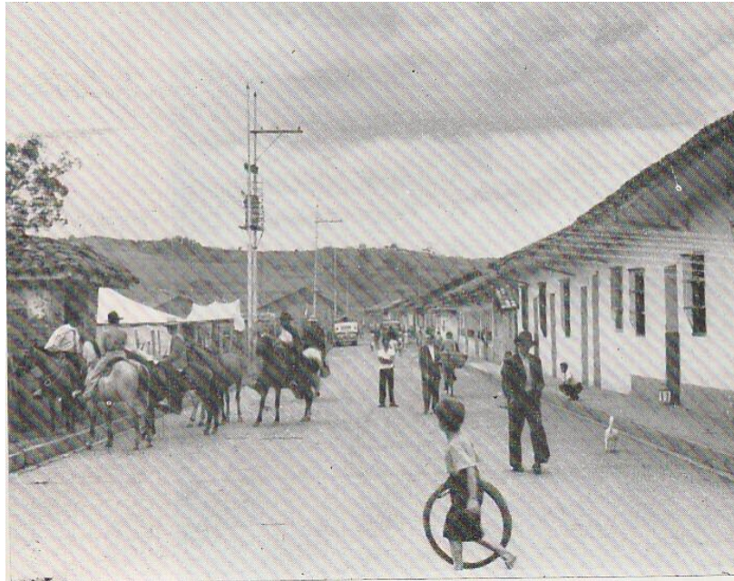
Figura 31 Popayán. Residencias de clase media-baja Construidas por la cooperativa de Artesanos y Agricultores
