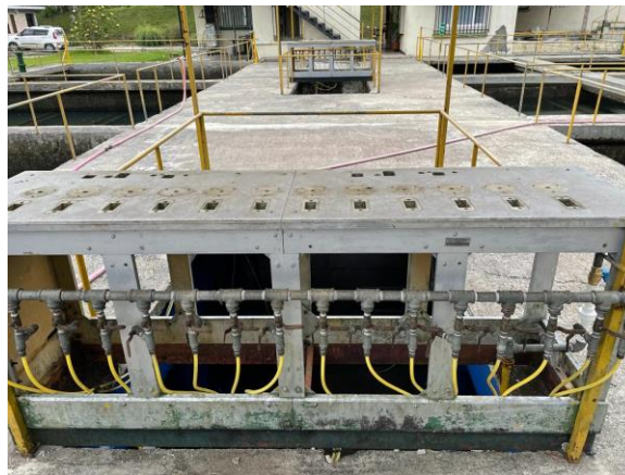
Ilustración 13. Accionadores Válvulas Neumáticas - Fuente propia
