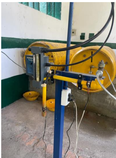
Ilustración 15. Tanques de Cloro Gaseoso - Fuente propia.
