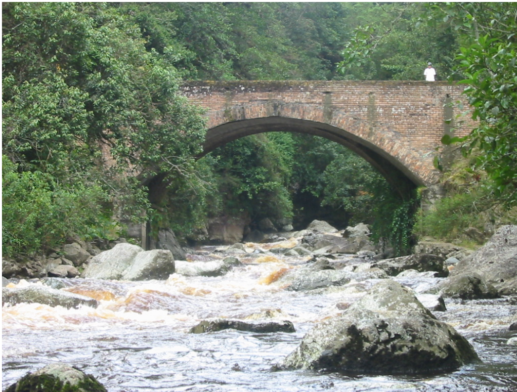
Figura 7. Vista hacia aguas arriba del tramo en estudio; río Cauca sector Patico
