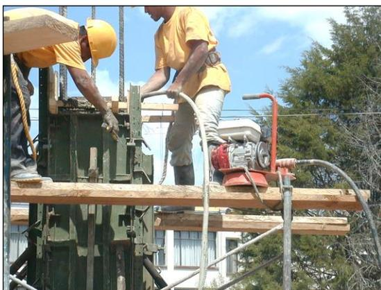
Imagen 2.09 Operaciones de vibrado y aplomo de columnas
