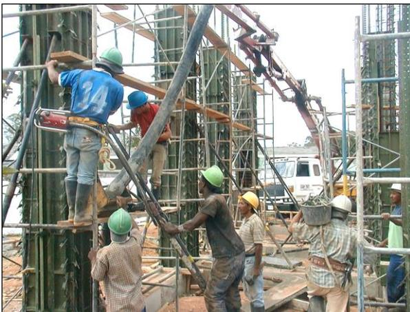
Imagen 3.18 Proceso de llenado de una columna a través de una ventana lateral.
