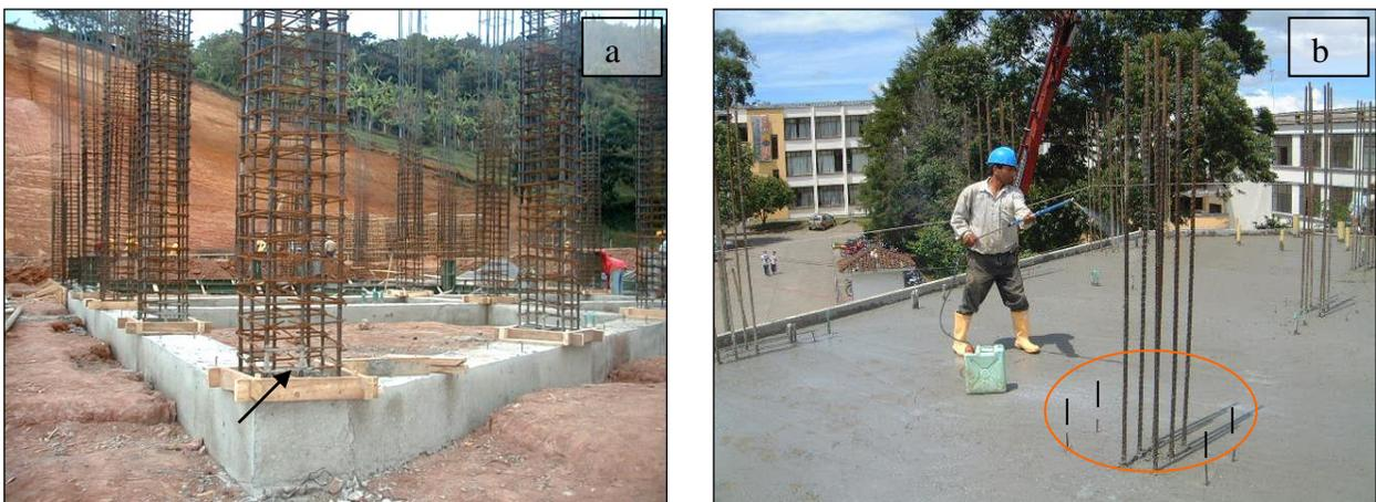
Imagen 3.14 a) Formaleta para collarín sobre viga de cimentación, b) Aplicación de Cuseal® en losa de entrepiso y detalle de taches o “pelos” incrustados en la losa para soporte lateral de la formaleta de columnas.
