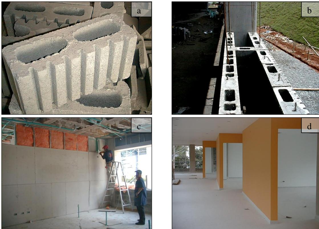
Imagen 1.08 a) Bloque para muro exterior en concreto, b) Detalle Construcción muro en bloque de concreto, c) Sistema Drywall, d) Muros interiores en Drywall.
