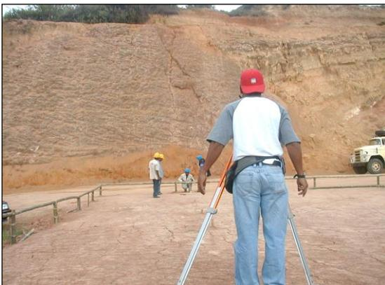
Imagen 3.06: Materialización con puntilla, de un eje principal en un caballete perimetral.
