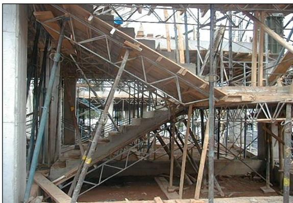
Imagen 3.31 Vista lateral de la formaleta para gradas y detalle de la estructura de soporte inferior.
