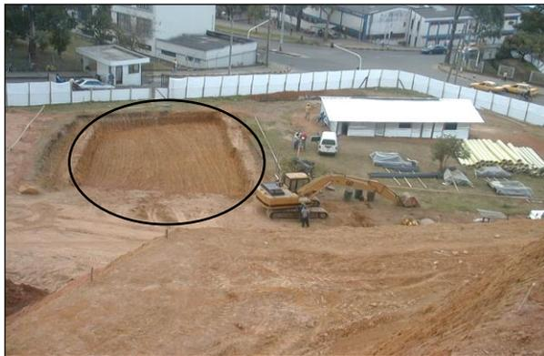
Imagen 4.01 Localización y excavación de la zona con problemas de suelo de consistencia blanda.
