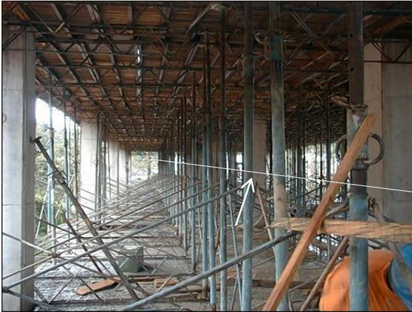
Imagen 3.21 Detalle hilo para la nivelación inferior de la formaleta de entepiso Gleason®.
