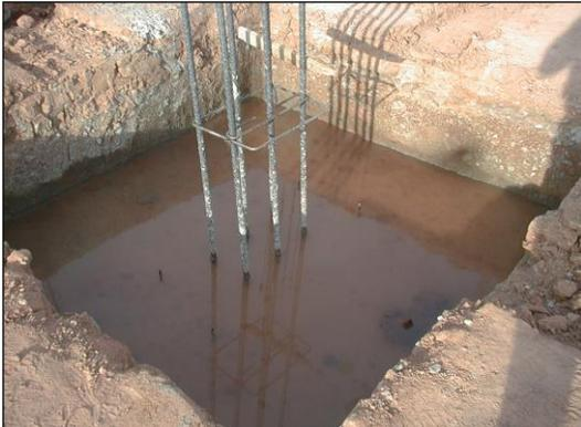
Imagen 3.11 Curado por inmersión de una zapata.
