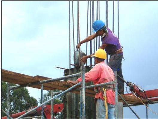
Imagen 2.10 .Vertido de mortero 1:1 previo al vaciado de una columna
