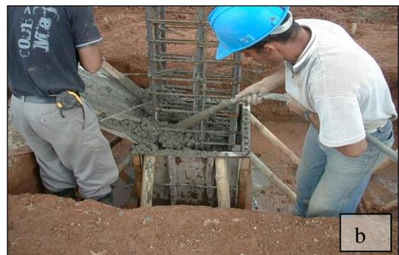
Imagen 3.12 a) Formaleta en madera para pedestales, b) Formaleta en acero y proceso de vaciado de concreto en un pedestal.
