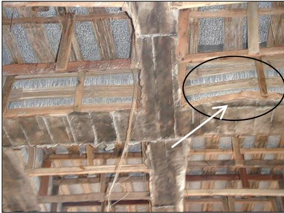
Imagen 4.04 Deformación del marco de madera y de la tela.
