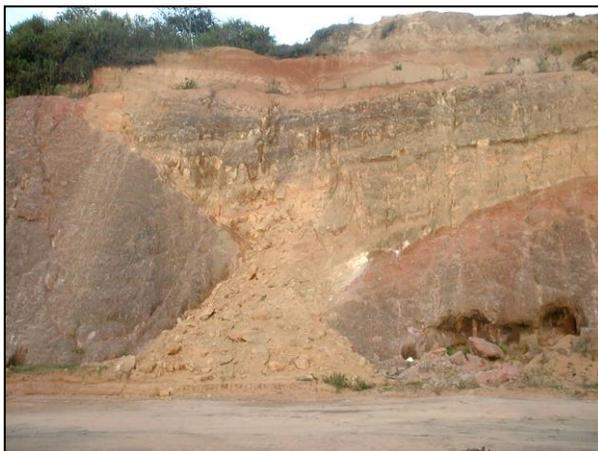
Imagen 3.02: Estado inicial del talud, evidencia de inestabilidad.
