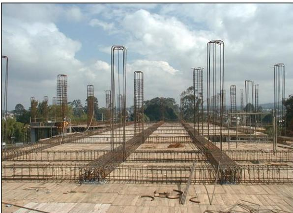
Imagen 3.22 Vista general del acero de refuerzo para losas de entepiso.
