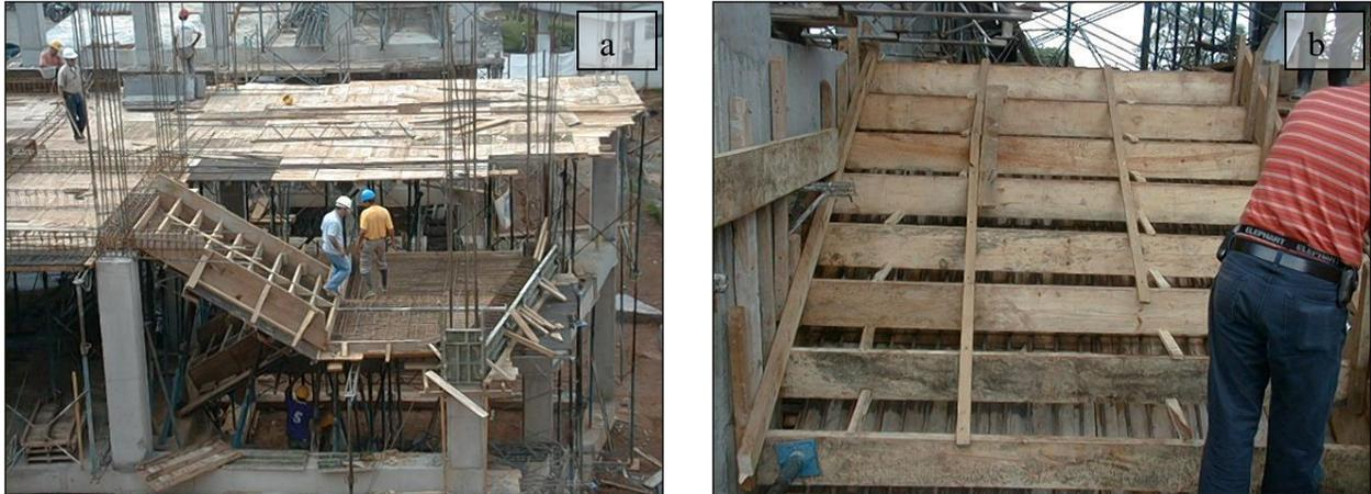
Imagen 3.30 a) Vista general de la formaleta para gradas, b) Detalle de las tablas que generan la huella y contrahuella.
