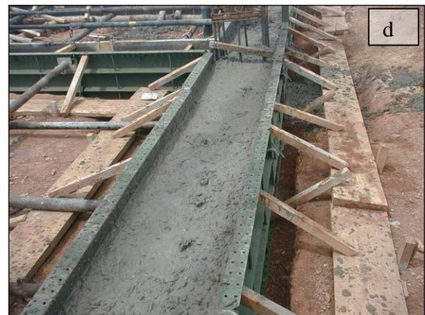
Imagen 3.13 a) Solado de limpieza para vigas de cimentación, b) Detalle cuña de separación interna, junta de formaleta en madera y pases eléctricos, c) Proceso de vaciado del concreto d) Detalle soportes laterales de la formaleta.
