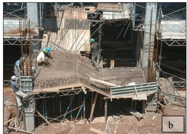
Imagen 3.29 a) Detalle de los pelos de arranque para el refuerzo de las gradadas, b) Instalación de las parrillas de refuerzo.
