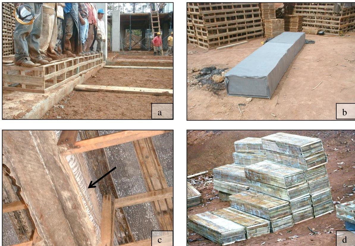
Imagen 2.05 a) Prueba de rigidez del Caseton, b) Caseton recubierto con tela sintética Casetex®, c) Detalle deformación de la tela Casetex®, d) Caseton recubierto de esterilla.
