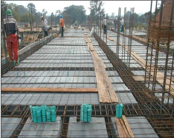
Imagen 3.23 Vista general de una losa de entrepiso lista para el vaciado de concreto, detalle de pases eléctricos y acero de retracción y temperatura en el sentido longitudinal
