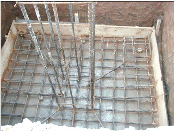
Imagen 2.01 Proceso de excavación y Tablas ubicadas para disminuir las dimensiones de las excavaciones
