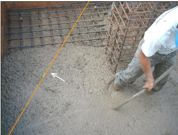
Imagen 3.10 Operaciones de vaciado y vibrado de concreto en una zapata, detalle del tensor para el acero de la columna.
