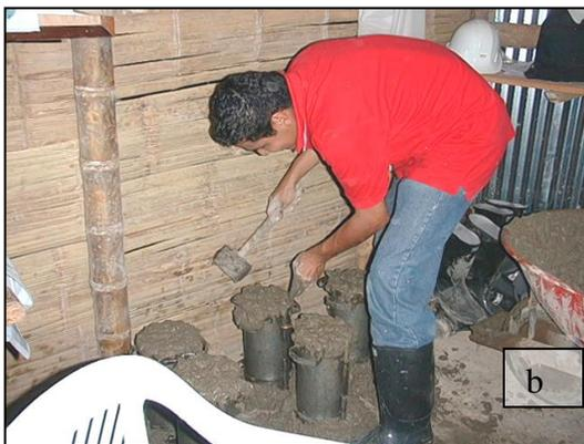
Una labor que desarrollaba con mucha frecuencia eran las revisiones que se deben realizar a los concretos certificados cuando llegan a la obra tales como: medida de la consistencia (asentamiento) con el cono de Abrams de acuerdo a la norma NTC 396, toma de muestras y fabricación de probetas o cilindros de concreto para ensayos de resistencia de acuerdo a la norma NSR 98 y a las normas NTC 454 y NTC 550 respectivamente.
