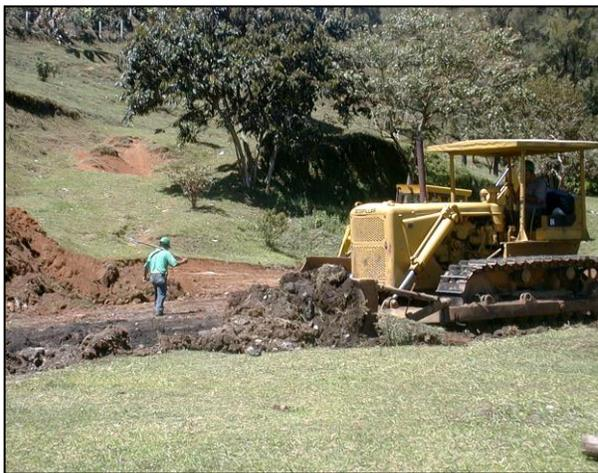
Imagen 3.01: Descapote usando Buldózer CAT-D6
