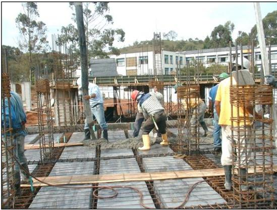
Imagen 3.24 Proceso de vaciado de concreto en losa de entrepiso.
