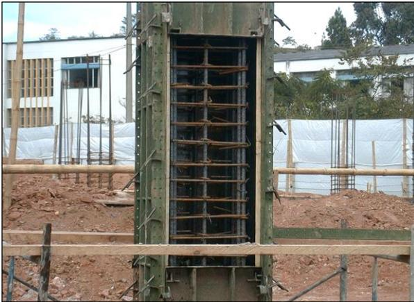
Imagen 3.17 Ventana lateral para el vaciado de una columna
