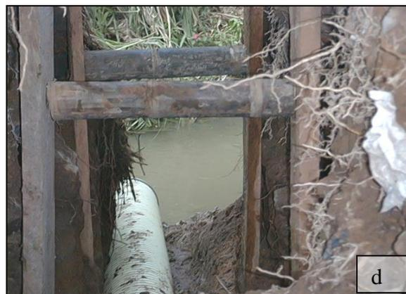
Imagen 1.14 a) Control topográfico, b) Proceso de excavación, c) Colector de aguas lluvias izquierda, colector aguas servidas derecha, d) Descarga del colector de aguas lluvias sobre el río molino.
