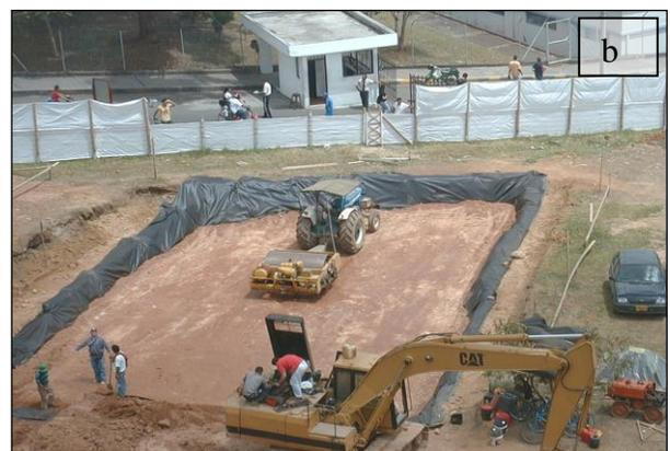
Imagen 4.02 a) Instalación del Geotextil tejido T2400, b) Proceso de compactación del material de reemplazo.
