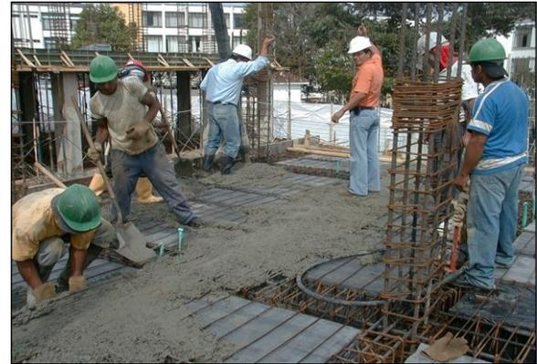
Imagen 2.08 Supervisión en fundición de columnas y placa de entrepiso bloque Administrativo.
