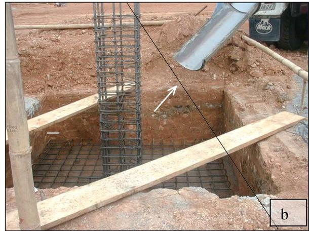
Imagen 3.09 a) verificación de la ubicación del refuerzo de columnas respecto a los ejes principales, b) Detalle del refuerzo de arranque de columnas con tensores para asegurar la posición y aplomo.
