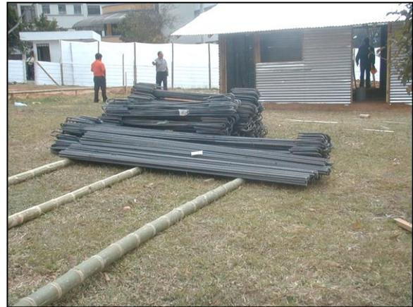
Imagen 1.17 Descargue de acero figurado
