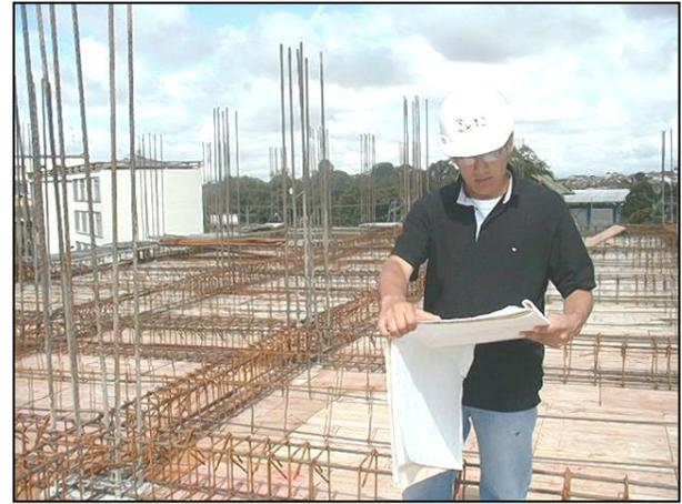
Imagen 2.02 Revisión de dimensiones, ubicación y amarre del acero de refuerzo
