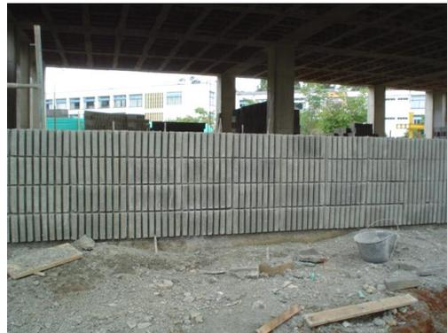
**Ilustración 17** Detalle verticalidad de canales del bloque
