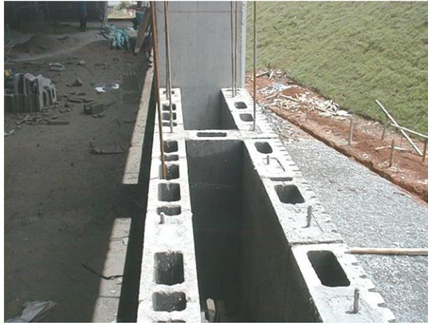
Ilustración 13 Detalle relleno de dobelas con concreto tipo grouting
