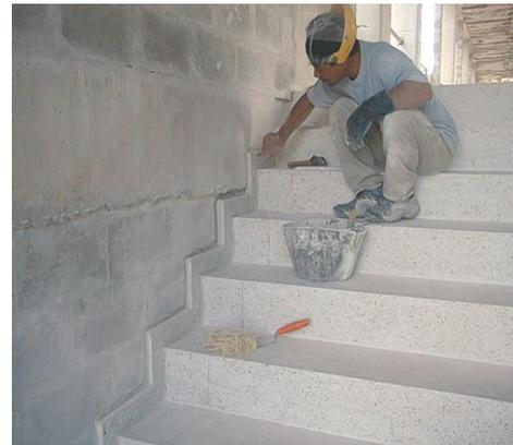
**Ilustración 69 Colocación de guarda escobas**
