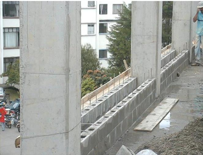
Ilustración 11 Detalle de doble muro
