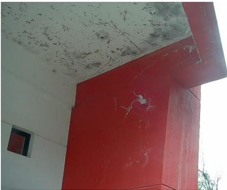
**Ilustración 89 Deterioro del mortero
