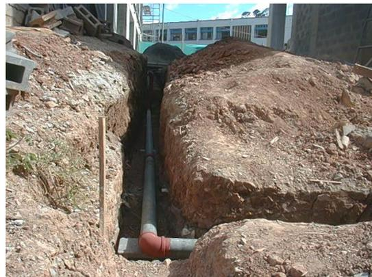
**Ilustración 44** Cambio de dirección, anclaje a muerto
