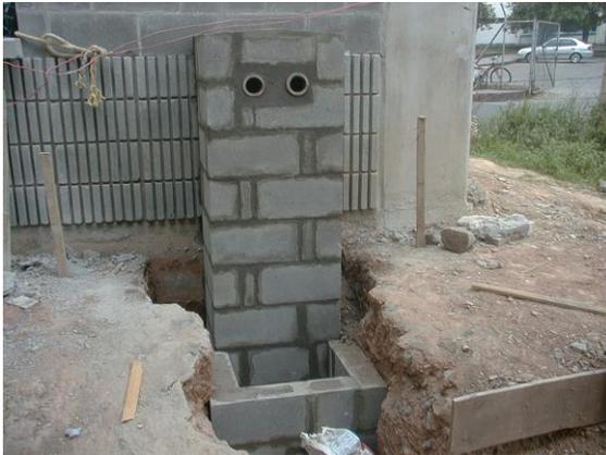
La siamesa se ubica a una altura 1.40 mt generalmente para adecuarse a la altura de una persona de estatura normal, y se protege con un buitrón construido en bloque de concreto dentro de el cual se guarda una válvula cheque y esta a su vez tiene conexión con la tubería de la
