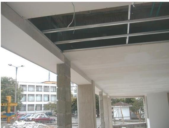
**Ilustración 82** Instalación de laminas de fibrocemento sobre la cuadrícula de soporte
