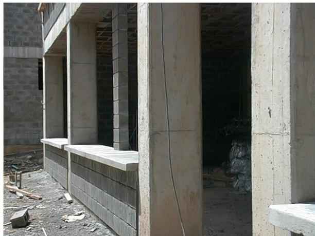
Ilustración 24 Detalle fachada Bloque A. Alfajias
