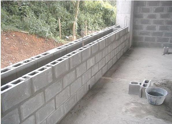
**Ilustración 12 Detalle construcción Doble muro.
