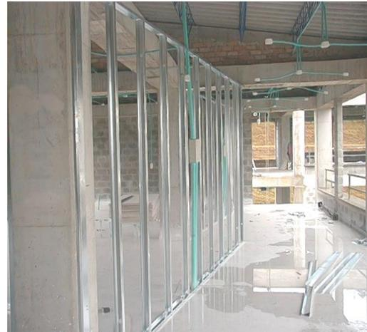
**Ilustración 73 colocación de perfilería**
