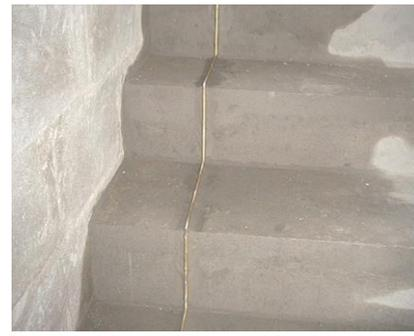
**Ilustración 66 Colocación de dilataciones**
