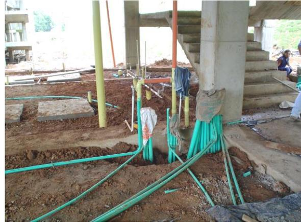
Ilustración 55 Instalación y protección de tubería
