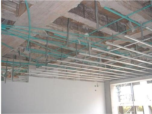
**Ilustración 81** colocación de perfilería para formar la cuadrícula de soporte
