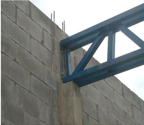
Estas cerchas se construyeron en las instalaciones del edificio y se colocaron soportadas en el otro extremo por una ménsula. Estas tienen unos ángulos anclados con una restricción de movimiento lateral y unos aros en acero de diámetro de 3/8", que evitarán el desplazamiento en presencia de sismo.
