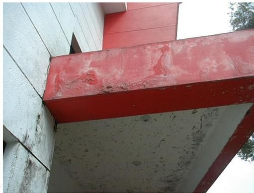
**Ilustración 90 Deterioro del mortero
