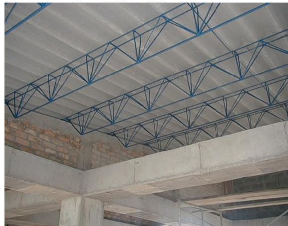
**Ilustración 34** vista interior cubierta Bloque B. correas metálicas
