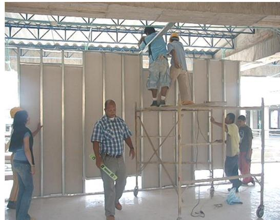
**Ilustración 74 Detalle colocación de placas en traba**
