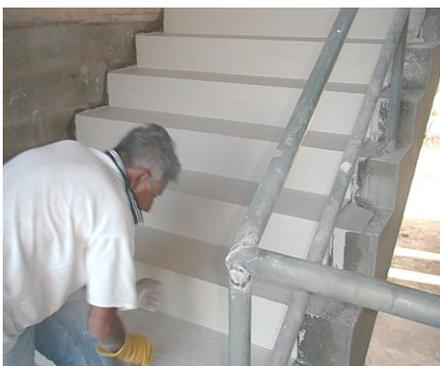
**Ilustración 67 Colocación de grano**
