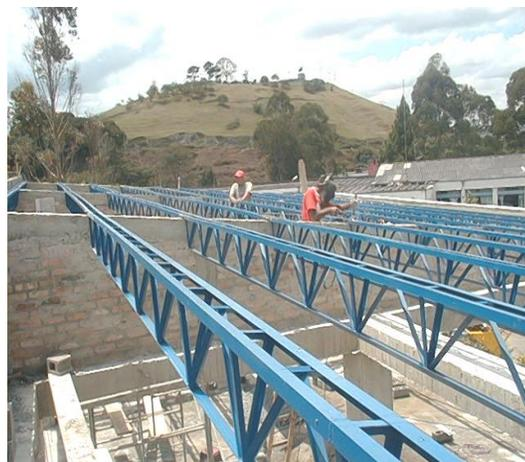
**Ilustración 33** Estructura metálica soportada en muros de culatas Bloque A
