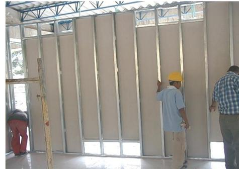
**Ilustración 79 Colocación correcta de las placas**
