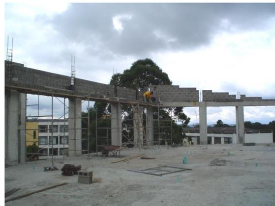
**Ilustración 40 muros de culatas perimetrales**
