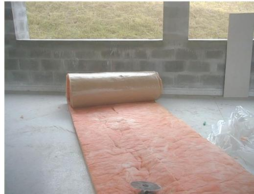
**Ilustración 78 Material aislante. Frescasa**
