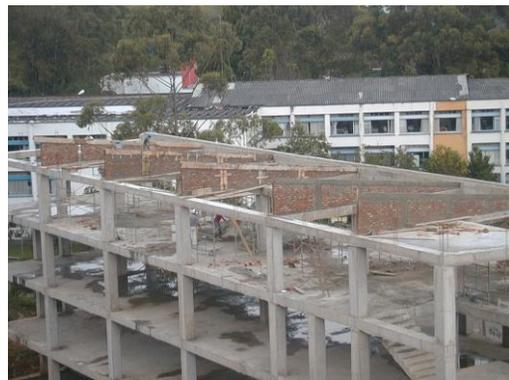
Ilustración 31 Detalle muros de culatas Bloque B
