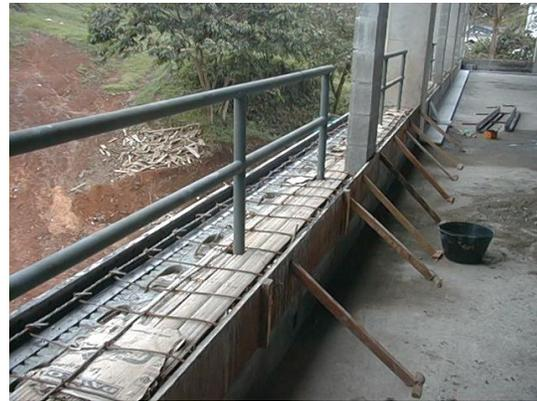
Ilustración 21 Detalle colocación de barandas previa a la fundición de alfajías
