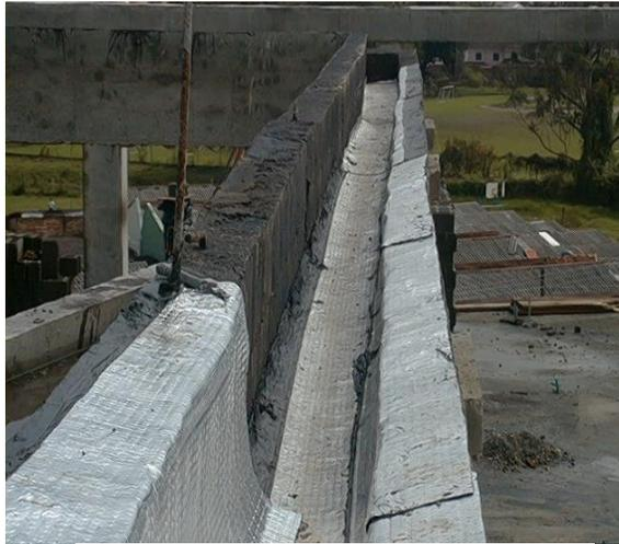
**Ilustración 28 Correcta colocación del traslazo**
