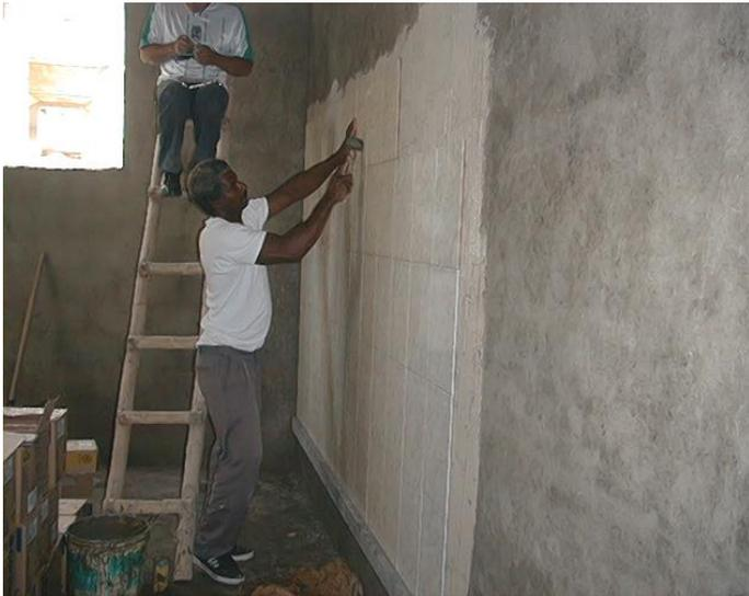
Ilustración 61 Colocación de Enchape
