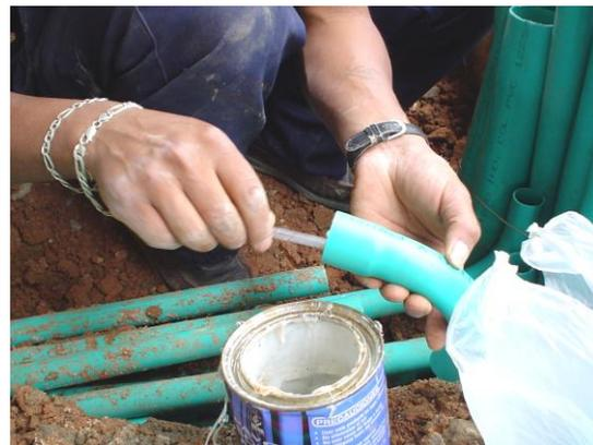
Ilustración 56 Unión de tubería con pegante PVC
