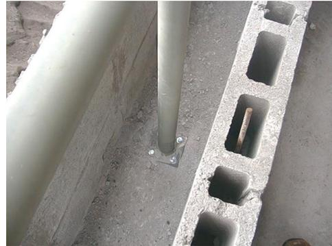
Ilustración 23 Detalle placa metálica
