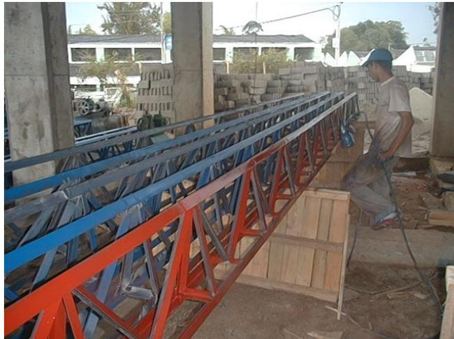
**Ilustración 32** Acabado de la estructura metálica de cubierta
