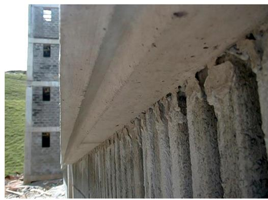
Ilustración 26 Detalle gotero
