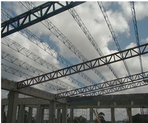
Luego se colocaron sobre estas cerchas las correas metálicas hechas en varilla lisa de grado 60 de sección triangular que se fijaron a las cerchas con soldadura. Posteriormente se colocó la teja sobre estas correas la cual se fijo con tornillos a los que se les selló su respectivo agujero con epóxicos y se montaron una sobre otra mediante unos ganchos adecuados.
