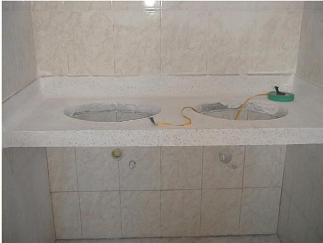
En los baños se construyeron los mesones de lavamanos, estos se hicieron anclando varillas de acero # 3/8" cada 30 cm. en las dos direcciones para formar una parrilla. Luego se colocó la formaleta para fundir una losa pequeña de concreto dejando los agujeros para los lavamanos. Después de alistar
