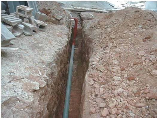
**Ilustración 43** excavación y colocación tubería
