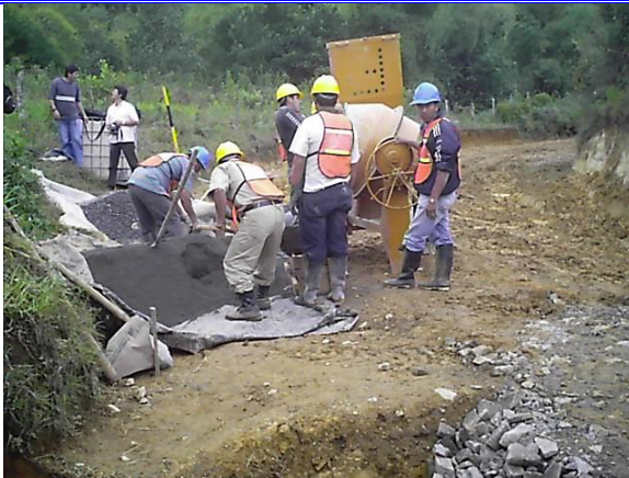
Foto No 12. Acopio de materiales
