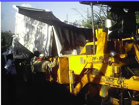
Foto No 49. Descargue de la mezcla a la finisher. K0+000
