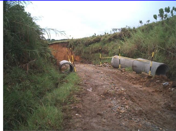
Foto No 2. Descargue de tubería
