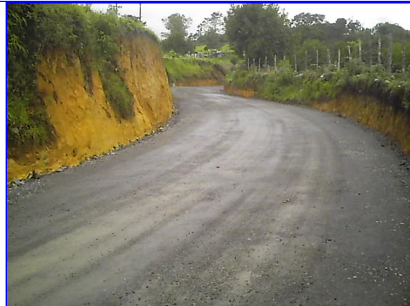
Foto No 42. Capa terminada de sub-base.
