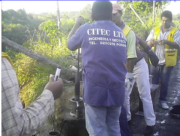
Foto No 60. Elaboración de briquetas para el control de mezcla asfáltica.
