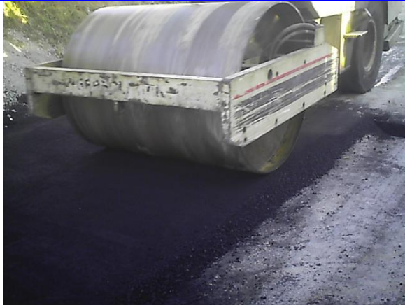
Foto No 51. Compactación de mezcla asfáltica.
