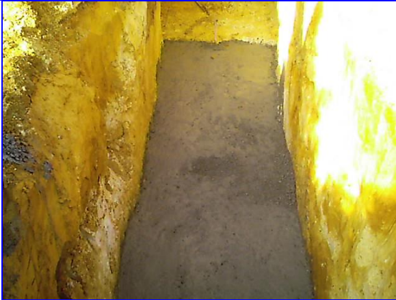
Foto No13. Solado para alcantarilla.
