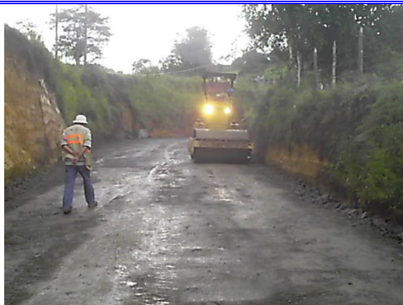
Foto No 39. Compactación capa de subbase.
