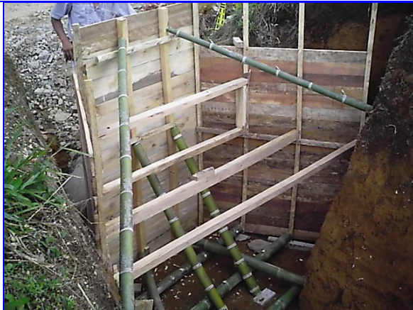
Foto No17. Formaletas para estructuras de entrada y salida de alcantarillas.
