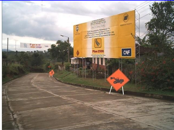
Foto No 1. Inicio de obra abscisa K0+000
