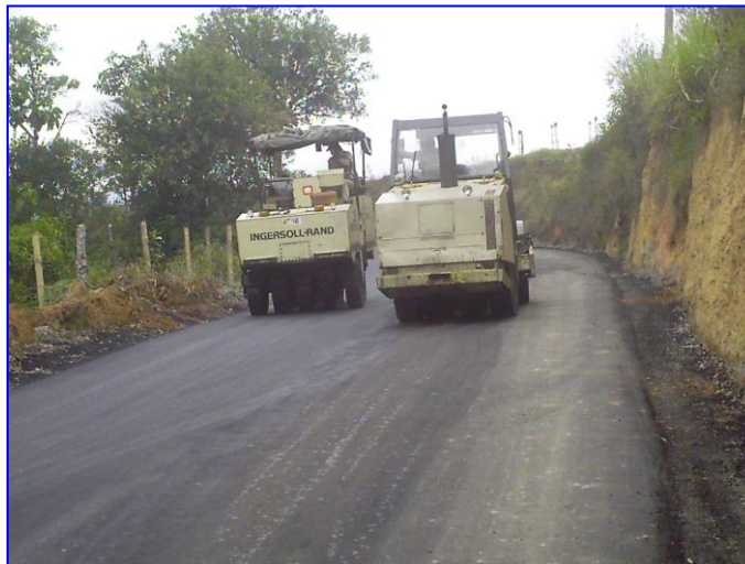
Foto No 55. Capa terminada de mezcla asfáltica
