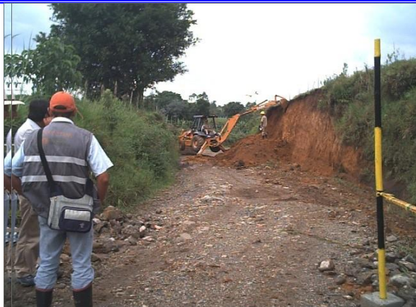
Foto No 3. Perfilado o abatimiento de talud
