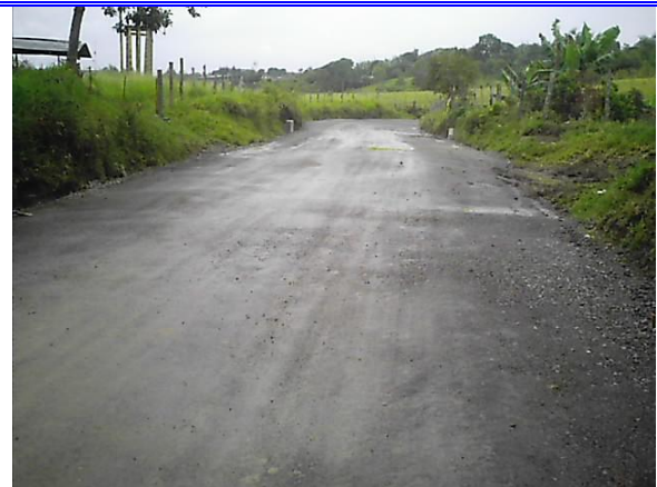
Foto No 40. Capa de subbase.
