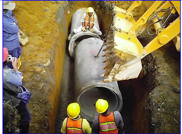
Foto No14. Instalación de tubería
