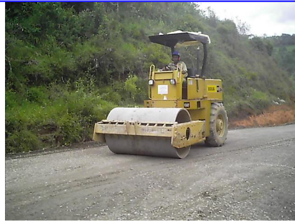
Foto No 46. Compactación capa de base.
