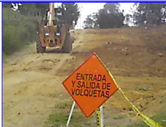
Foto No 31. Señalización y conformación botadero K3+500
