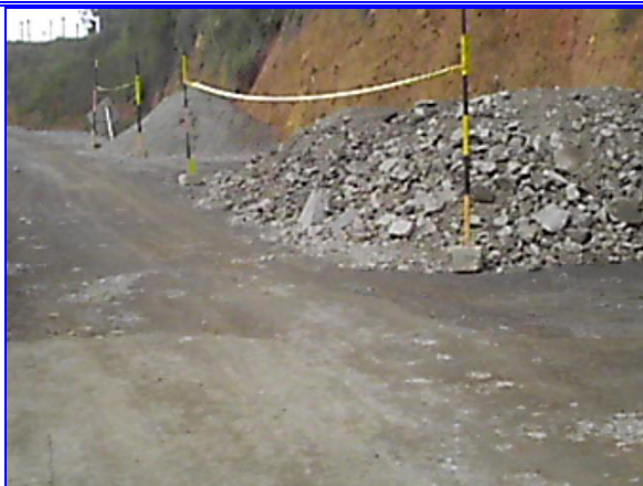
Foto No 23. Acopio de material de afirmado para mejoramiento de sub-rasante.
