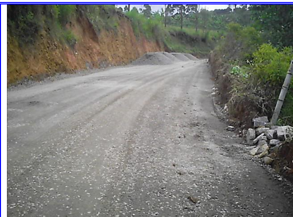
Foto No 36. Acopio de material de
