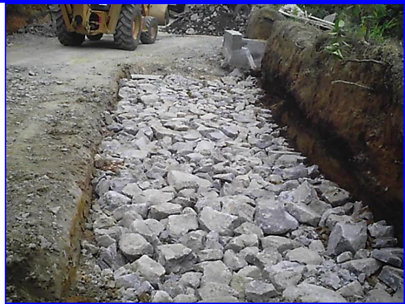
Foto No 22. Arreglo de fallos. (sobretamaños en las orillas para mayor drenaje).
