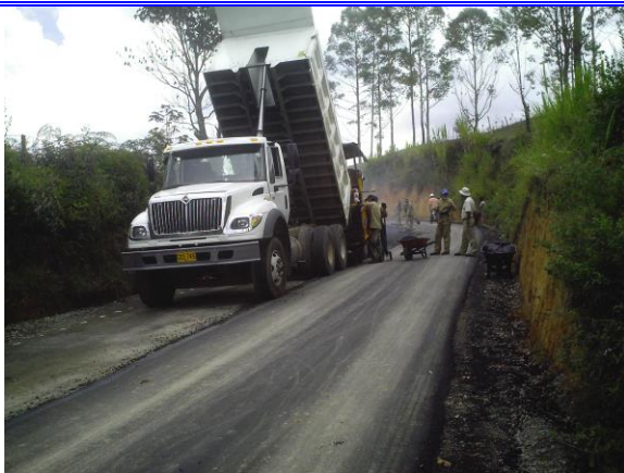
Foto No53. Colocación mezcla
