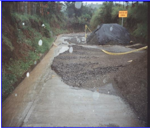
Foto No 29. Arrastre de material por la fuerte lluvia.
