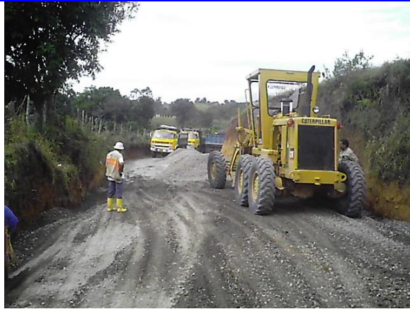
Foto No 37. Extendido de material con motoniveladora.
