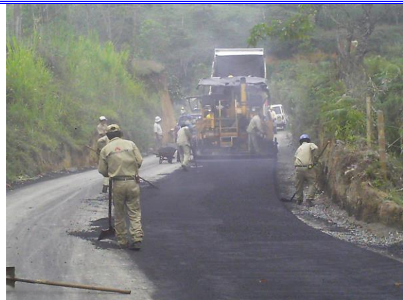
Foto No 54. Colocación mezcla K0+850
