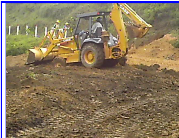
Foto No 33. Conformación botadero K0+600
