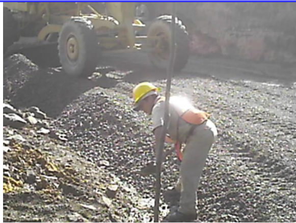
Foto No 45. Extendido de material con motoniveladora.
