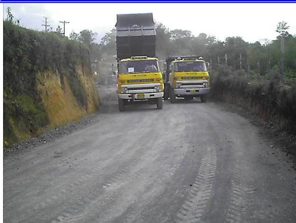
Foto No 43. Colocación de material.
