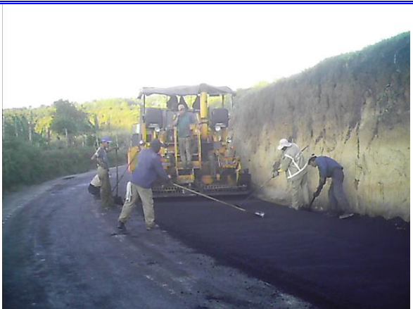
Foto No 50. Colocación de la mezcla. K0+000
