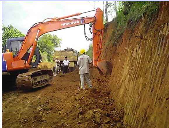
Foto No 5. Perfilado o abatimiento de talud.
