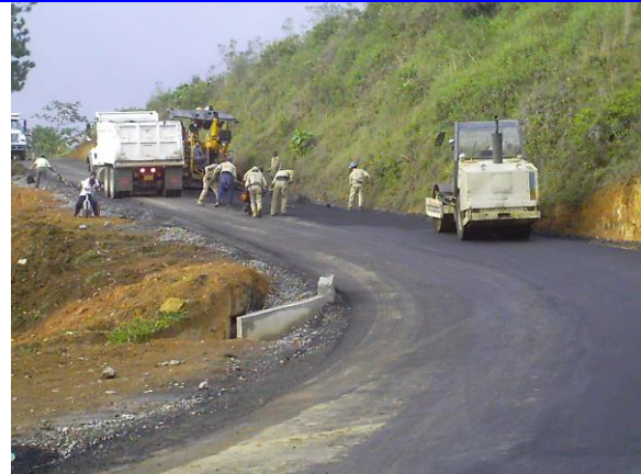
Foto No 52. Capa asfáltica. K0+600
