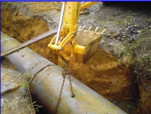
Foto No13. Solado para alcantarilla.
