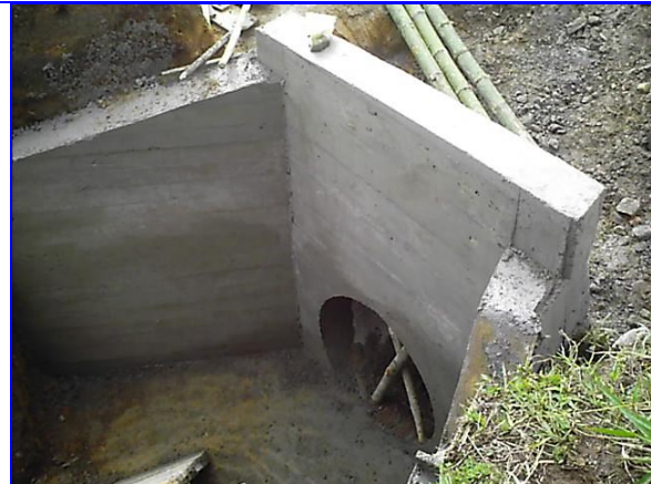
Foto No18. Caja de de salida de alcantarilla.
