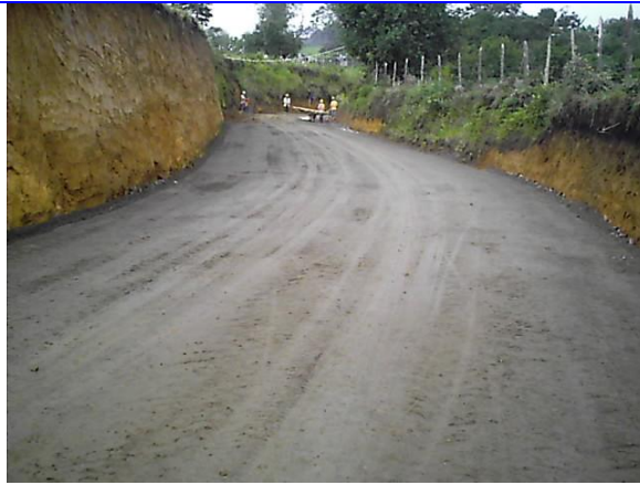
Foto No 41. Capa de subbase
