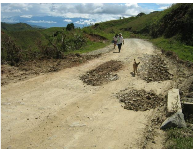
Figura 14. Trabajo rutinario – bacheo de afirmado
