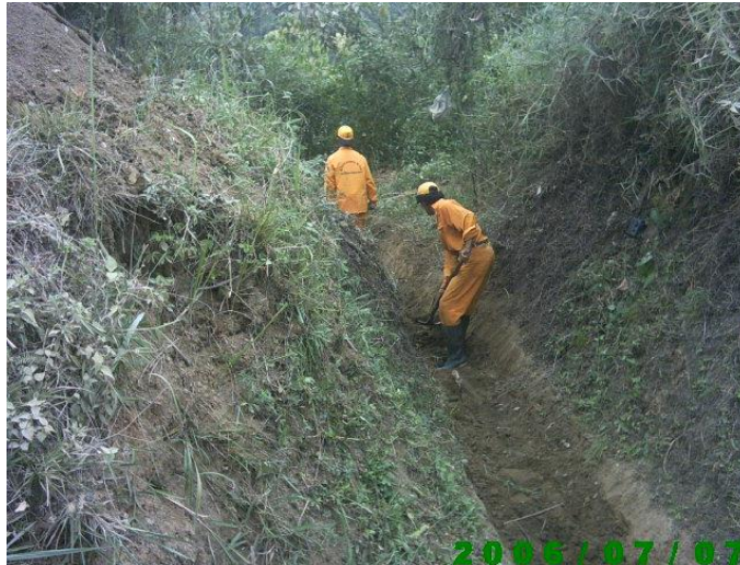
Figura 15. Trabajo rutinario – Rehabilitación descole de alcantarilla
