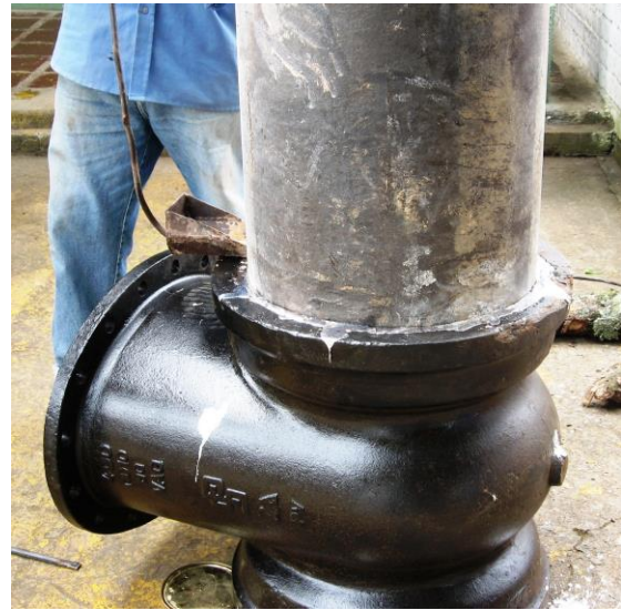
REMATE DE LA UNION CON PLOMO FUNDIDO
