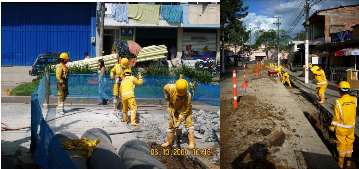
FIGURA 6.23 VISTA GENERAL PASE CALLE 4ª CARRERA 17B
