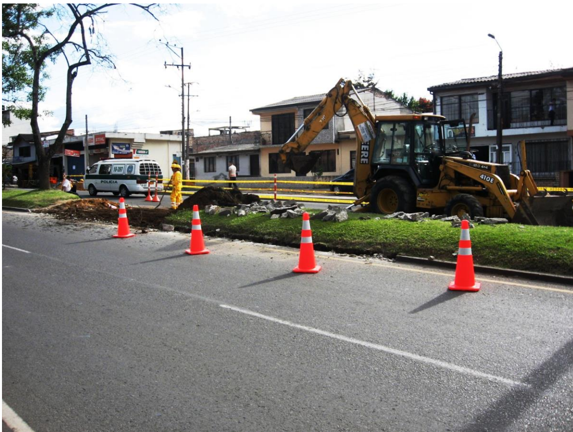
FIGURA 6.22 VISTA GENERAL INICIO DE OBRA CRA. 17 CALLE 2ª, SECTOR DE LA ESMERALDA
