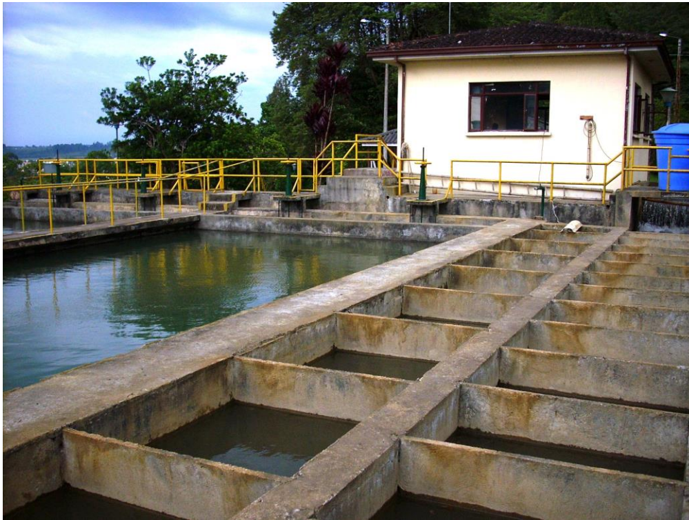
FIGURA 2. VISTA GENERAL PLANTA DE TRATAMIENTO DE TULCÁN
