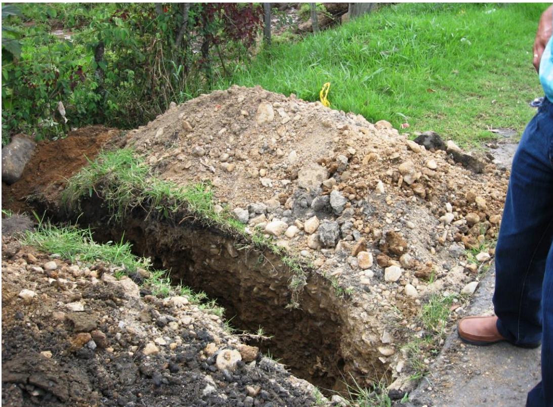
FIGURA 6.16 APIQUES PARA LOCALIZACIÓN DE LA LÍNEA DE Ø 16”, SOBRE LA CRA. 9ª, A LA ALTURA DE TORREMOLINOS
