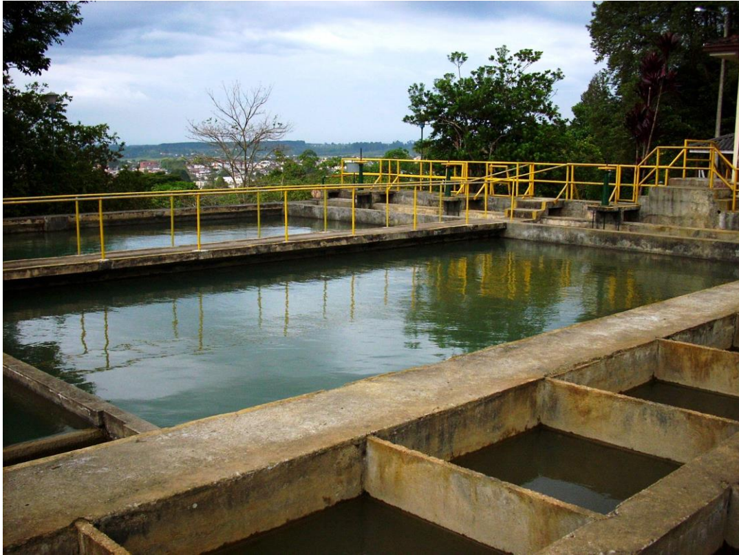
FIGURA 3. VISTA GENERAL PLANTA DE TRATAMIENTO DE TULCÁN
