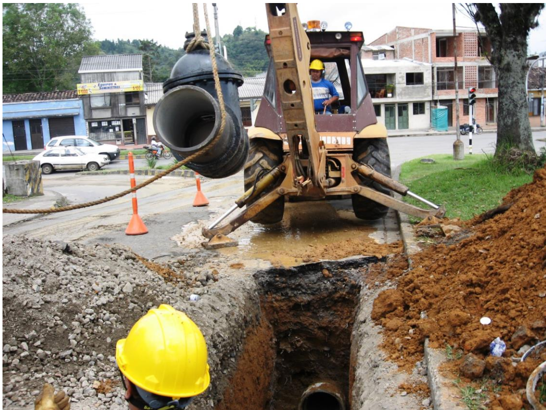
FIGURA 6.15 CALLE 18N CON CARRERA 6ª, SECTOR EL RECUERDO
