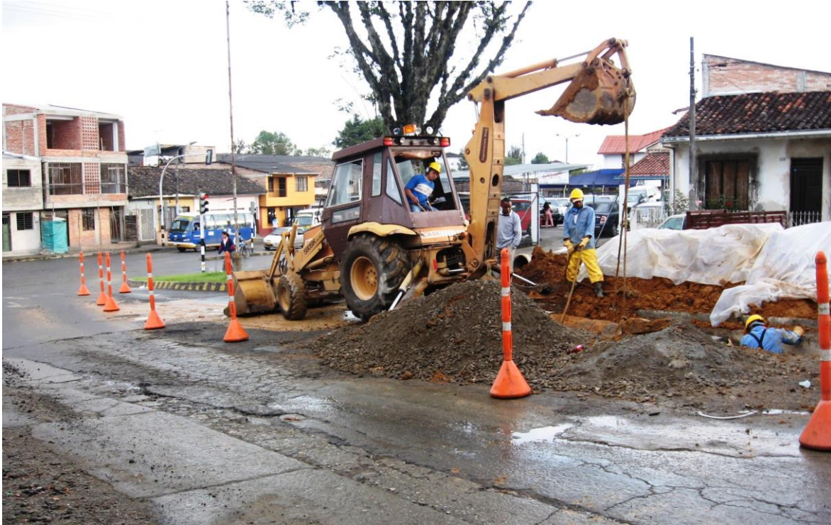
FIGURA 6.10 CALLE 18N CON CARRERA 6ª SECTOR EL RECUERDO
