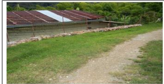
OBSERVACION: Muros para protección de la comunidad frente a posibles deslizamientos del talud vecino. Tramo II
