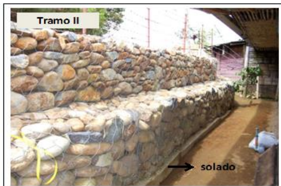
OBSERVACION: Muros para protección de la comunidad frente a posibles deslizamientos del talud vecino. Tramo II
