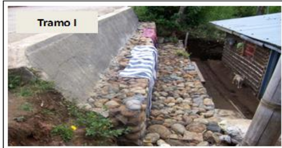
OBSERVACION: Muro que no permite el deslizamiento de la banca . Tramo I
