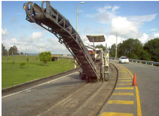
Inicio de labores de Parcheo en la Variante de Popayán Utilizando Fresadora
