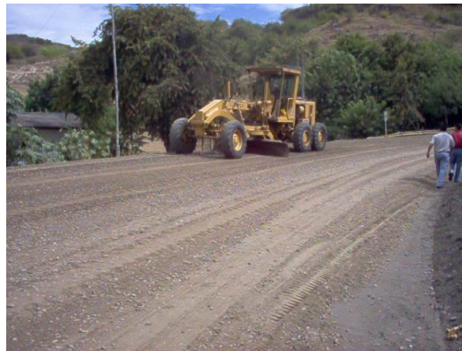
Colocación de Material de Base en PR 0 al PR 1+1000
