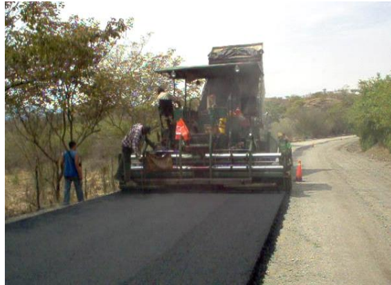
Colocación de Carpeta Asfáltica del PR 2al PR 4
