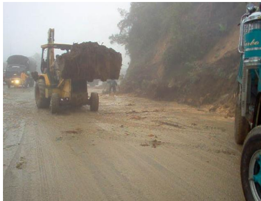
Despeje de derrumbes con maquinaria para dar paso a la vía
