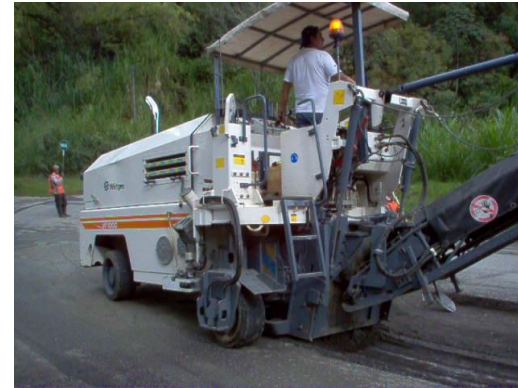
Trabajos con Fresadora para ejecución de Parcheo
