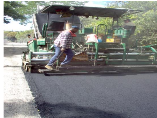
Colocación de carpeta de rodadura tramo 1, sector 2, PR 2 – PR 3
