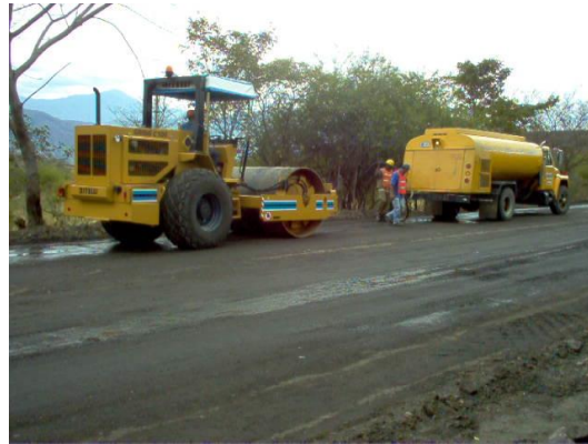
Compactación de base tramo 1, sector 2, PR 2 – PR 3
