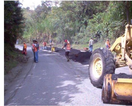
Regado de mezcla con moto niveladora
