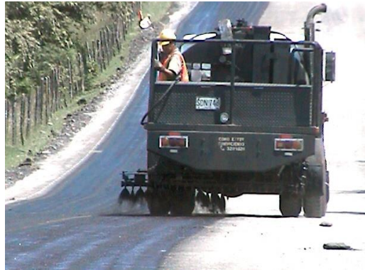
Avance de Trabajos Imprimación y Colocación de Carpeta Asfáltica en el PR 6
