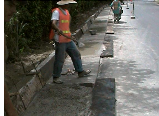
Trabajos de construcción de muro y realce de cunetas PR 4
