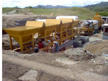
Instalación de la planta para producción de mezcla asfáltica
