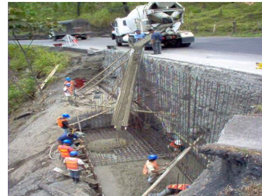
Colación de Concreto Premezclado en Muro 2 PR 90+0450
