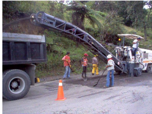
Trabajos con Fresadora para ejecución de Parcheo
