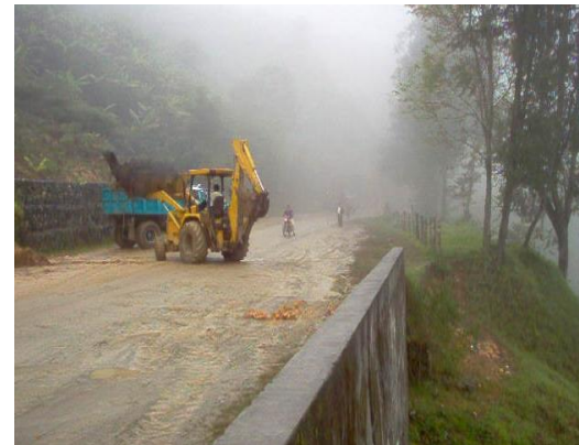
Despeje de derrumbes con maquinaria para dar paso a la vía
