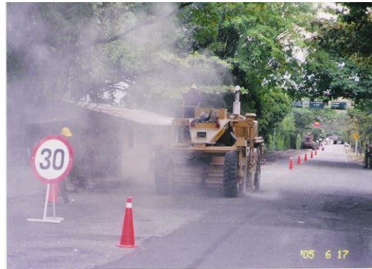
Trabajos con Recicladora en Tramo 1PR 0 al PR 1+1000
