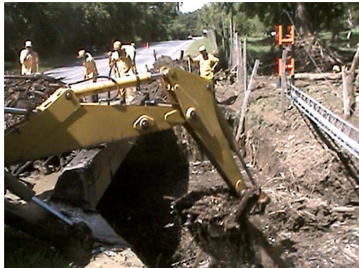
Utilización de Maquinaria para Limpieza de Pontón en PR 24
