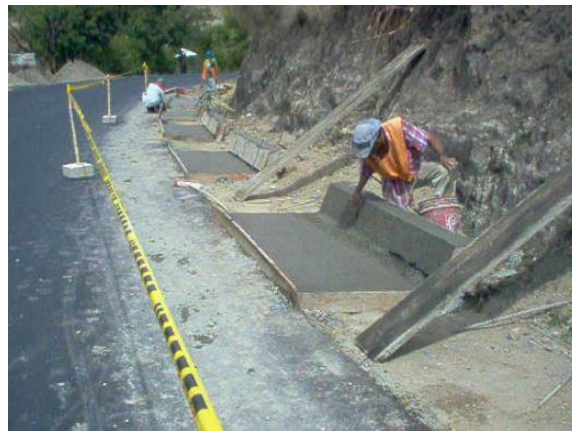
Fundición de Berma cunetas en PR 0+0400
