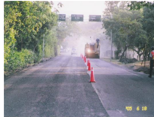
Trabajos con Recicladora en Tramo 1PR 0 al PR 1+1000
