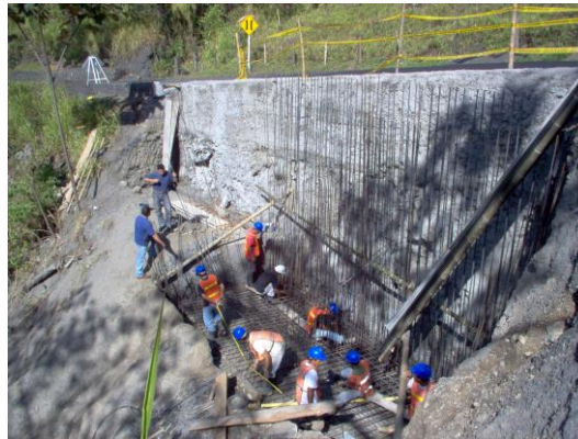
Amarre de Acero de Refuerzo en Muro 2 PR 90+0450
