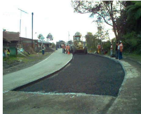
Regado de mezcla con moto niveladora
