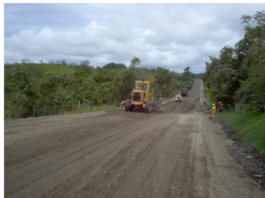
Trabajos de Colocación de Base en Tramo 1
