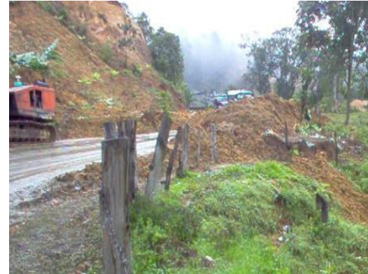
Despeje de derrumbes con maquinaria para dar paso a la vía
