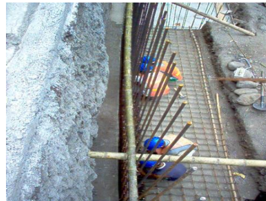
Amarre de Acero de Refuerzo en Muro 3 PR 90+0450
