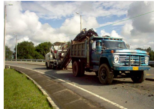
Inicio de labores de Parcheo en la Variante de Popayán Utilizando Fresadora
