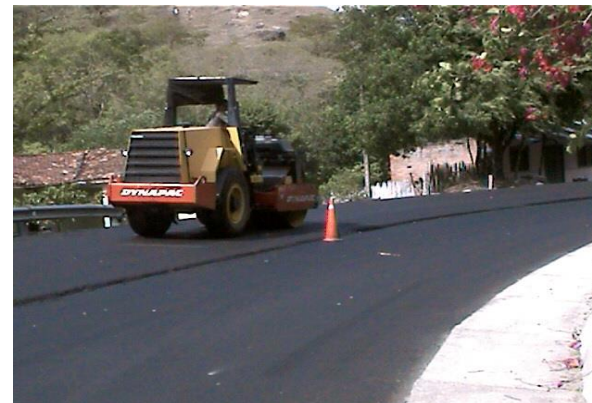
Colocación de Segunda capa de MDC-2 en Tramo 1
