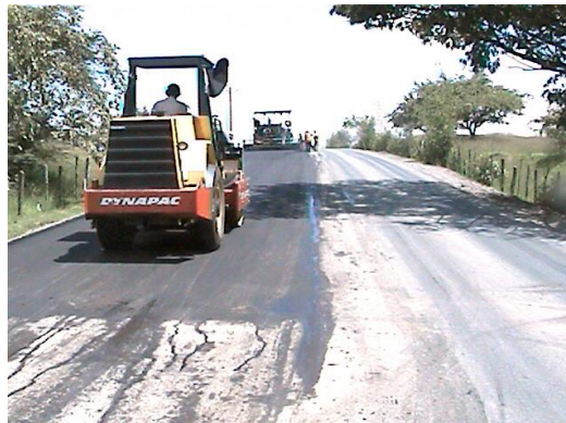
Avance de Trabajos de Compactación de Carpeta asfáltica PR 6
