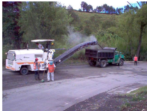
Cargue y Transporte del Material Fresado
