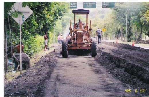
Colocación de Material de Base en PR 0 al PR 1+1000
