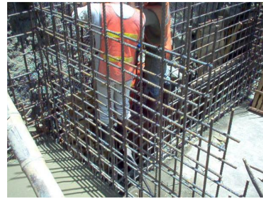
Inspección de Acero Instalado en Muro 2 PR 90+0450
