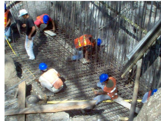
Amarre de Acero de Refuerzo en Muro 2 PR 90+0450
