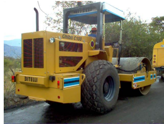
Compactación de base tramo 1, sector 2, PR 2 – PR 3
