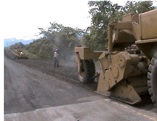
Avance de Trabajos con Resicladora en PR 7
