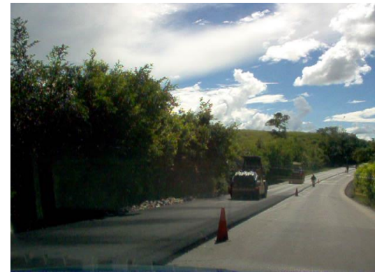
Avance de Trabajos de Compactación de Carpeta asfáltica PR 6
