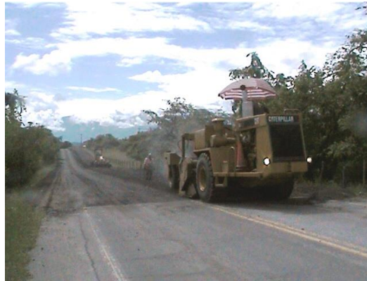
Avance de Trabajos con Resicladora en PR 7
