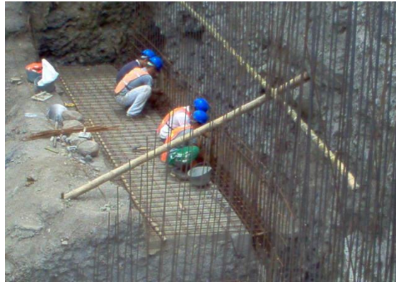
Amarre de Acero de Refuerzo en Muro 3 PR 90+0450
