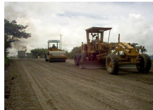
Trabajos de Colocación de Base en Tramo 1
