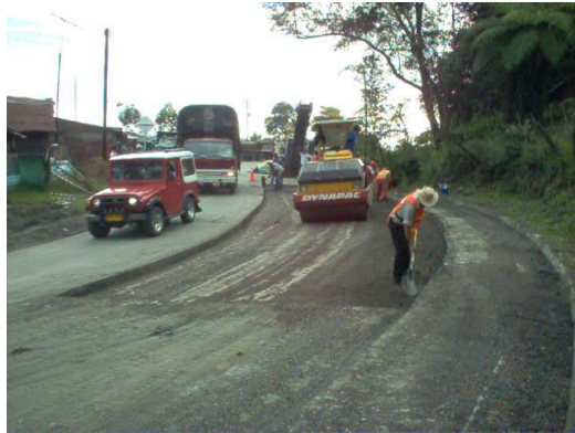
Compactación del Material De Base En Zona De Bacheo
