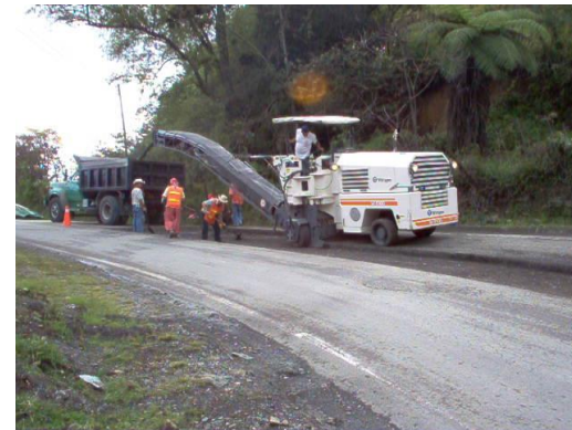
Cargue y Transporte del Material Fresado
