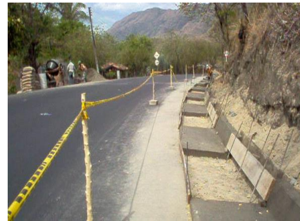
Fundición de Berma cunetas en PR 0+0400
