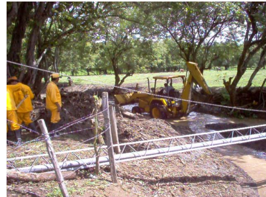
Utilización de Maquinaria para Limpieza de Pontón en PR 24
