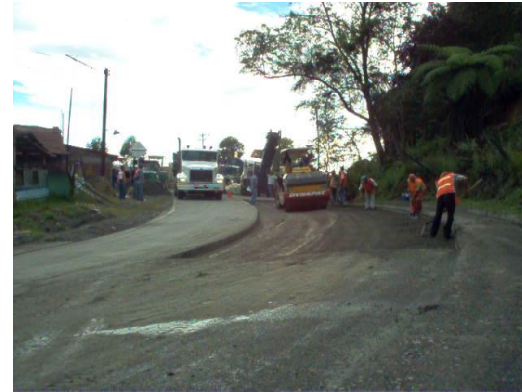
Compactación del Material De Base En Zona De Bacheo
