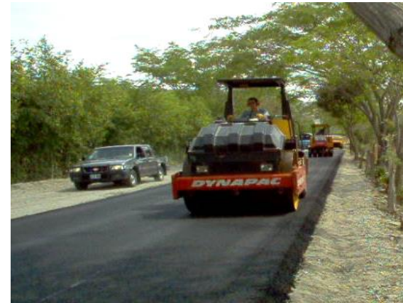
Colocación de Carpeta Asfáltica del PR 2al PR 4
