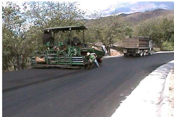
Colocación de Segunda capa de MDC-2 en Tramo 1
