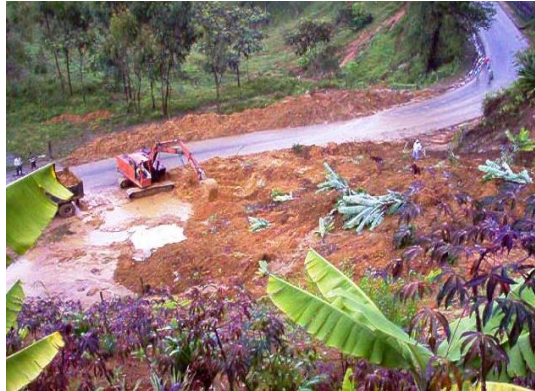
Despeje de derrumbes con maquinaria para dar paso a la vía
