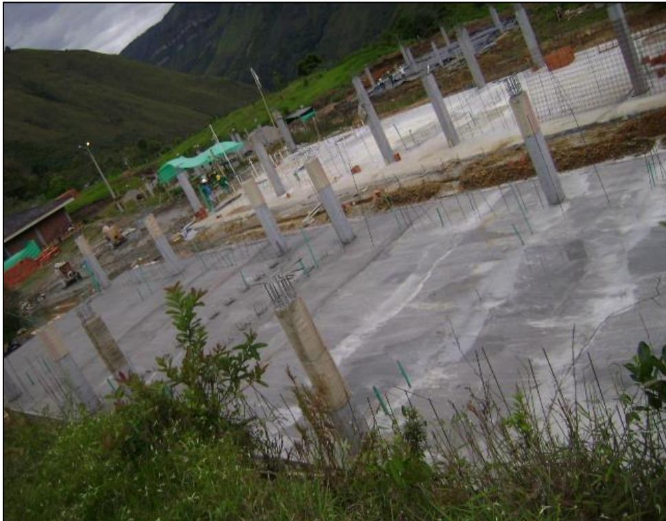
Foto 32. Placa de concreto de los Aulas y la batería sanitaria.
