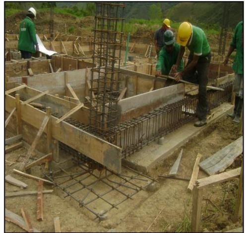
Foto 17. Refuerzo de zapatas, vigas de cimentación y columna.
