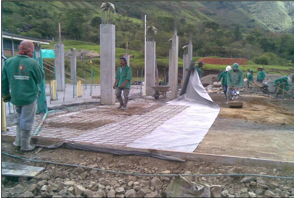
Foto 31. Geotextil, malla electrosoldada y fundición de la placa de contrapiso
