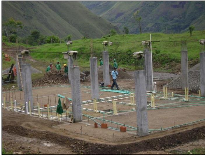
Foto 21. Instalaciones hidráulicas y sanitarias del laboratorio
