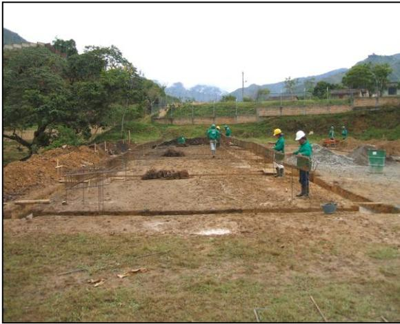
Foto 16. Refuerzo de vigas del Bloque B
