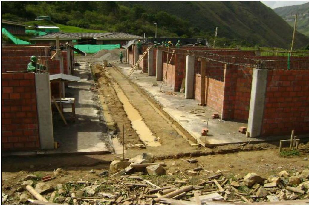
Foto 33. Un sistema mixto de mampostería de cavidad reforzada y pórtico.
