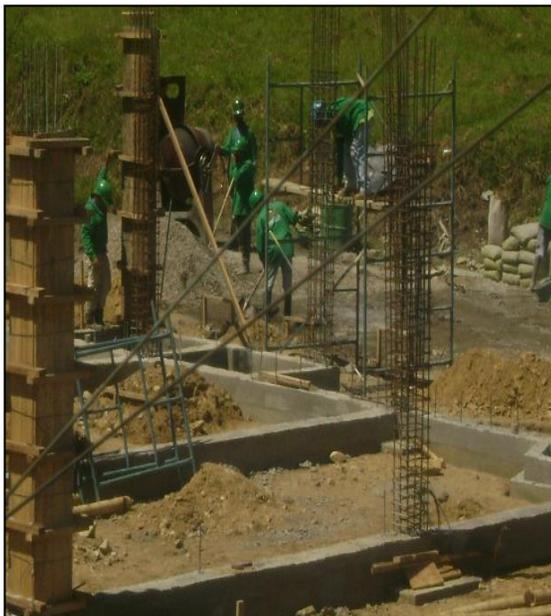
FOTO 26. ARMADA DE 48 COLUMNAS EN TODA LA OBRA
