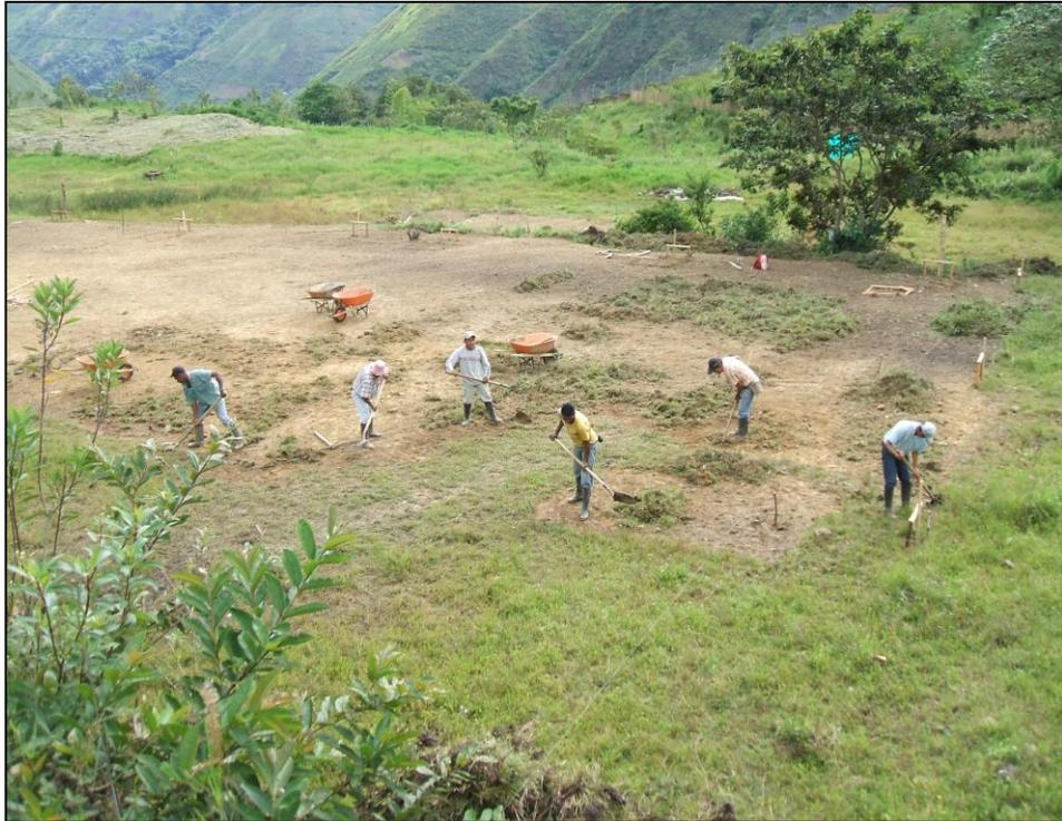
Foto 6. Descapote de las áreas donde van las tres estructura.
