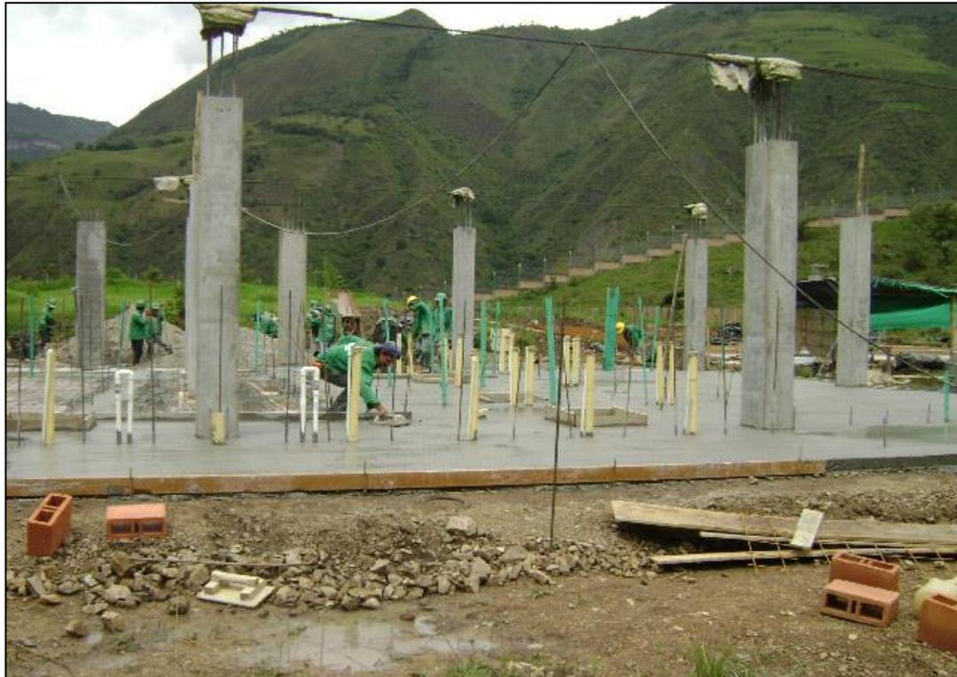
Foto 25. Columnas en concreto a la vista
