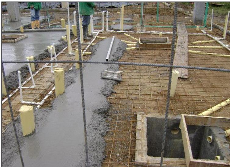
Foto 20. Cajas de inspección de la batería sanitaria.
