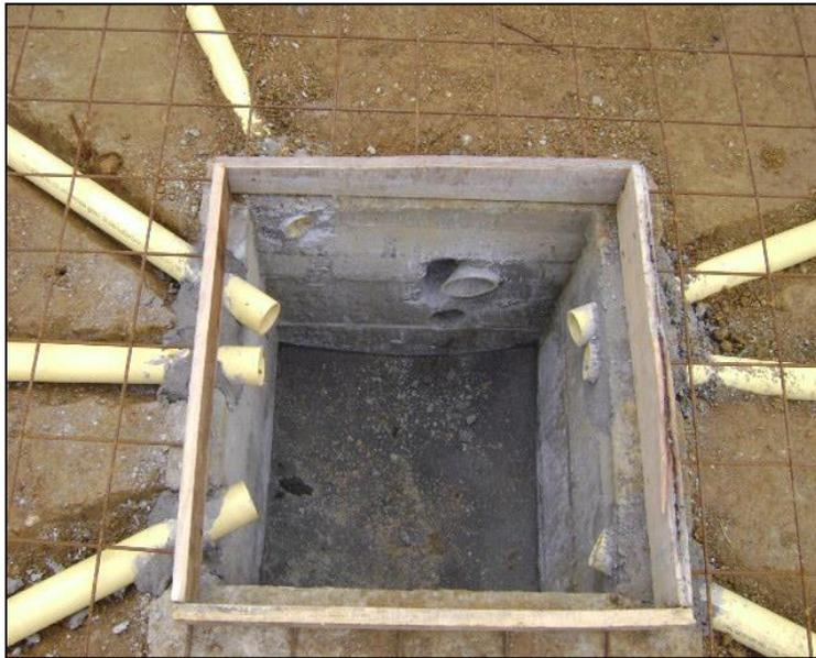
Foto 19. Caja de inspección de la batería sanitaria.
