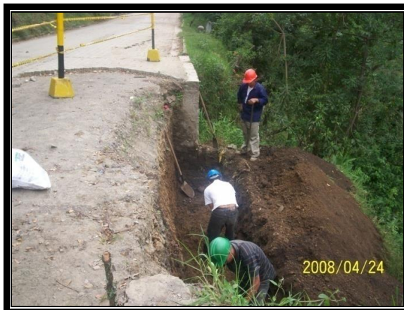
FOTO No 6, PR 65+0297 (SECTOR CEMENTERIO ENTRADA AL PUEBLO)
