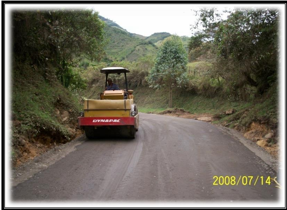
FOTO No24, COMPACTACIÓN SUB-BASE (PR 64+597)
