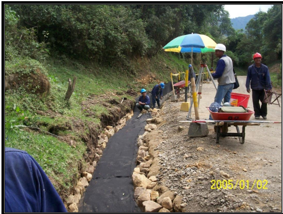
FOTO No25, CONSTRUCCIÓN DE 75 ML DE FILTRO (PR 64+570)
