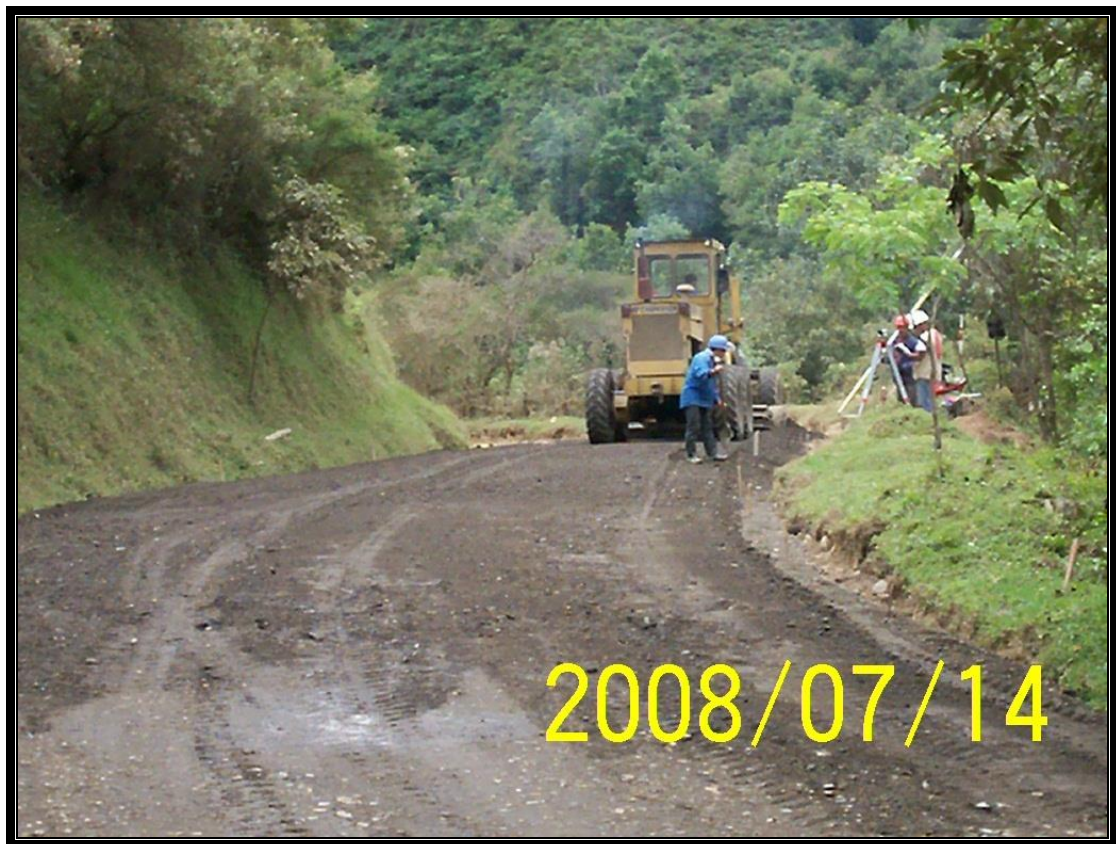
FOTO N°23, COLOCACIÓN Y EXTENDIDO DE SUB-BASE (PR 64+570)
