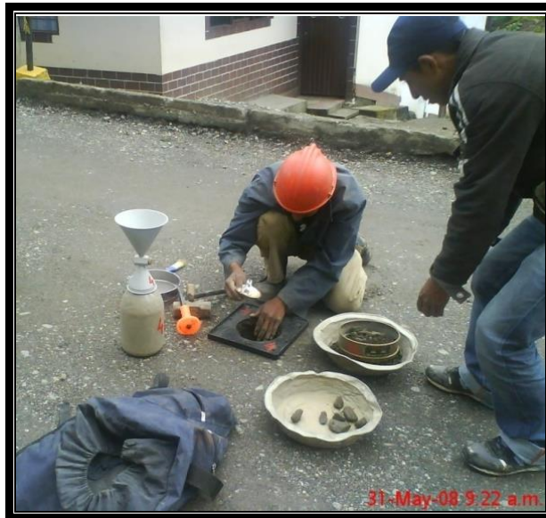
FOTO No 10, CHEQUEO DE DENSIDADES Y ESPESOR DE LA SUB-BASE (PR 66+0015)
