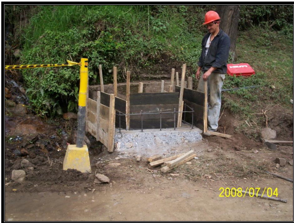
FOTO No22, REALCE DE ALCANTARILLA (PR 65+508.80)
