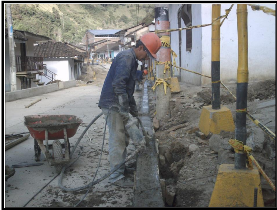
FOTO No21, CONSTRUCCIÓN DE SARDINELES (PR 66+0120)
