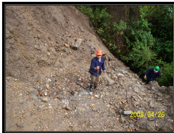
FOTO No 7, PR 64+0580 (EXCAVACIÓN PARA MURO EN GAVIONES)
