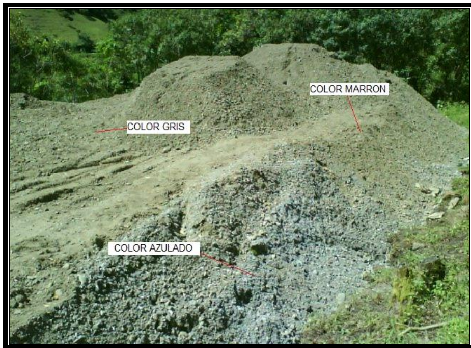
FOTO No 2, ACOPIO DE MATERIAL PROVENIENTE DEL RIO SAN JORGE (AL COSTADO IZQUIERDO DEL PR
