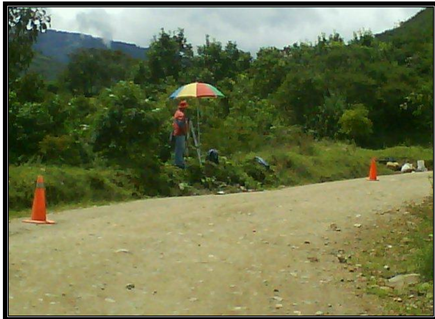
FOTO No 4, LOCALIZACIÓN Y NIVELACIÓN DEL EJE DE LA VIA (PR 64+0650)
