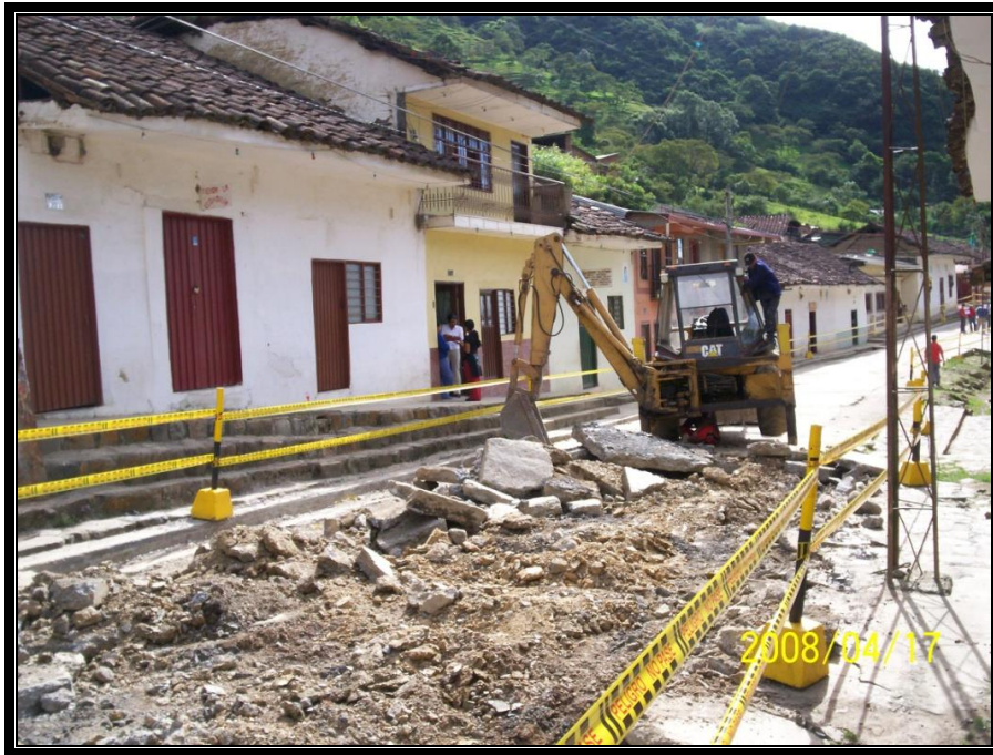
FOTO No 3, TRABAJOS DE DEMOLICIÓN DEL PAVIMENTO ANTIGUO (PR 66+0066)
