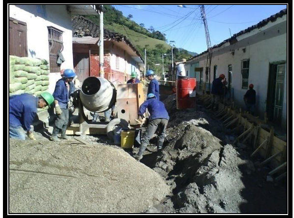
FOTOS No 17 Y 18, PREPARACIÓN DE FORMALETA PARA MURO EN CONCRETO CICLOPEO Y POSTERIOR UNDICIÓN (PR 66+0010)
