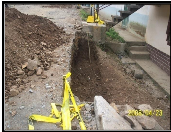
FOTO No 5, PR 66+0010(SECTOR CALLE PRINCIPAL)
