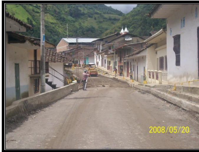
FOTO No 9, CONFORMACIÓN Y COMPACTACIÓN DE LA SUB-BASE (PR 66+0010)
