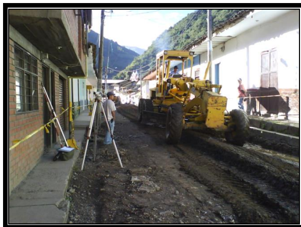
FOTO No 8, TRABAJOS DE CONFORMACION DE LA SUBRASANTE (PR 65+0920)
