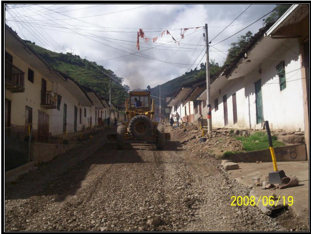
FOTO No 14, COLOCACIÓN Y EXTENDIDO DE LA SUB-BASE (PR 66 +0618)
