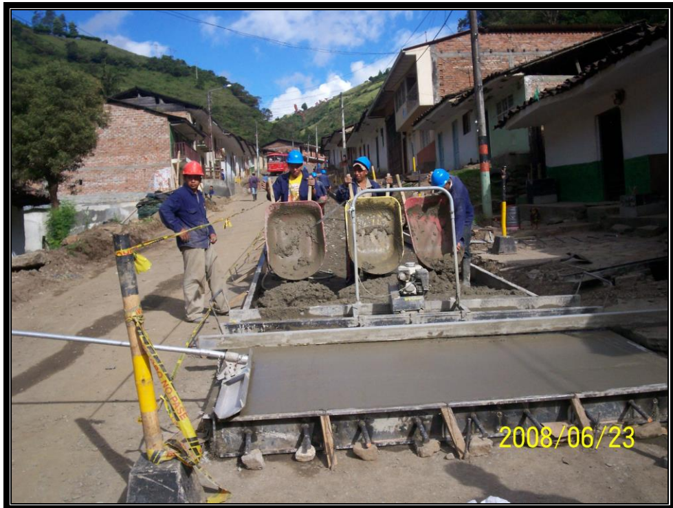
FOTO No20, CONSTRUCCIÓN DE PAVIMENTO (PR 66+0589)
