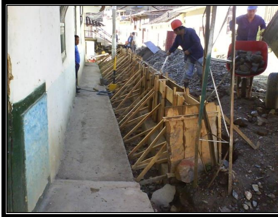
FOTOS No 17 Y 18, PREPARACIÓN DE FORMALETA PARA MURO EN CONCRETO CICLOPEO Y POSTERIOR UNDICIÓN (PR 66+0010)
