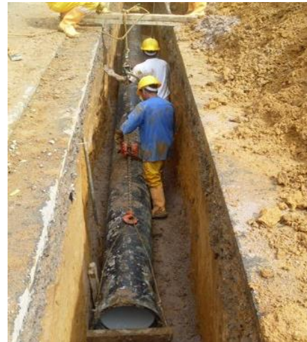
FOTO No 98. Apuntalamiento de tubería.
