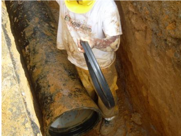
FOTO No 99. Anillo de caucho para empalme de tubería.
