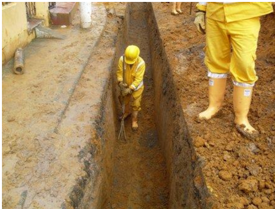
FOTO No 97. Cama base para instalación de tubería.
