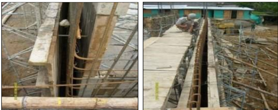
Figuras 26 y 27. Armado y atraque de formaletas.
