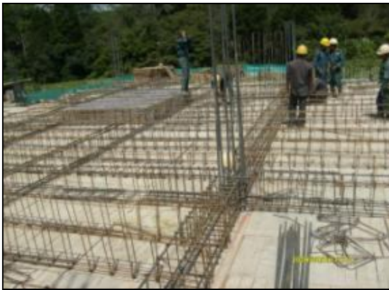
Figuras 50 y 51. Refuerzo para vigas y viguetas e instalación de casetones
