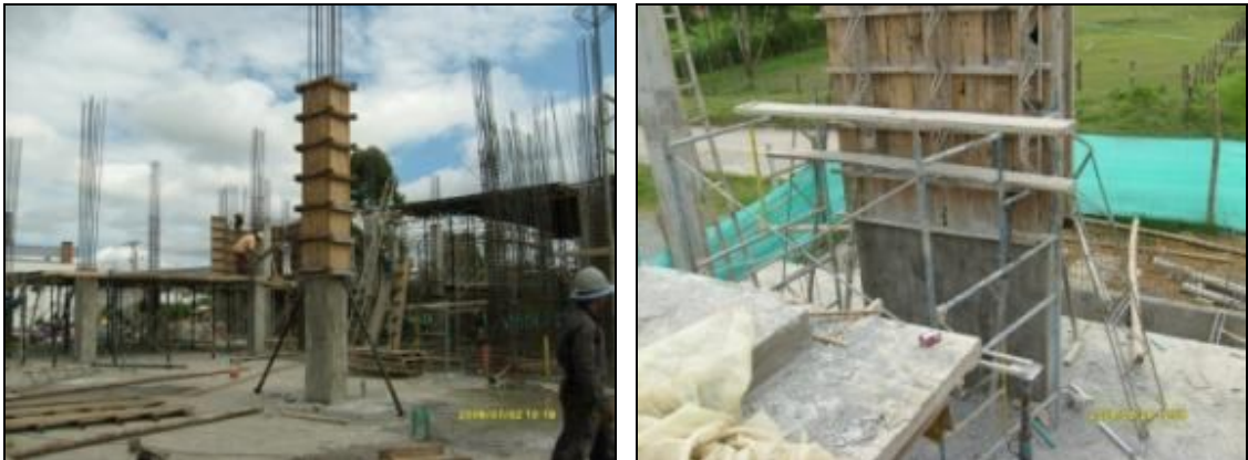
Figuras 40 y 41. Segunda etapa de la construcción de columnas y muros
