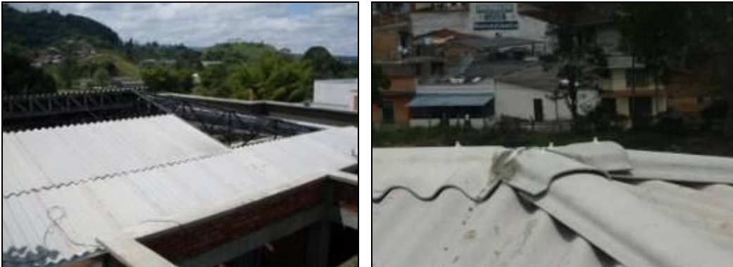
Figuras. 67 y 68. Instalación de placas onduladas y caballetes
