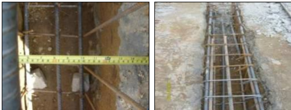
Figuras 7 y 8. Verificación de las dimensiones de la excavación.
