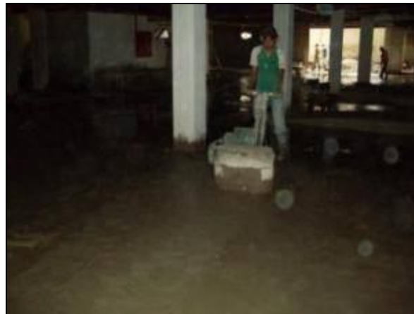
Figura 84. Afinado del piso en el parqueadero
