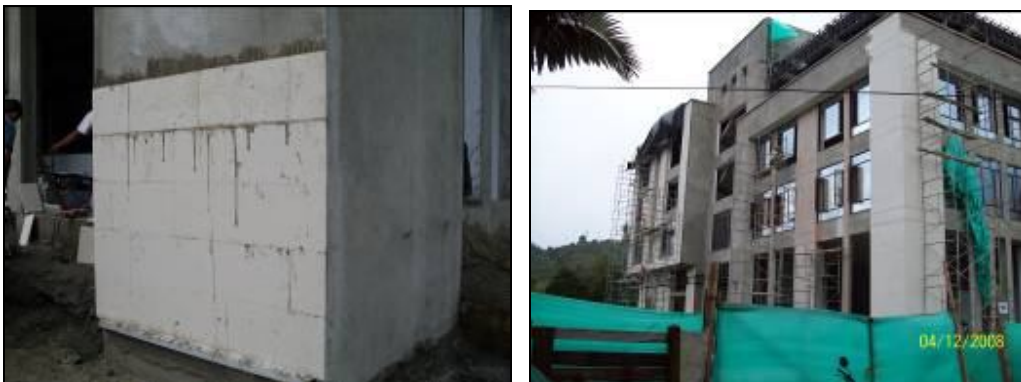
Figuras 100 y 101. Enchape de la fachada
