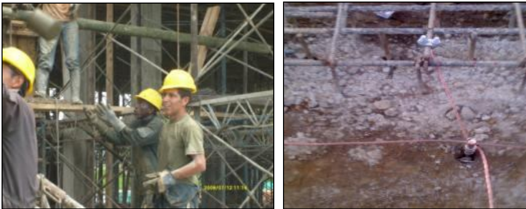
Figuras 102 y 103. Personal utilizando dotación de trabajo y línea polo a tierra
