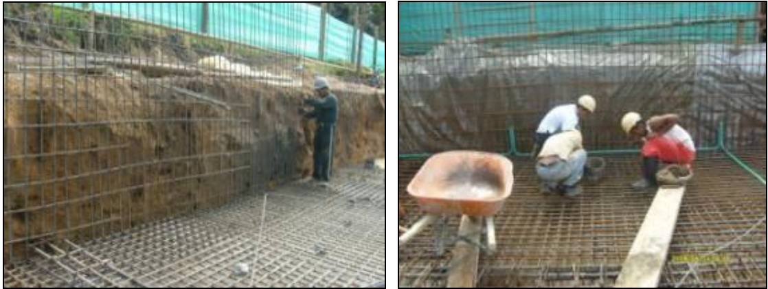
Figuras 24 y 25. Armado del refuerzo del muro e instalación del plástico de limpieza.
