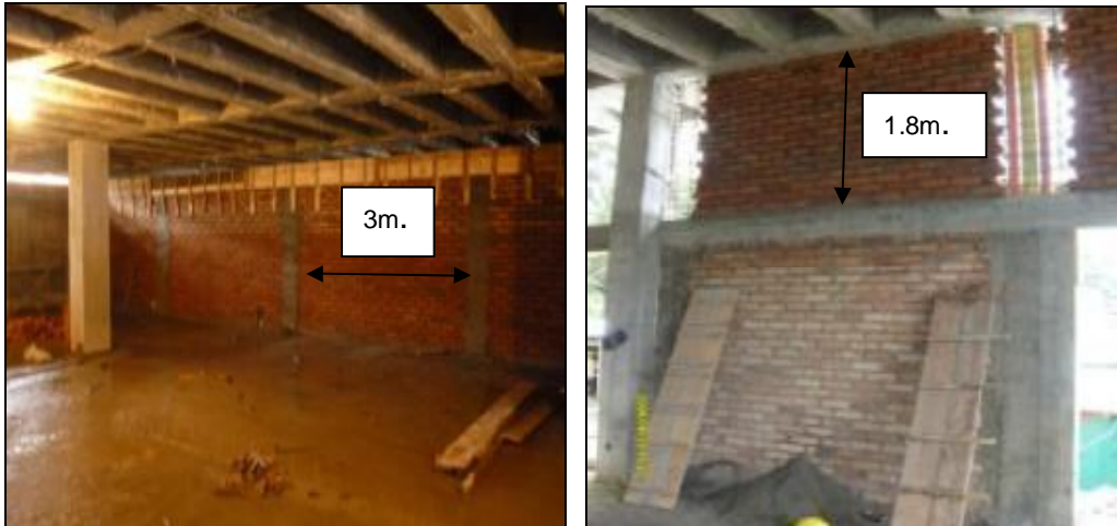
Figuras 76 y 77. Distancia entre columnetas y entre viguetas
