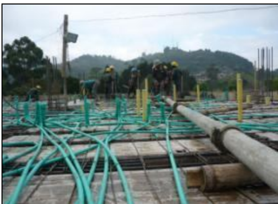
Figuras 52 y 53. Instalación de tubería para cableado eléctrico y fundición de losa
