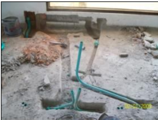
Figuras 86 y 87. Perforación de entresuelo y reconstrucción del mismo
