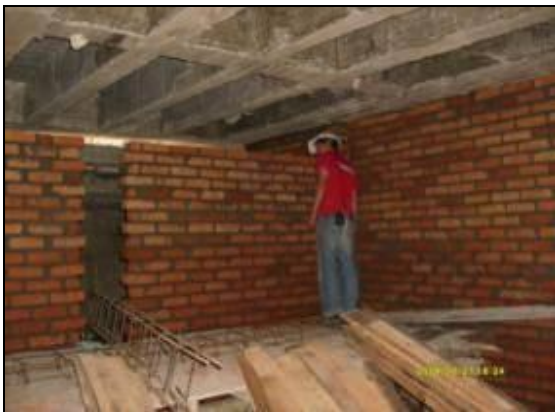
Figuras 74 y 75. Instalación de columnetas y viguetas
