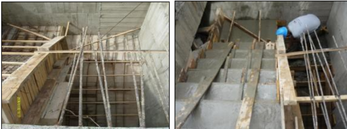
Figuras 60 y 61. Instalación de contramoldes y vaciado del concreto
