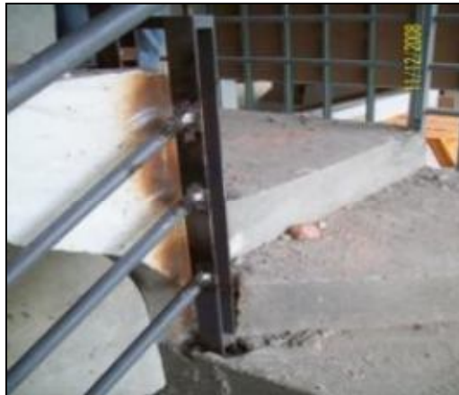
Figura 62. Perforación de las escaleras
