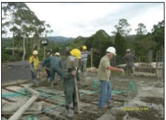
Figuras 52 y 53. Instalación de tubería para cableado eléctrico y fundición de losa
