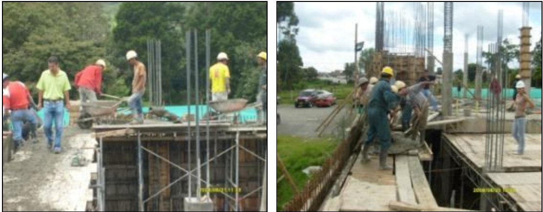
Figuras 28 y 29. Plataforma provisional y vertimiento del concreto
