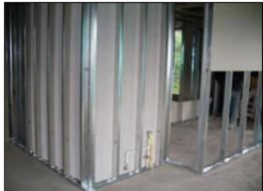
Figuras 88 y 89. Localización de muro e instalación de estructura metálica
