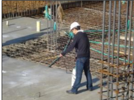
Figura 19. Aplicación de Antisol
