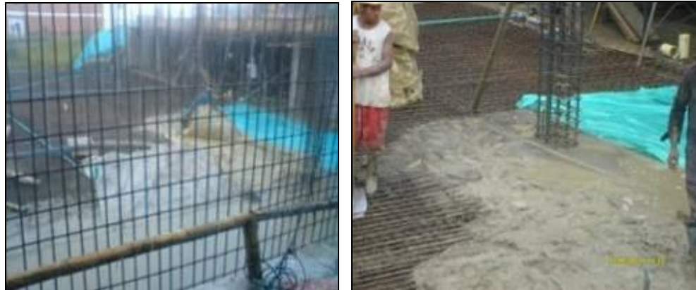
Figuras 20 y 21. Retraso de la obra por lluvias
