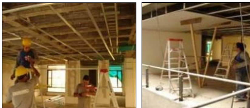
Figuras 92 y 93. Instalación de armaduras para cielo falso e instalación de placas de panel
