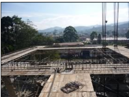
Figuras 63 y 64. Base de la viga y tapas laterales de la misma
