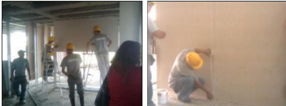
Figuras 90 y 91. Instalación de placas y sellado de juntas
