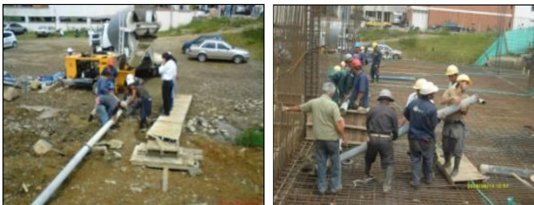
Figuras 22 y 23. Armado de tuberías y destape de las mismas.
