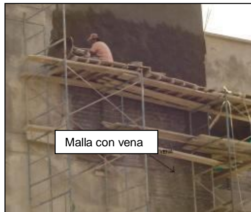
Figuras 82 y 83. Espesor de los repellos e instalación del refuerzo
