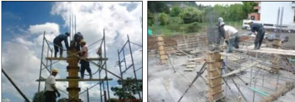
Figuras 36 y 37. Andamios y vaciado del concreto
