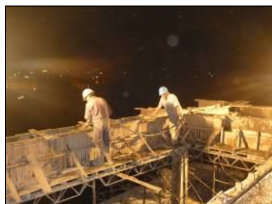
Figuras 63 y 64. Base de la viga y tapas laterales de la misma
