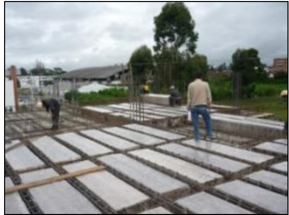
Figuras 50 y 51. Refuerzo para vigas y viguetas e instalación de casetones
