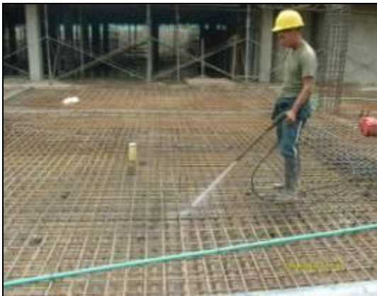
Figuras 12 y 13. Lavando la superficie antes de verter el concreto y prueba de Slump.
