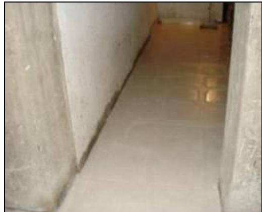
Figuras 96 y 97. Cuchillas en el enchape y corrección de las mismas
