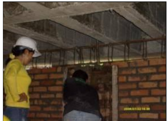
Figuras 74 y 75. Instalación de columnetas y viguetas
