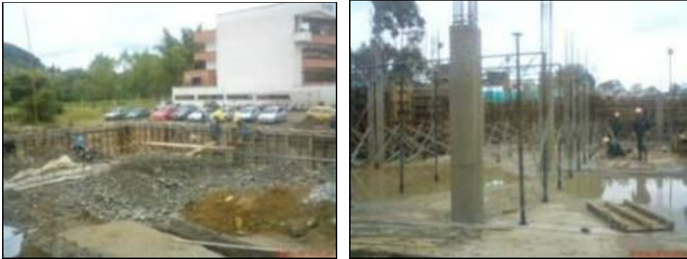
Figuras 1 y 2. Estado inicial de la construcción
