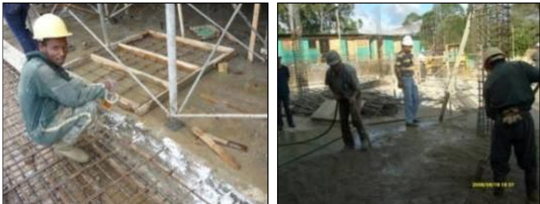
Figuras 15 y 16. Aplicación de epóxido y compactación del concreto
