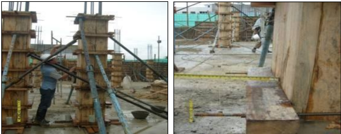
Figuras 38 y 39. Plomo de columnas
