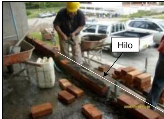
Figura 73. Verificación de la alineación y nivelación de la pega de ladrillo
