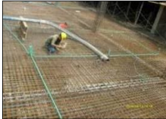
Figura 11. Instalación de tubería eléctrica.
