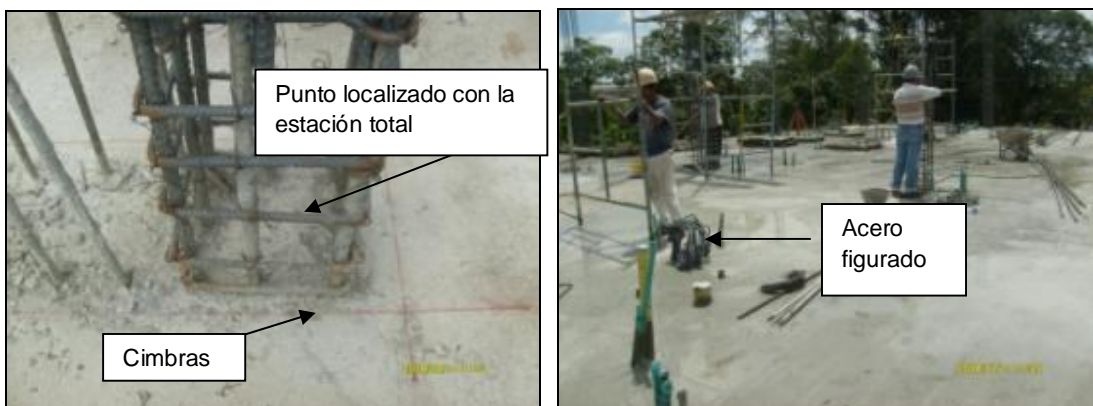
Figuras 34 y 35. Localización de las columnas y acero figurado
