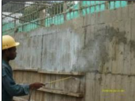
Figura 30. Aplicación de Antisol blanco
