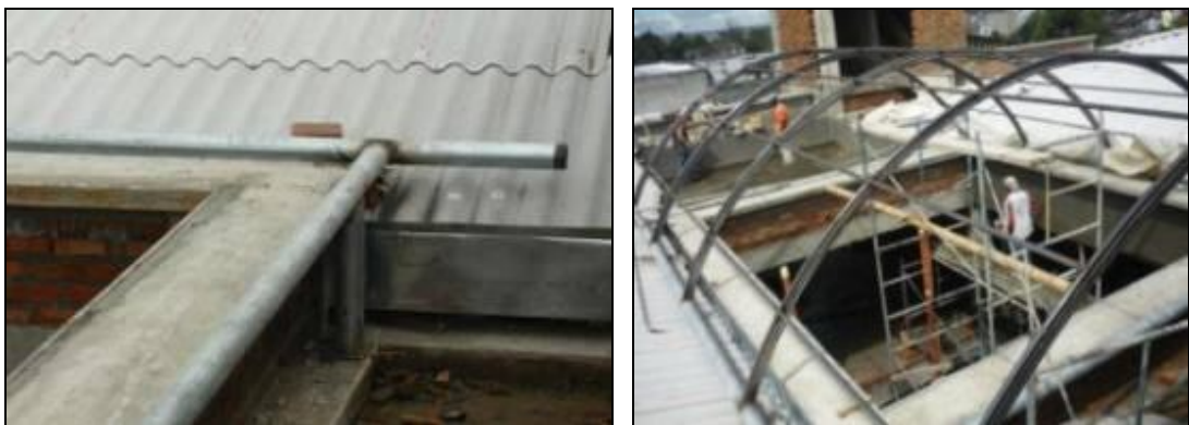
Figuras 69 y 70. Instalación de los soportes metálicos
