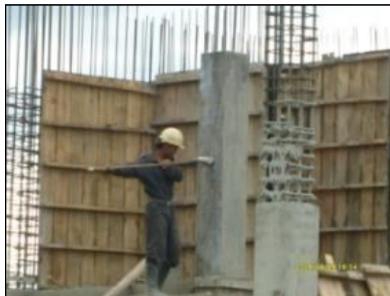
Figura 42. Curado de columnas
