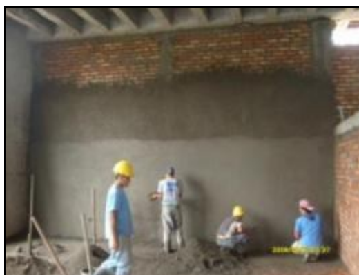
Figura 78. Aplicación del mortero y repello sobre el muro
