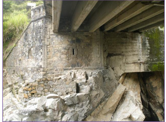
Foto 20. Subestructura Puente Río Esmita
