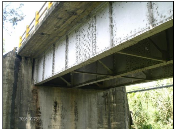
Foto 22. Puente Río Timbío
