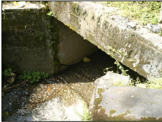
Foto 8. PR 94+0400. Box Coulvert
