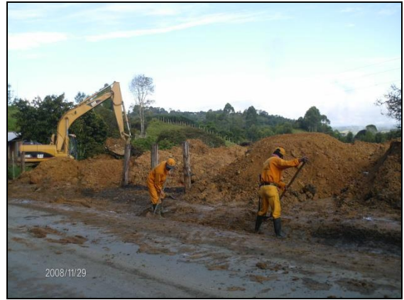
Foto 26. Limpieza y recuperación de cunetas colmatadas por derrumbes
