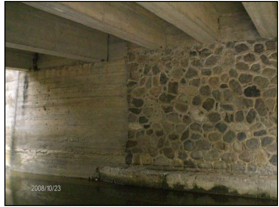
Foto 14. estribos y vigas.
