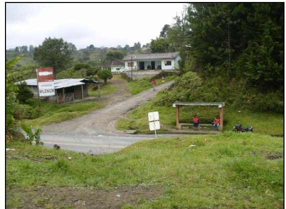
Foto 30. PR115+150 Solicitud puente peatonal
