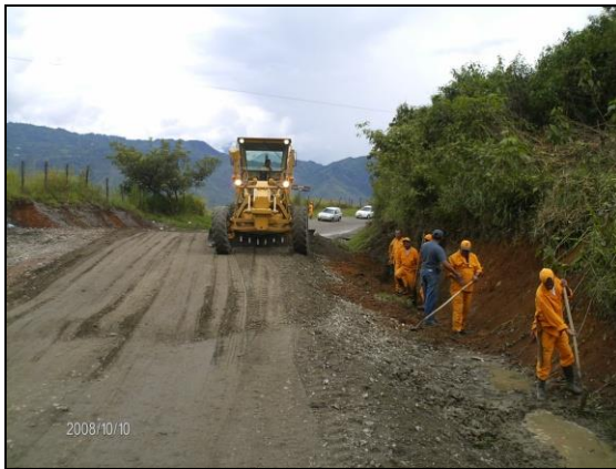
Foto 27. Recuperación de las condiciones de drenaje.
