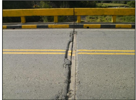
Foto 24. Las juntas se reflejan en la carpeta.
