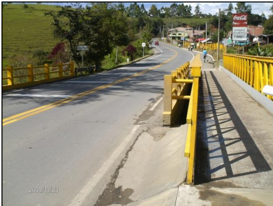
Foto 21. Puente Río Timbío
