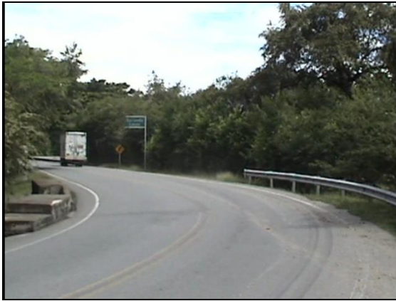
Foto 13. Puente Quebrada Marañón
