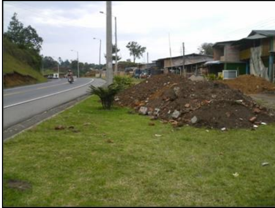
Foto 35. Invasión a la zona de Derecho de Vía. PR 1+0280, VARIANTE DE POPAYAN.
