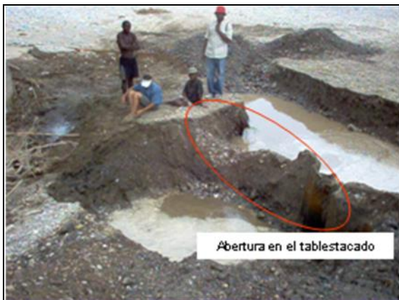
Foto 17. Abertura del Tablestacado – Pila Norte, Puente DOS RIOS
