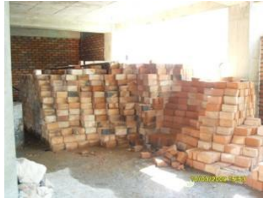
Almacenamiento ladrillo tolete común
