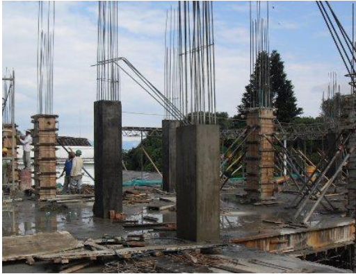
para ménsula anclado en columna.
