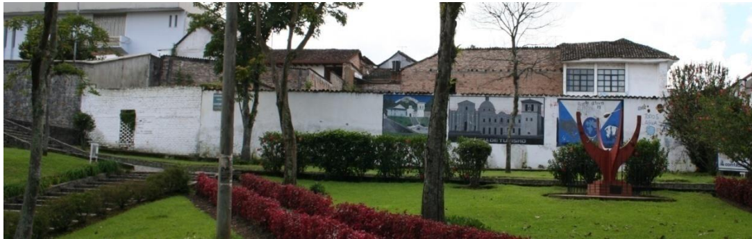
Muros en ladrillo hacia parque Julio Arboleda.
