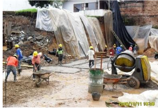
Mezcladora para elaboración de concreto.
