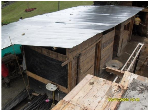
Vestier y baños.
