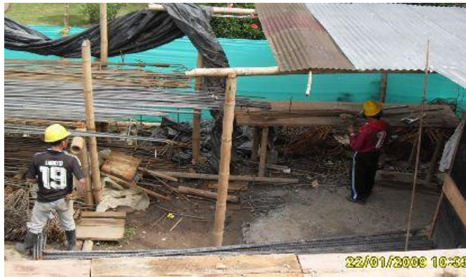
Mesa para flejado en obra.
