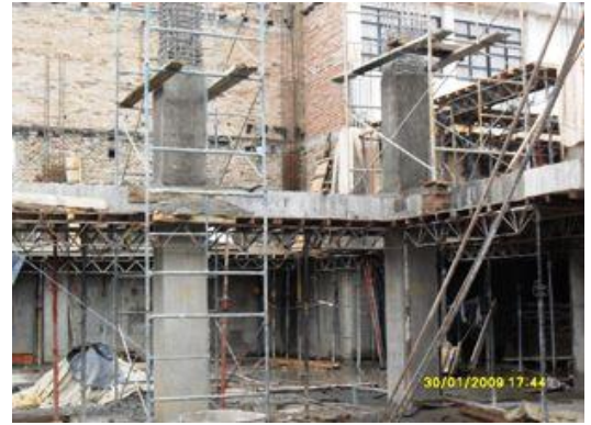
Columnas E-7 y E-8.
