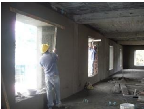
Repello de muros mortero 1:3
