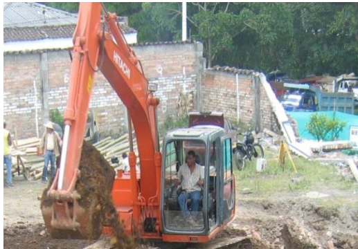
Demolición de muros con excavadora
