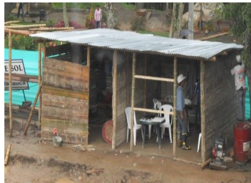
Oficina de Ingeniería.
