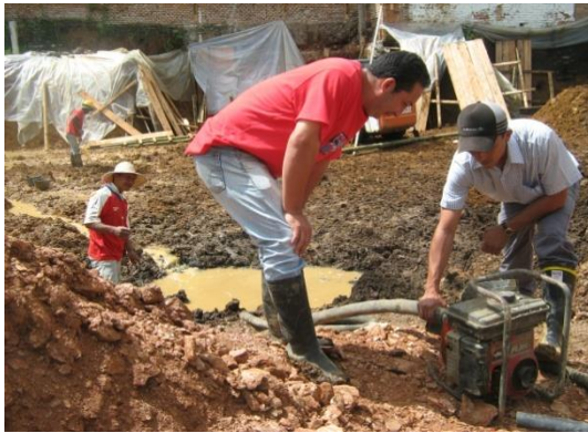
Evacuando inundación con motobomba.
