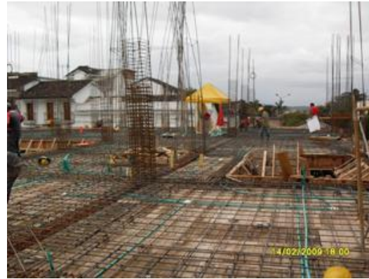
Amarre acero losa nivel +6.30.
