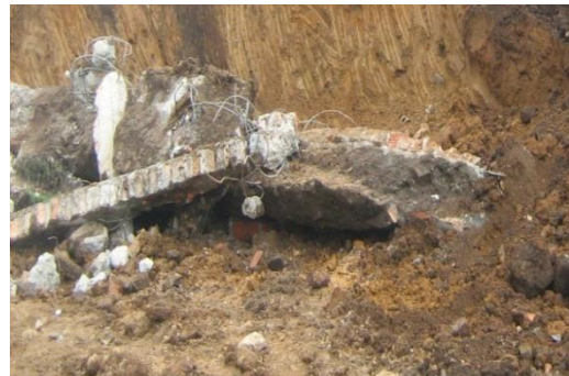
Demolición de viga de cimentación con excavadora esta fue enterrada en el lote de la construcción
