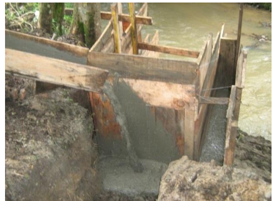
Fundición del cabezal
