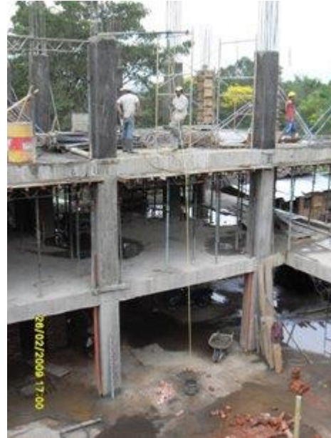
Columnas primer, segundo y tercer nivel.
