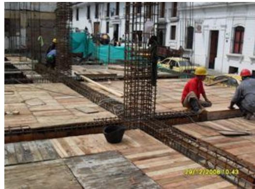
Entablerado para placa.
