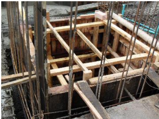
Encofrado para pantallas ascensor.
