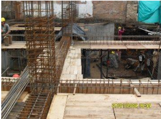
Refuerzo vigas aéreas.
