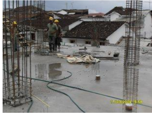
Losa de entrepiso nivel +9.45.
