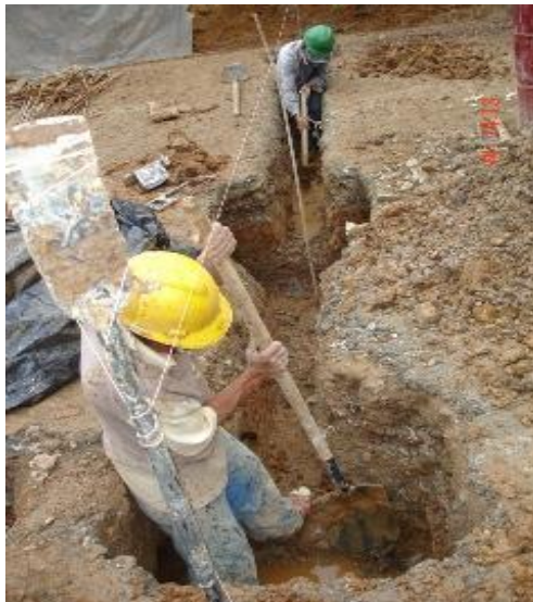
Excavación manual de material común, con presencia de rocas de tamaño considerable
