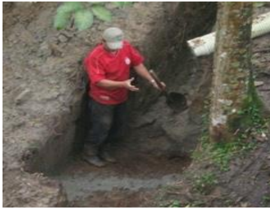
Excavacion manual
