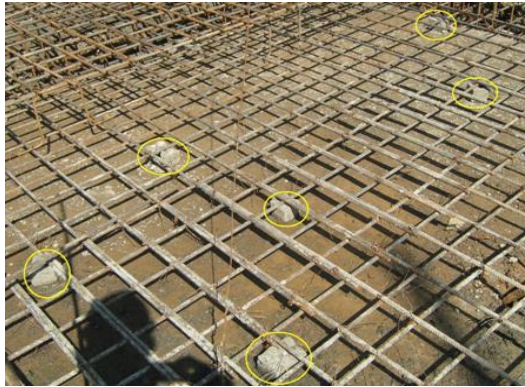
Panelas para garantizar recubrimiento.
