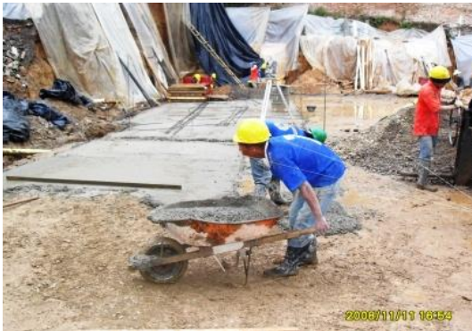
Carreteo de la mezcla.
