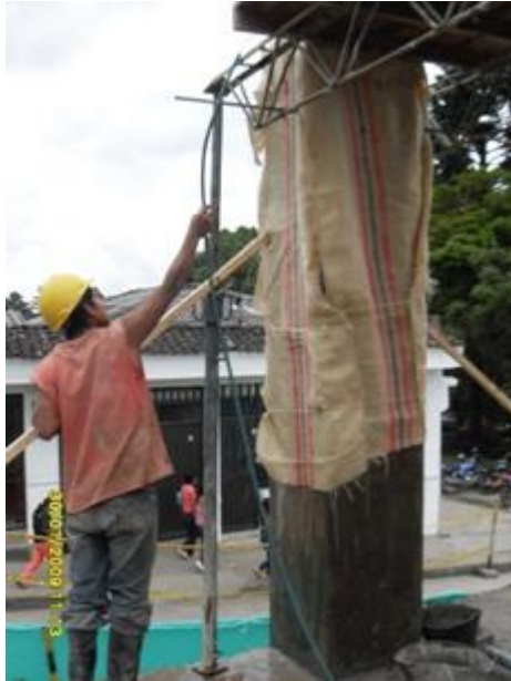
Riego de agua y costal para curado de ccto.
