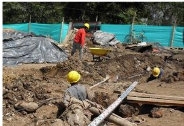
Excavación manual de material común, con presencia de rocas de tamaño considerable
