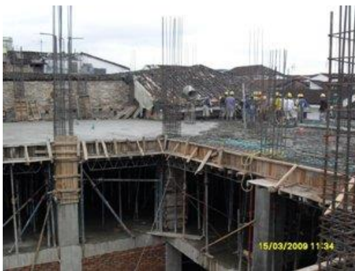
Fundición losa nivel +9.45.
