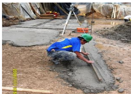
Tallado del solado con codal.
