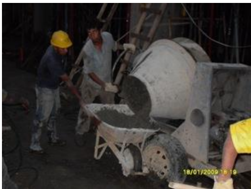
Elaboración de concreto para losa.
