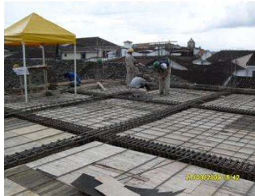
Acero de refuerzo nivel +12.60.
