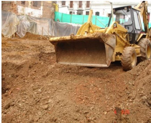
Riego de material con retroexcavadora
