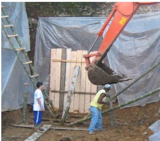
Guadua enterrada por maquina.
