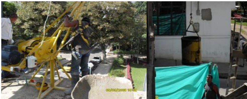
Pluma y balde para elevación de concreto
