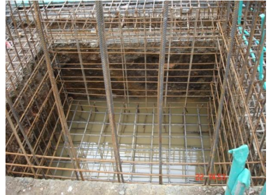
Acero de refuerzo foso ascensor.
