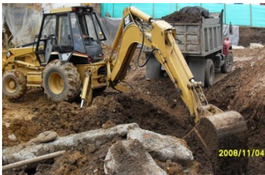
Demolición de viga de cimentación con excavadora esta fue enterrada en el lote de la construcción
