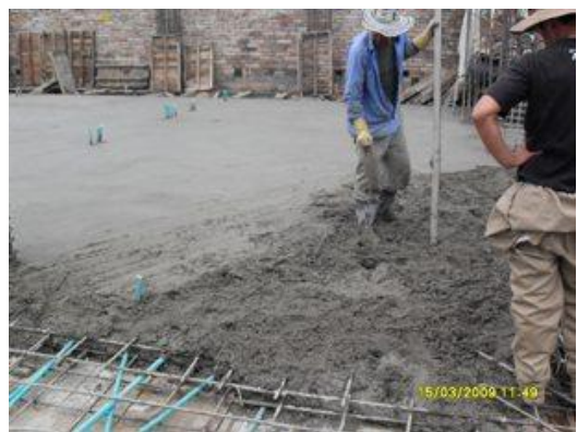
Fundición losa nivel +9.45.
