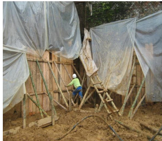
Entibado y apuntalamiento de taludes.
