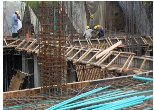
Formaleta vigas aéreas.
