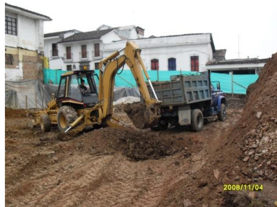
Retiro del material debido a fallos
