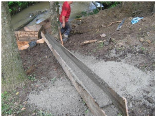
Canal para conducción de concreto
