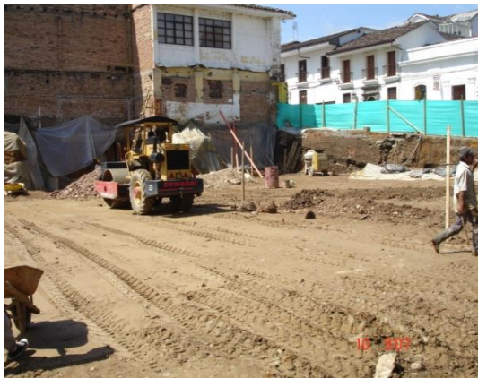
Compactación con vibro-compactador
