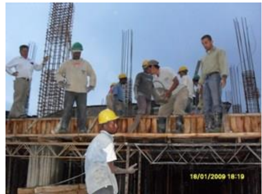
Vaciado de concreto preparado en obra.
