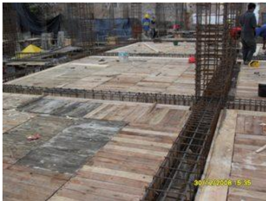
Entablerado para placa.
