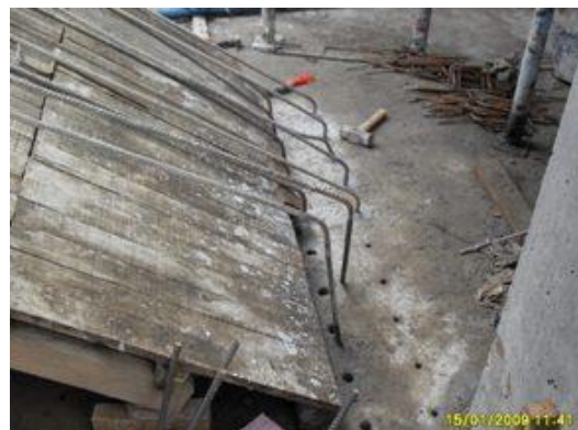
Acero anclado en losa de cimentación
