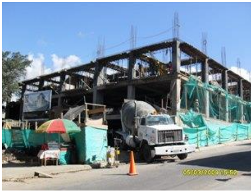
Armado de entablado para losa nivel +9.45.
