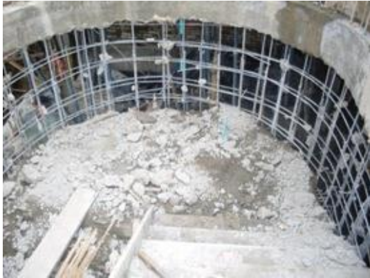
Demolición de pantalla
