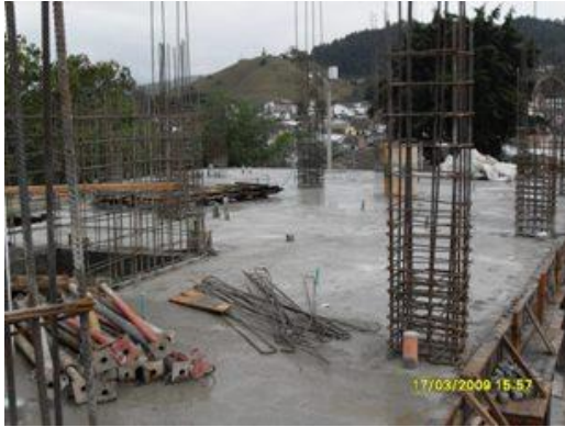
Losa de entrepiso nivel +9.45.
