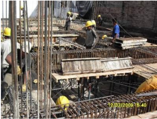
Refuerzo vigas secc. 40*70 nivel +6.30.
