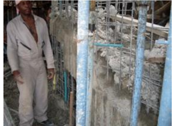
Demolición de pantalla
