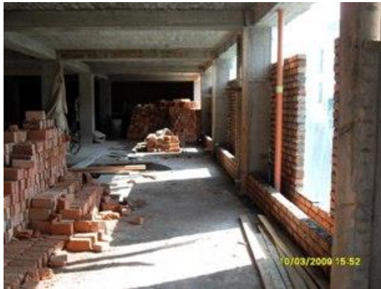
Almacenamiento ladrillo tolete común
