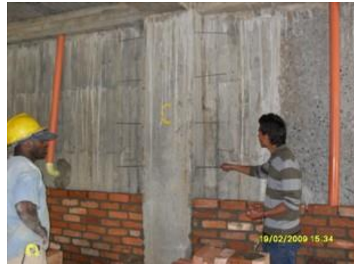
Anclajes para muro.
