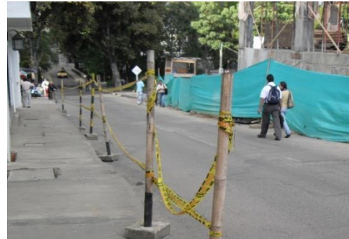
Cerramiento y señalización carrera séptima
