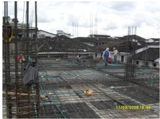
Acero de refuerzo losa nivel +9.45.
