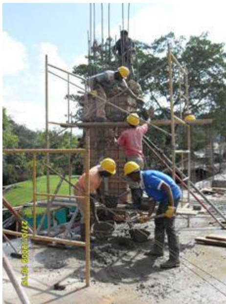
Vaciado de concreto con balde.
