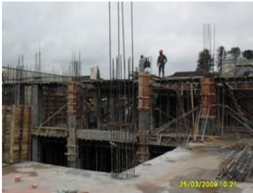
Elevación de entablado para losa nivel +12.60.
