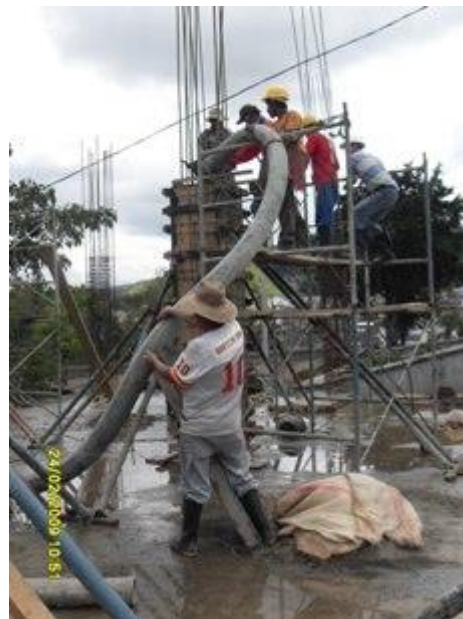
Vaciado de concreto con trompa de elefante.
