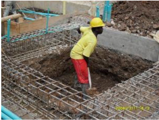
Excavacion manual recorrido (-) ascensor.
