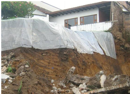
Talud 60° de inclinación costado oriental.
