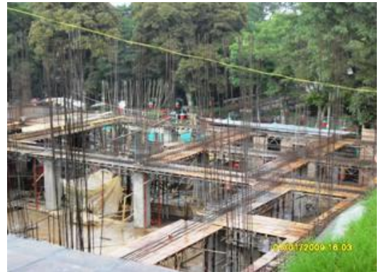
Refuerzo vigas aéreas.
