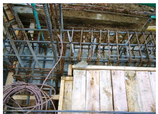
Acero de vigas penetrando columna.
