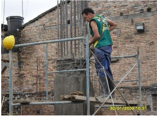
Demolición columna E-8.
