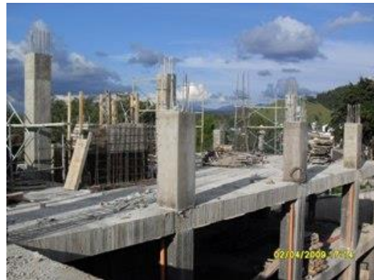
Columnas cuarto nivel (para cubierta).
