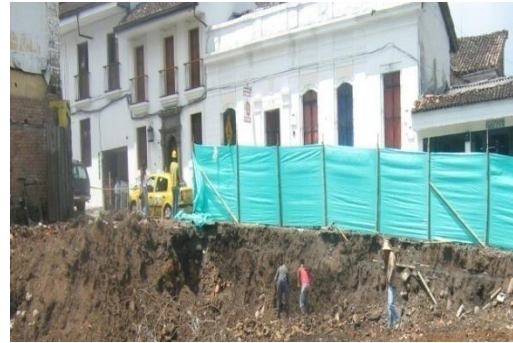
Cerramiento lindero carrera séptima.
