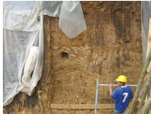
Nylon para perfilar talud costado sur.
