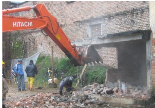
Demolición de caseta con excavadora
